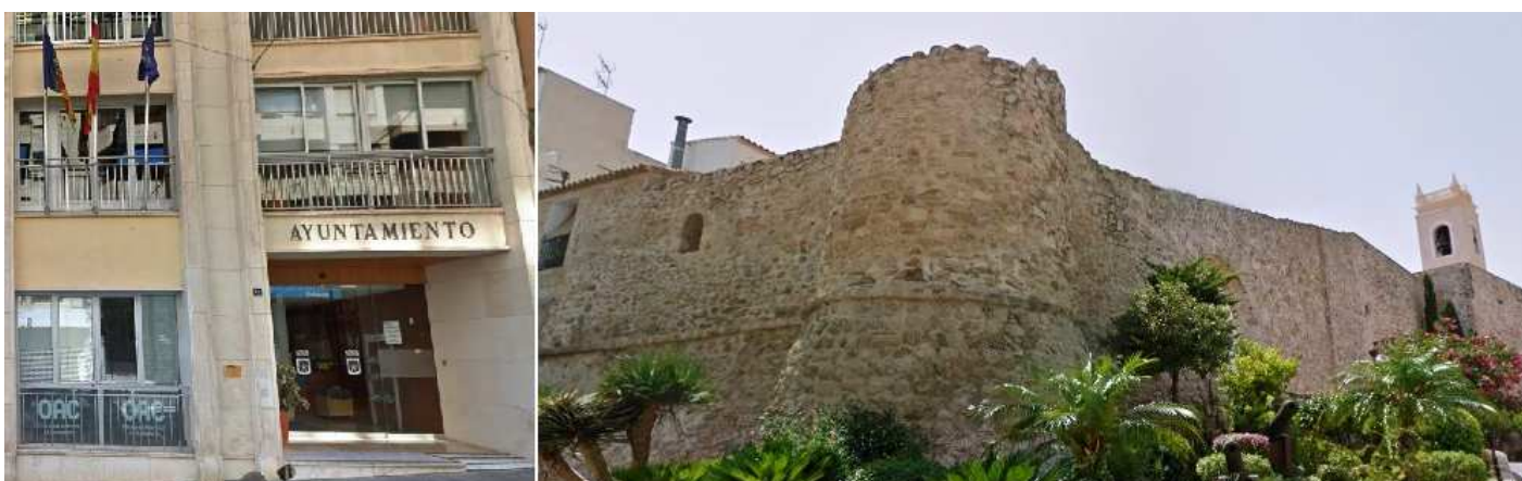
1 Ayuntamiento en la avenida de Ifach, 12. 2 Cubo y restos de la muralla (que protegió a Calpe de los ataques de los musulmanes) al inicio de la calle Reverendo Antonio Peña, con la torre de la iglesia al fondo.
