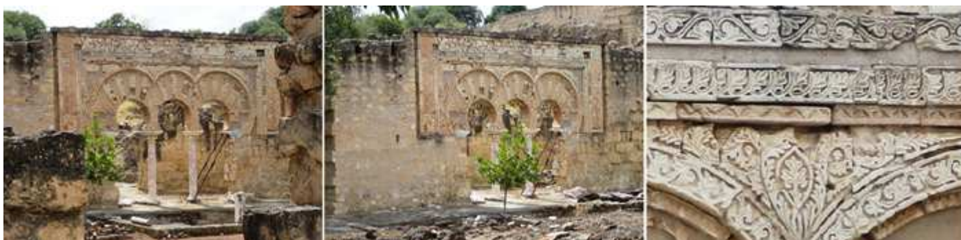
❶ Fachada del Salón Oriental de la Casa de la Alberca. ❷ A los lados del patio se abren estas fachadas de triple arquería. ❸ Motivos decorativos de la parte superior de los arcos. Esta es única casa que disponía de jardín privado.
