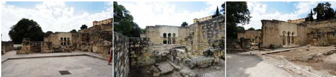
❶ Tras este patio uno de los bloques de la casa de la Alberca. ❷ Uno de los bloques con una triple arcada de herradura. ❸ En esta imagen se aprecia las dos construcciones con sendas portadas con tres arcos. A la derecha queda algún trozo de muro pintado.
