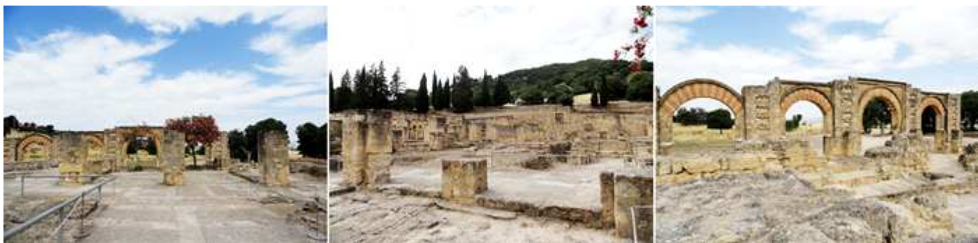
❶ Los arcos del gran pórtico. ❷ A la izquierda dependencias sin carteles informativos. ❸ Arcadas ligeramente rebajadas, salvo la central.
