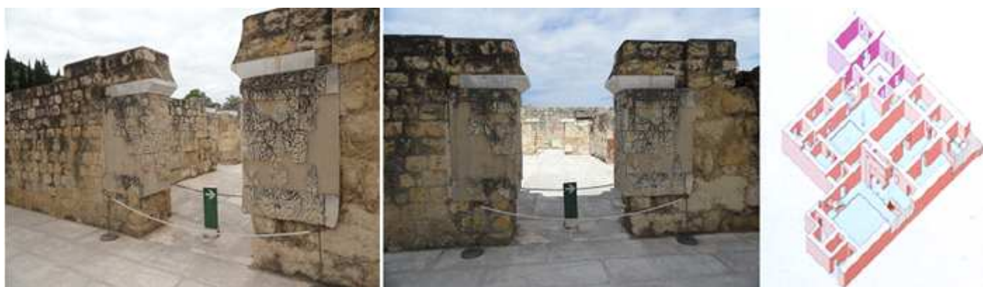
1 Tras la galería de los arcos dispone de tres naves longitudinales. 2 Perpendiculares a la fachada. 3 Perspectiva de las estancias de la casa del visir Ya'Far.
