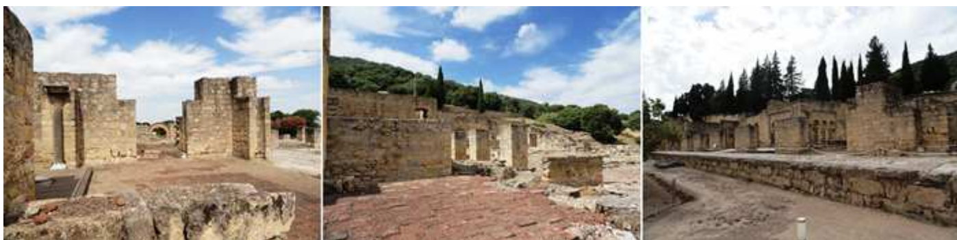
❶ Al fondo de forma perpendicular se encuentra el Gran Pórtico. ❷ Detalle de un espacio que permanece sus suelos de ladrillo original. ❸ Parte de calle en rampa.
