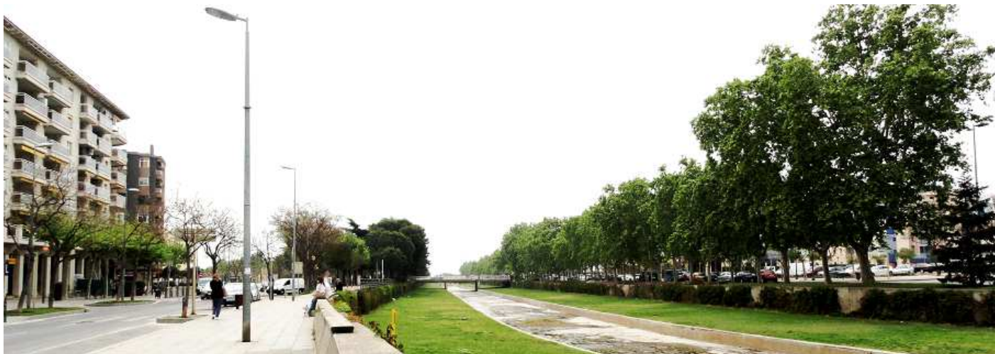
➊ Riera de la Alforja que conecta con grandes vías la zona de playa con el núcleo urbano y el casco antiguo.
