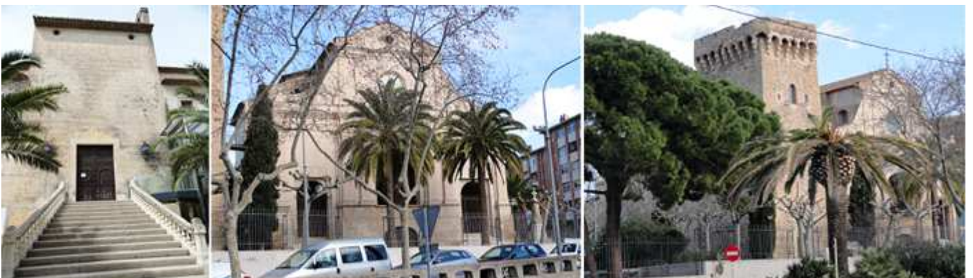
❶ Escalita de la puerta existente en el lado epistolar. ❷ Fachada del templo ante la avenida. ❸ El conjunto dispone de una verja.
