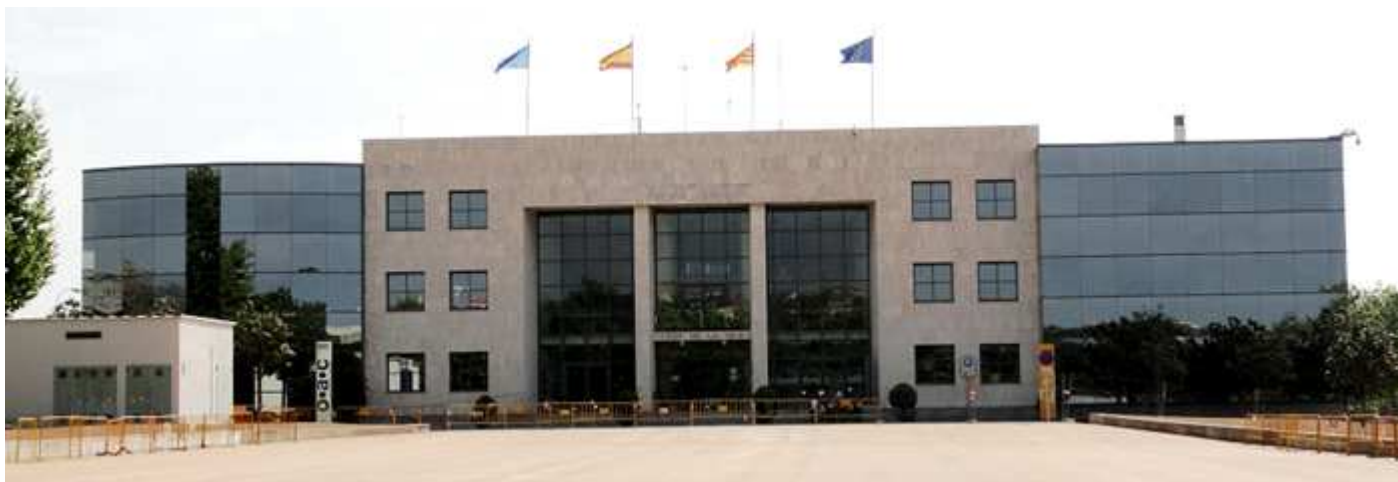
❶ Fachada del Ayuntamiento ante una gran zona con espacios abiertos.
