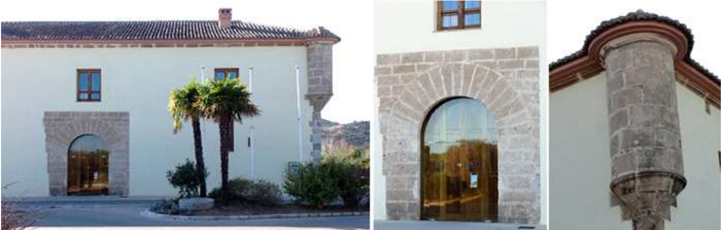
❶ Asegurase si está abierto en la Oficina de Turismo antes de ir. ❷ Puerta original dotada con dovelas lisas y de medio punto. ❸ En su exterior está dotada de tres troneras y una torre vigía.
