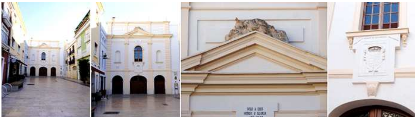
1 Plaza del Beato. 2 Fachada de la iglesia del convento de San Roque. 3 Frontis de la fachada. 4 Escudo con la fecha de 1581.
