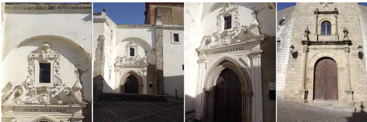
1 Puerta del lado del Evangelio que está parcialmente soterrada con el nivel de la calle 2 A la que se desciende por unas escaleras. 3 Puerta de arco apuntado con dos arquivoltas con la inscripción del año 1792 sobre el arco. 4 Y la puerta sobre la nave central.
