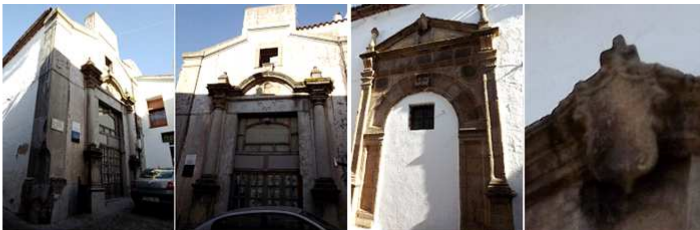
❶ Templo que parece abandonado. ❷ Con una puerta adintelada con pilastras. ❸ Puerta lateral cegada ❹ Escudo de esta puerta.
