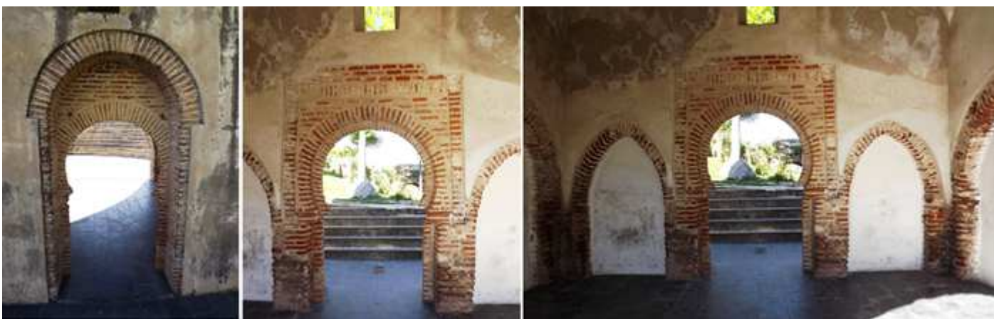
❶ Puerta en la parte posterior con un arco de herradura. ❷ Vista por su interior ❸ Con dos arcos apuntados a sus lados hoy cegados.
