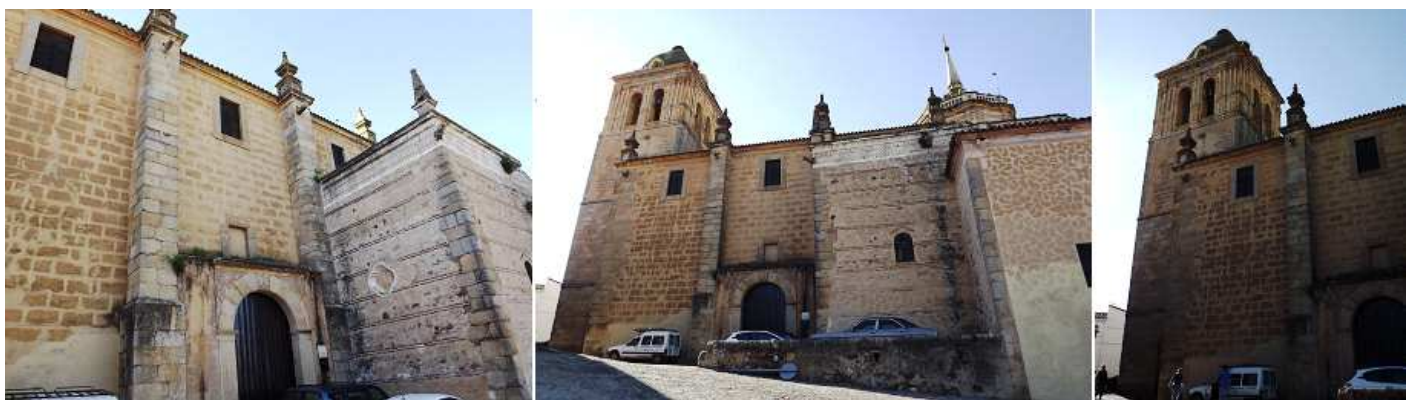
1 Lateral epistolar con su puerta. 2 Este lateral del templo marcado con un fuerte desnivel. 3 A los pies del templo en su lado de la Epístola cuenta con su torre de planta cuadrada.
