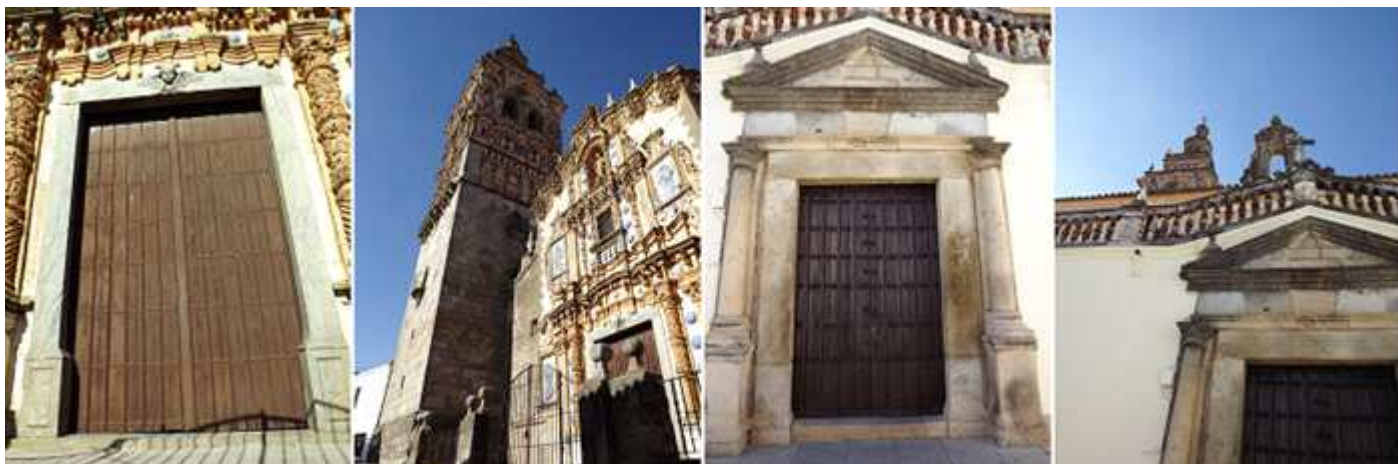
❶ Puerta principal. ❷ Detalle de la torre adosada a los pies de su fachada principal. ❸ Puerta del lado de la Epístola, adintelada y con columnas corintias adosadas so pódium. ❹ En este lateral tiene una espadaña de un solo vano.
