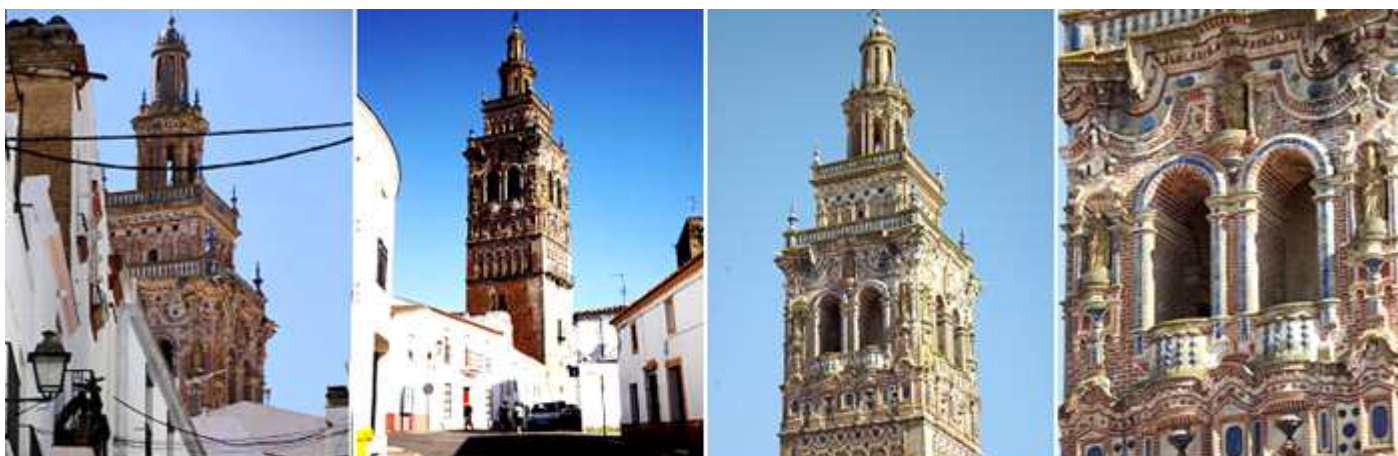
1 Entre el caserío se distingue ya su atractiva torre. 2 Torre levada posteriormente al templo en 1759. 3 La exuberante decoración de la parte de su campanario es a base de ladrillo, yeso y cerámicas de colores. 4 Con dos ventanas en cada lado con forma de balconillos. Sobre los arcos están algunos santos
