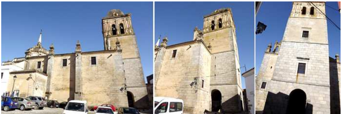
1 Lateral exterior del Evangelio de Santa María. 2 m. 3 Su torre ante el hastial. 4 Su torre se alza sobre un pórtico de arcos de medio punto a los pies del templo, se compone de cuatro cuerpos separados por impostas corridas.
