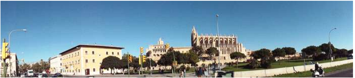
❶ A la izquierda y de forma perpendicular el Paseo del Borne, el edificio de la Aduana y el palacio y la Seo.
