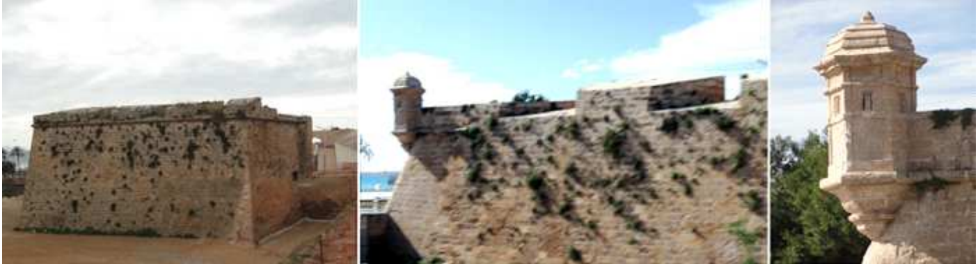
1 Lado lateral del baluarte perpendicular a la avenida. 2 Esquina del lienzo paralelo a la avda. Gabriel Alomar. 3 Garita.
