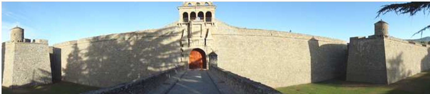
❶ Panorámica de su fachada principal protegida por dos baluartes provistos de garitas circulares.
