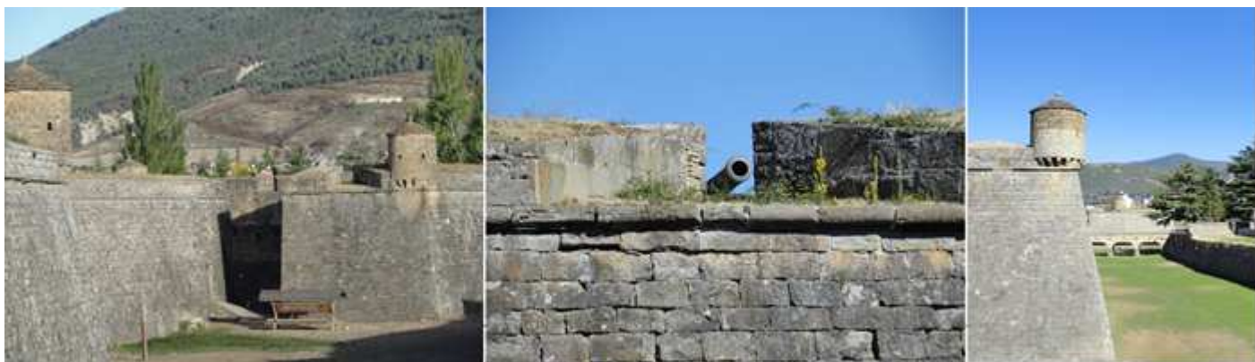
❶ Detalle del espacio que se producía con los baluartes que se separan del perímetro pentagonal. ❷ Uno de los cañones alojados en una tronera. ❸ Perspectiva de la anchura del foso que recorre toda la ciudadela. Donde suelen pastar algunos ciervos.
