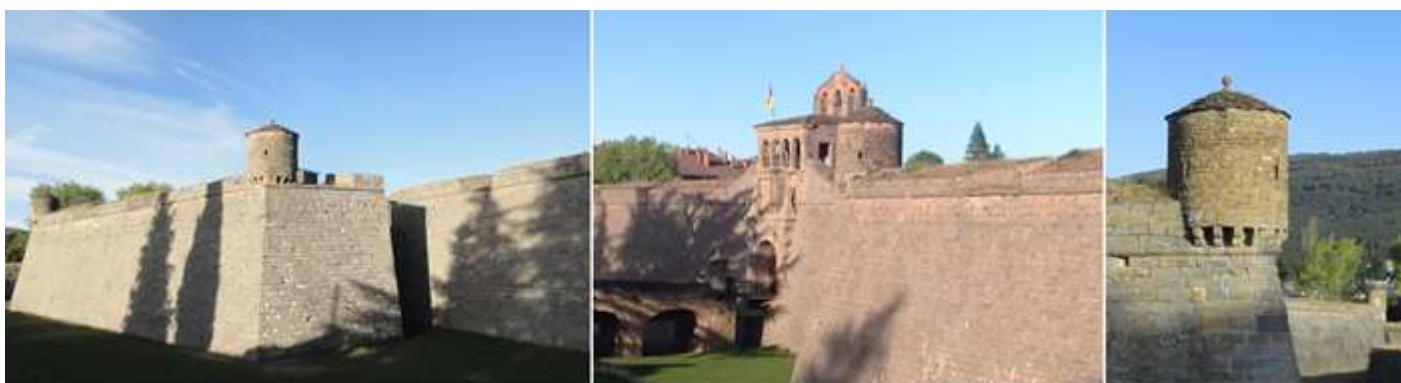
❶ Baluarte de la izquierda con recodo. ❷ El puente que su último tramos era elevadizo para quedar incomunicada la ciudadela. ❸ Carita del baluarte derecho de esta parte frontal.
