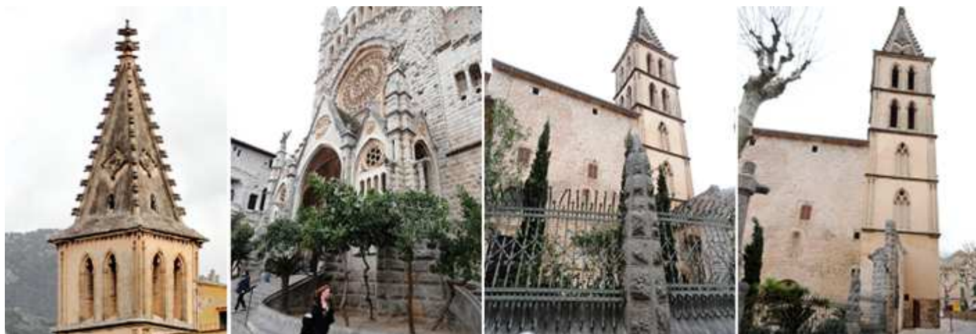
❶ Su campanario esta coronado con tejado con decoración y sus ángulos están con crestería. ❷ Su atrio o pórtico esta adelantado a la fachada. ❸ Lateral de la Epístola. A la derecha la puerta del Fuerte. ❹ Su campanario neo gótico de planta cuadrada con cinco cuerpos y los dos últimos con dobles ventanas para sus campanas. En su primer cuerpo dispone de una bóveda de crucería S. XIV.
