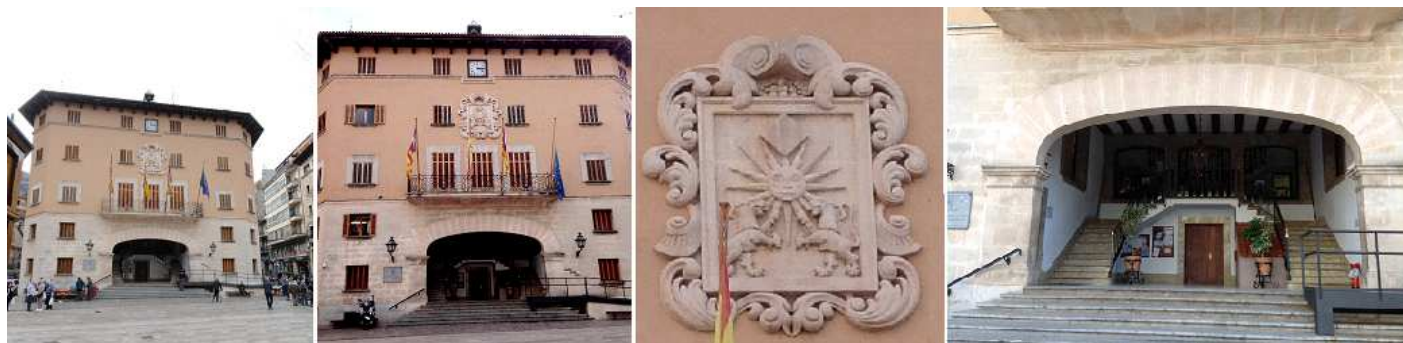
1 Fachada con la parte inferior de la misma ejecutada con piedra sillar. 2 Es un enorme caserón de planta irregular con un patio rectangular en su interior. 3 Relieve del escudo sobre la fachada. 4 Detalle del arco de su pórtico.
