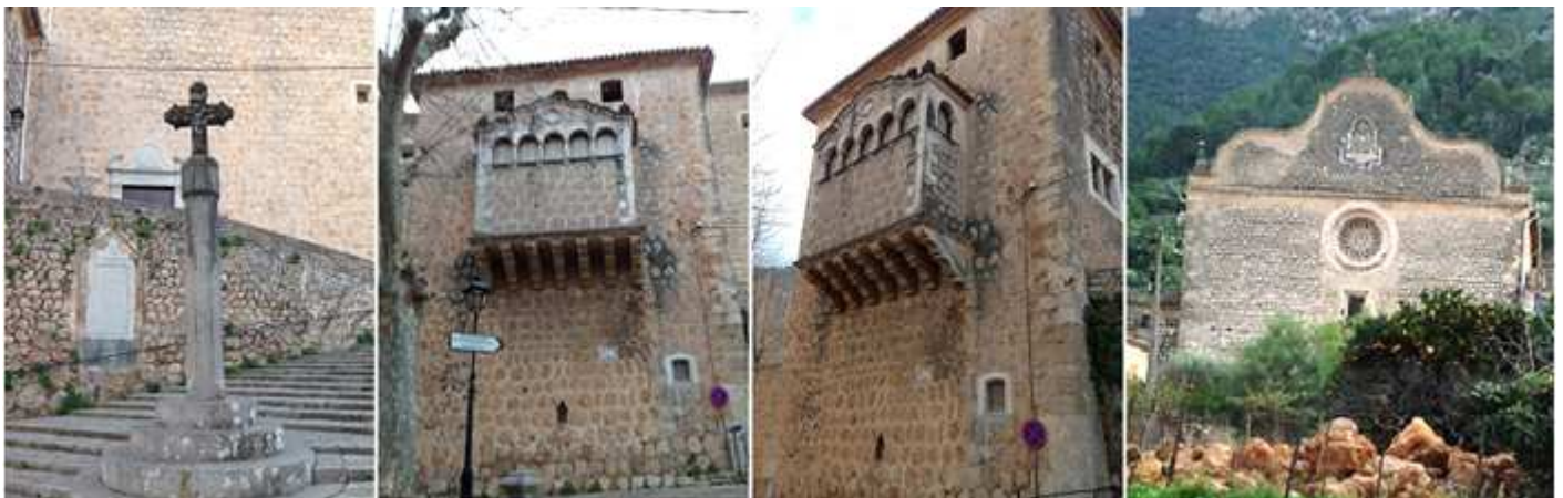
❶ Ante las escaleras del convento en la plaza de Francesc Salto se encuentra esta cruz de Término o crucero ❷ Lateral del templo con esta galería volada. ❸ En el lado del Evangelio. ❹ Fachada de la iglesia con una puerta adintelada y un gran rosetón, ante la misma está el patio del colegio.
