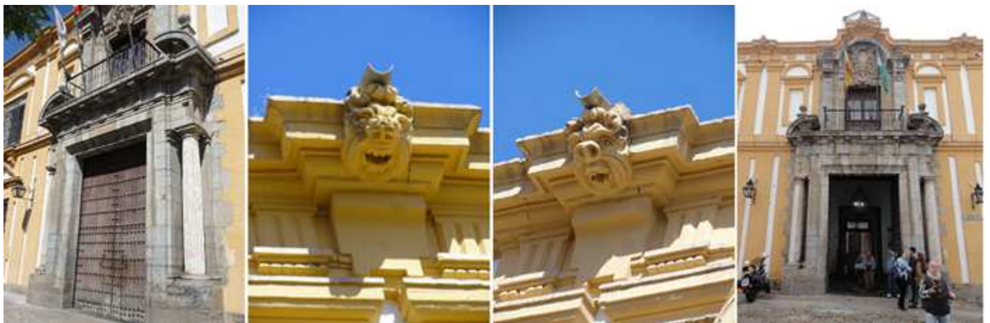
1 Portada con columnas a sus lados y un gran balcón sobre el entablamento. 2 Figuras grutescas sobre la parte superior de la fachada. 3 Otra con otro animal distinto. 4 Su puerta adintelada y a los lados de la misma columnas sobre pódium.
