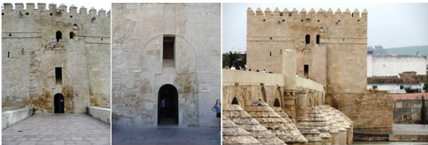
1 Prácticamente el puente desemboca en la propia torre. 2 Su puerta de entrada, que sobre la construcción se vislumbra un arco de herradura. 3 Los tajamares del puente romano y la construcción de la torre.
