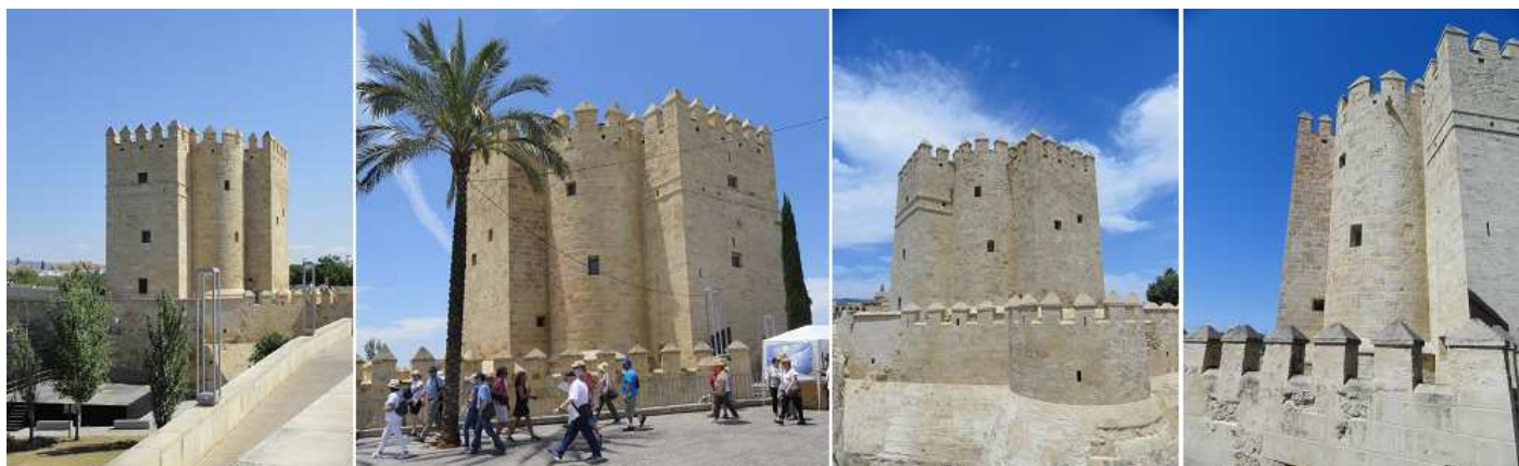
1 Viniendo por la Avenida de Fray Albino. Es una opción de aparcar en las calles de este lado del puente. 2 Parte posterior de la torre a esta avenida. 3 Dispone de un perímetro de murallas con sendos taludes que lo elevan de la parte baja de la ribera. 4 Detalle de la torre cilíndrica en este ángulo. Su aspecto actual data del S. XIV.
