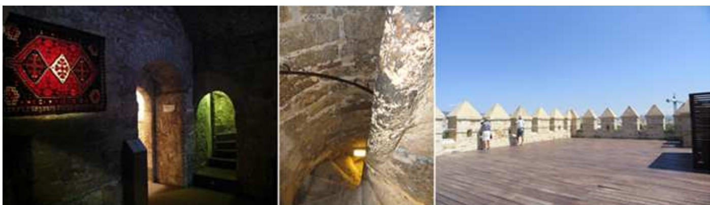
❶ Acceso a la azotea del la torre. ❷ Con una escalera de Caracol. ❸ Su terraza almenada que da la oportunidad de unas vistas en 360°.
