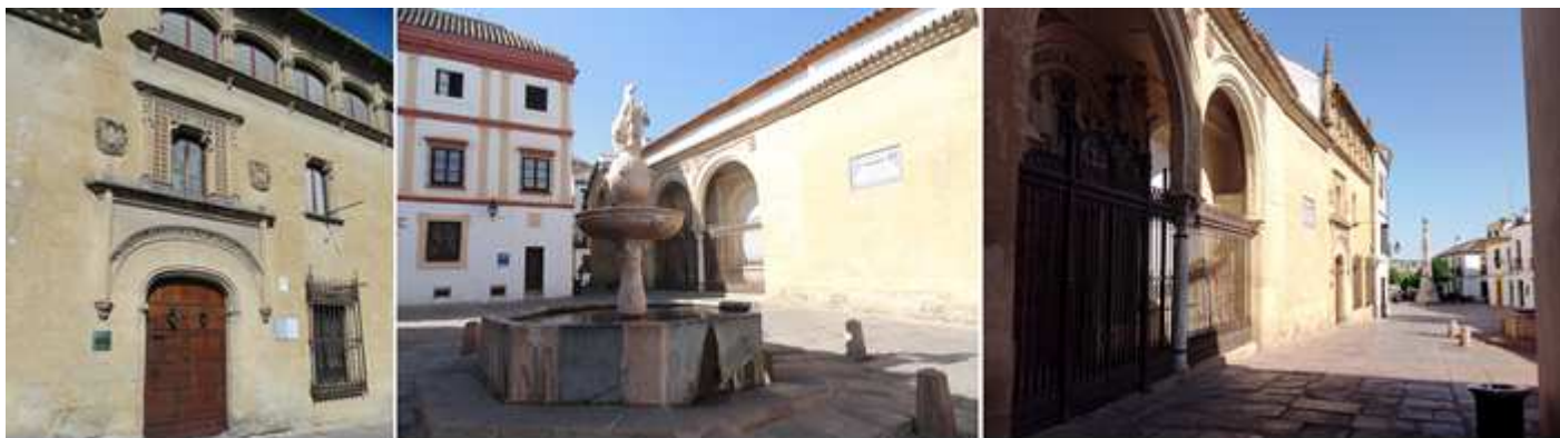
❶ La portada . ❷ La fuente de la plaza del potro y los dos arcos de la entrada a la capilla del Hospital. ❸ Perspectiva con el edificio y esta plaza
