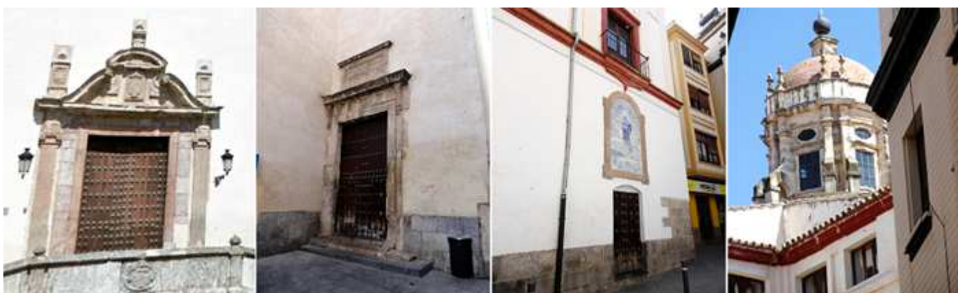
❶ Posee un estrado de escaleras en su puerta principal de 1721. ❷ Puerta lateral del lado de la Epístola a la calle Duque de Hornachuelos. ❸ Retablo cerámico en esta calle. ❹ Y la cúpula octogonal desde la calle Juan de Mena.
