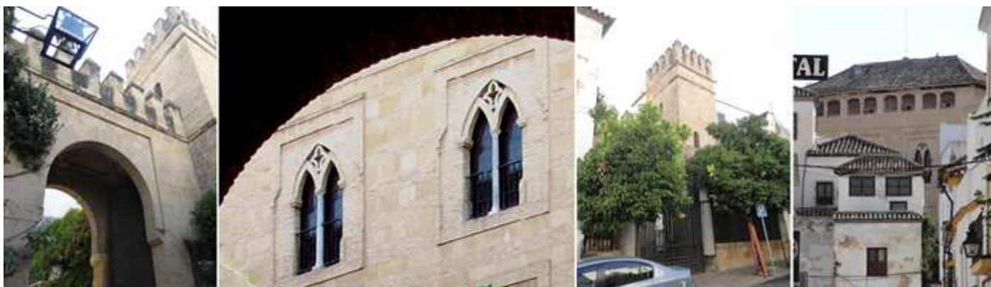
1 Detalle del portalón y la torre del S. XV. 2 Vista de las ventanas ajimezadas del edificio de cuatro plantas. Estos vanos como los balcones que hay en la planta inferior con aspecto neo gótico son fruto de la reforma que tuvo este torreón medieval por sus nuevos propietarios en el S. XX. 3 Este torreón de las murallas es de planta cuadrada. 4 Otra visión de la construcción mayor con la galería de arquillos. No es visitable.
