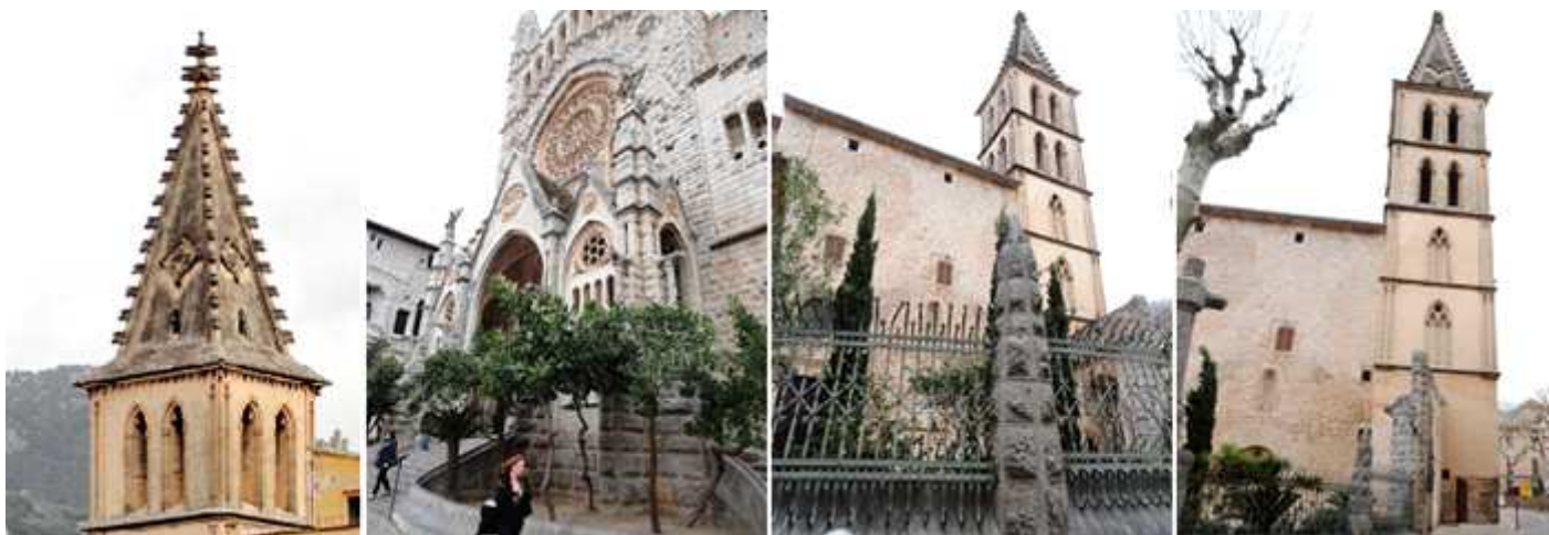
❶ Su campanario esta coronado con tejado con decoración y sus ángulos están con crestería ❷ Su atrio o pórtico esta adelantado a la fachada. ❸ Lateral de la Epístola. ❹ Su campanario neo gótico de planta cuadrada con cinco cuerpos y los dos últimos con dobles ventanas para sus campanas.
