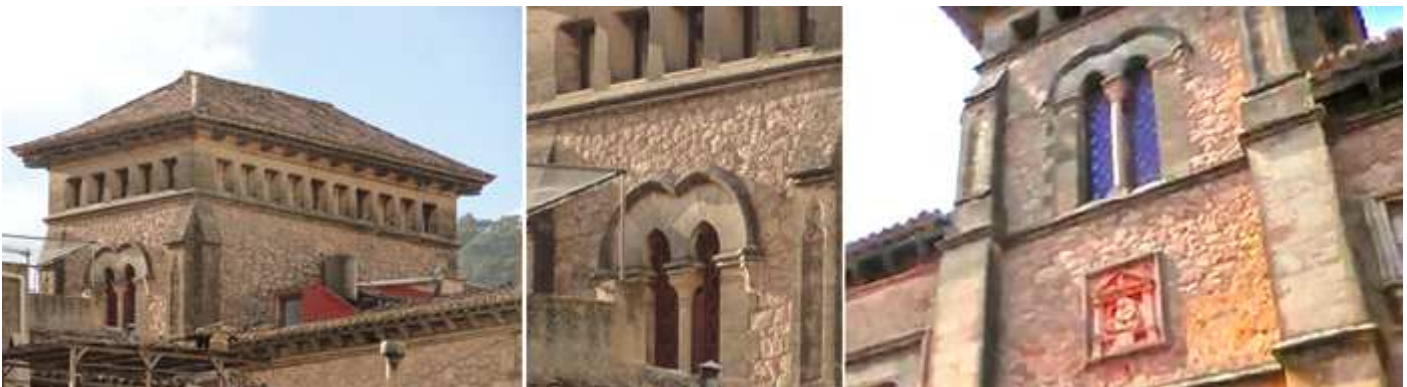
1 Partes superior del palacio, con una galería de ventanas adinteladas. 2 En su parte frontal dispone de una ventana bífora de arcos apuntados con un guarda lluvias y un mainel con capitel con hojas. 3 Parte central bajo la ventana con un escudo y a los lados los dos cuerpos de la construcción.
