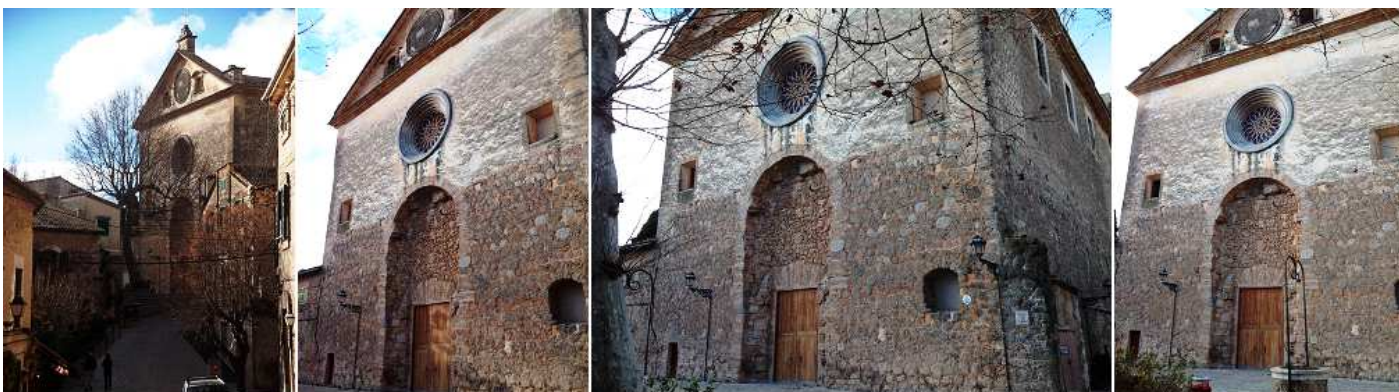
1 Subiendo desde la plaza de la Cartuja. 2 Un edificio construido con cantería irregular. 3 Y bastante sobrio su exterior. 4 En esta fachada su portada cegada con un óculo redondo y culmina con un frontis triangular que posee otro.
