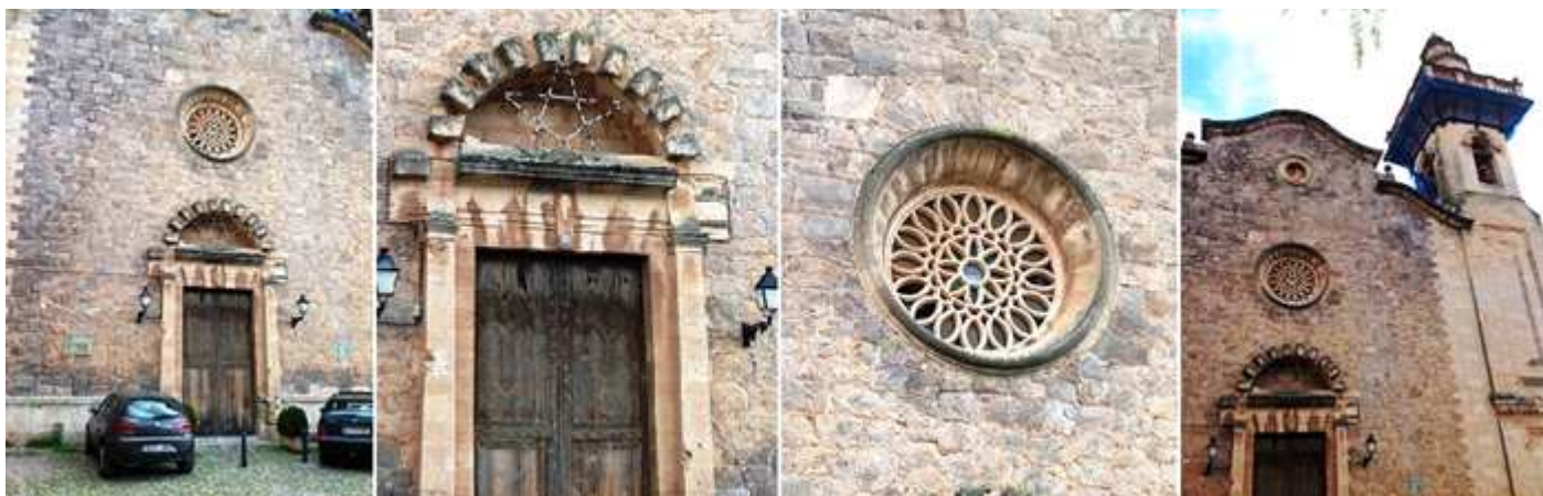
❶ Solo podemos apreciar su fachada al estar el templo cerrado. ❷ Con una puerta adintelada que posee un arco sobre la misma con dovelas en relieve de forma alternativa, y decoradas con un dibujo de aspas. ❸ Sobre la puerta luce un rosetón calado. ❹ Y en el lado epistolar dispone de su torre panta cuadrada que sus últimos cuerpos es octogonal y que está en obras actualmente. Campanario neoclásico levantado en 1925 con motivo de la canonización de Santa Catalina Thomás.
