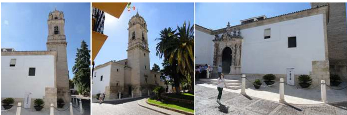
❶ Adosada al templo se encuentra su torre. ❷ Cabecera de la Asunción en la plaza Condes de Cabra. ❸ En el lado de la Epístola tiene su portada barroca con columnas sobre pódium siendo las interiores salomónicas. Sobre el entablamento con pináculos en el centro la tira papal y las llaves de San Pedro.
