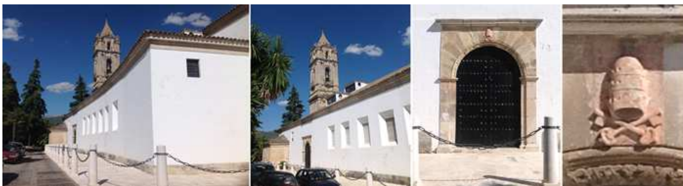
1 Lateral exterior del Evangelio. 2 Otra imagen de este lado. 3 Y si puerta de medio punto con grades dovelas lisas con su interior baquetonado y una fina arquivolta con decoración vegetal que descansa en una imposta corrida. Y sus hojas claveteadas. 4 Sobre la claves la tiara papal y las llaves de san Pedro.
