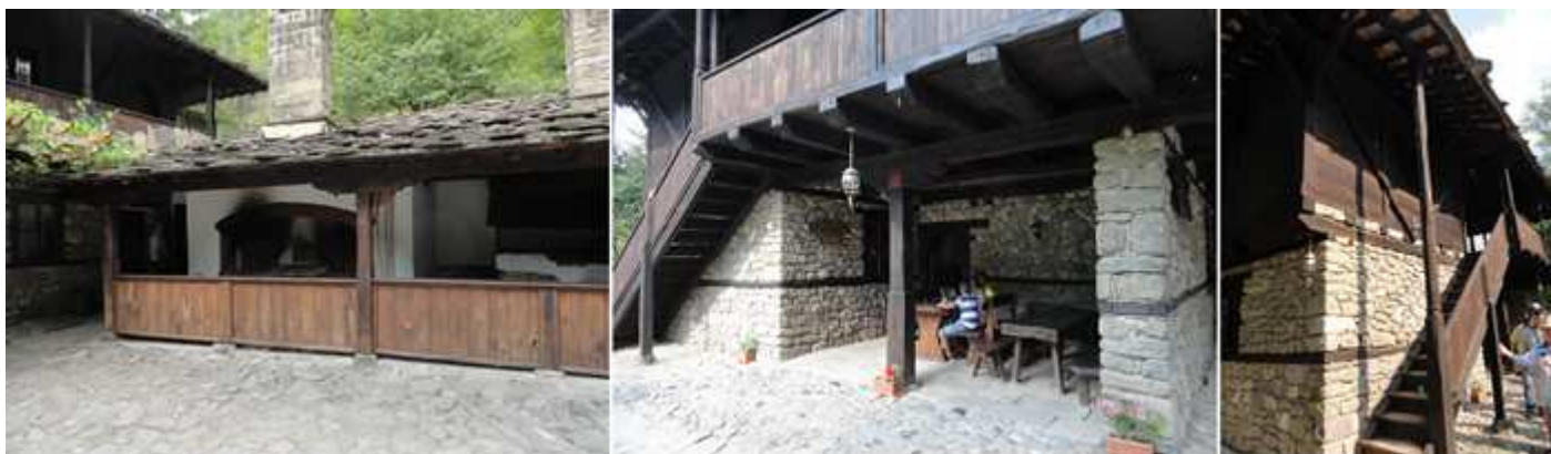
❶ Una de las fraguas existentes. ❷ La mayoría de las casas posee amplias galerías cubiertas por unos aleros. ❸ Y en la mayoría sus escaleras al primer piso son exteriores.
