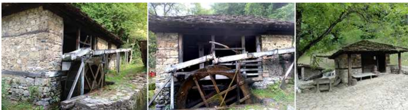
❺ La noria con más detalle del Molino Karadzheyka construido alrededor de 1780.(reconstruido). ❻ Y como el canal de agua cae sobre sus cangilones o departamentos de madera. ❼ Continuamos hacia el molino harinero.
