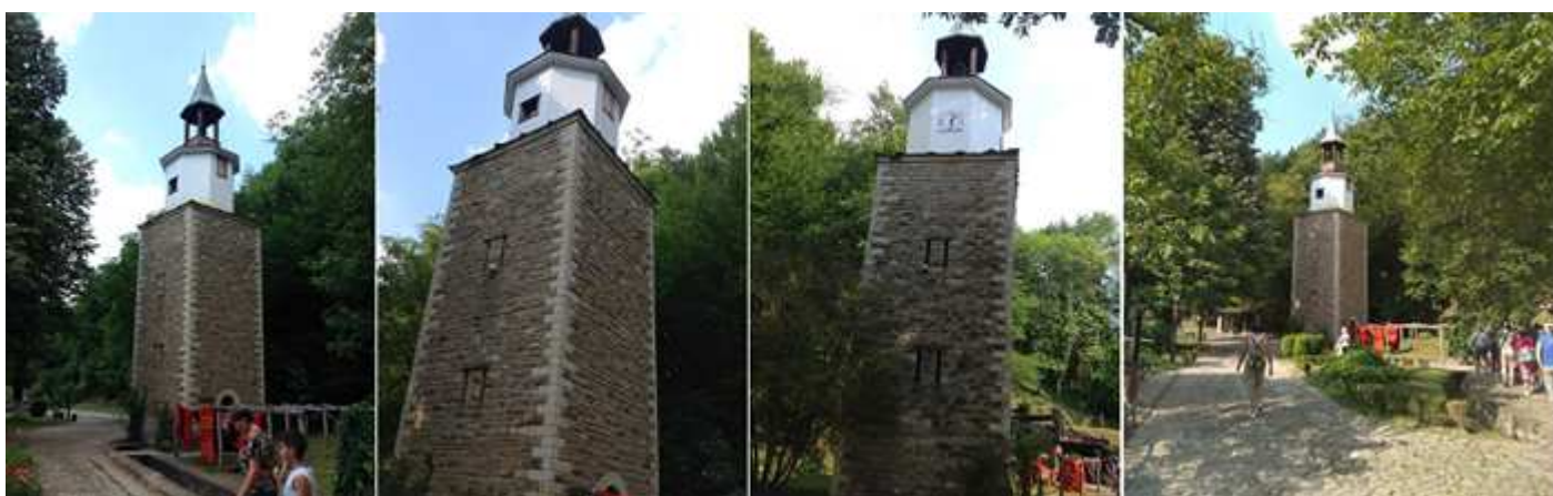
❶ Esta torre de dos cuerpos que la inferior es de planta cuadrada y la superior octogonal. ❷ La parte inferior construida en piedra gris ya algo más clara la de sus ángulos, está abierta con ventanas saeteras rectas en una de sus caras. ❸ En una de sus caras ostenta el reloj. ❹ Otra estampa de este paseo con la torre.
