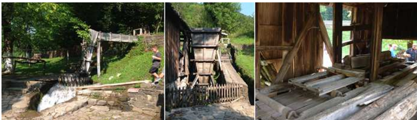
1 Otro salto de agua sobre esta cesta. 2 Y otro ingenio junto al aserradero de madera. 3 Interior de esta instalación.
