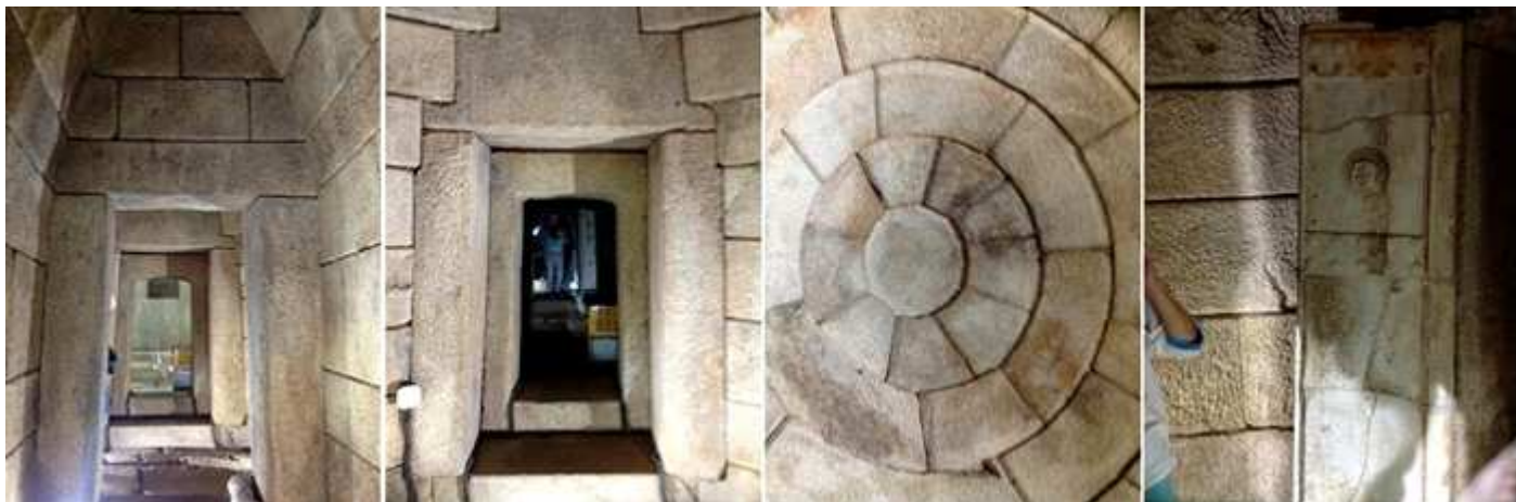
❶ Umbral ante el último tramo de la cámara recta. ❷ Espacio antes de entrar en la cámara redonda. ❸ Bóveda de esta cámara circular. ❹ La puerta del lado izquierdo, ambas están realizadas en piedra.
