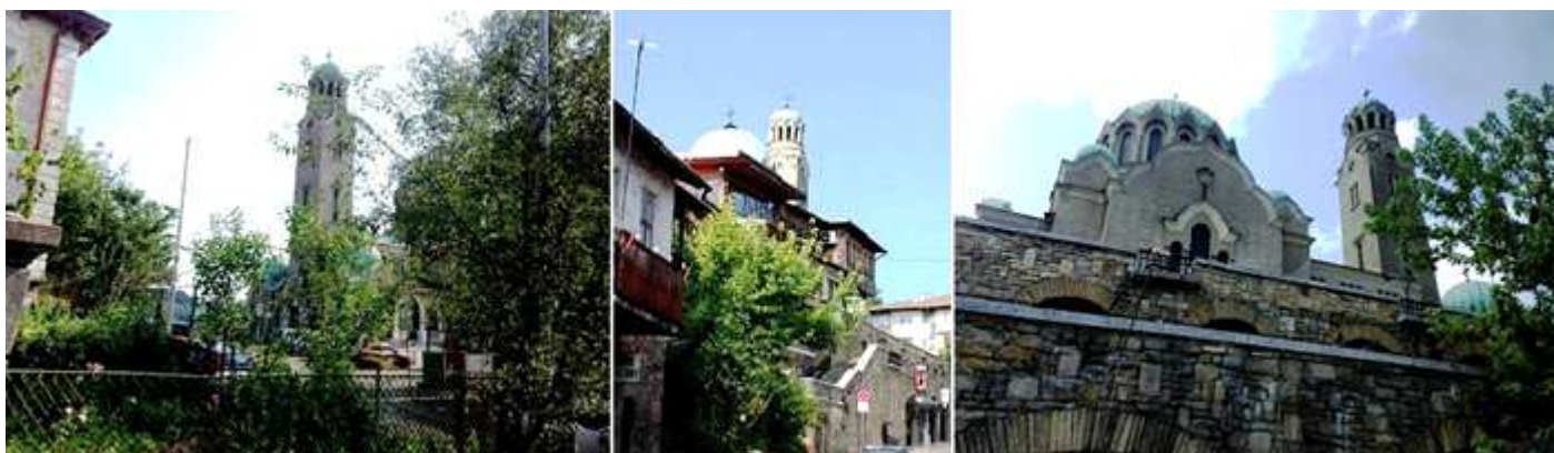
1 La característica torre que se eleva sobre la portada principal. 2 La otra parte del templo se puede acceder desde la calle ul. "Pandeli Kisimov". 3 La iglesia vista desde la calle ul. "Pandeli Kisimov" en la parte inferior de la foto se encuentra un Museo House of Coconne Anastasia. El lugar donde hace 140 años fue la primera reunión de la Bulgaria liberada.
