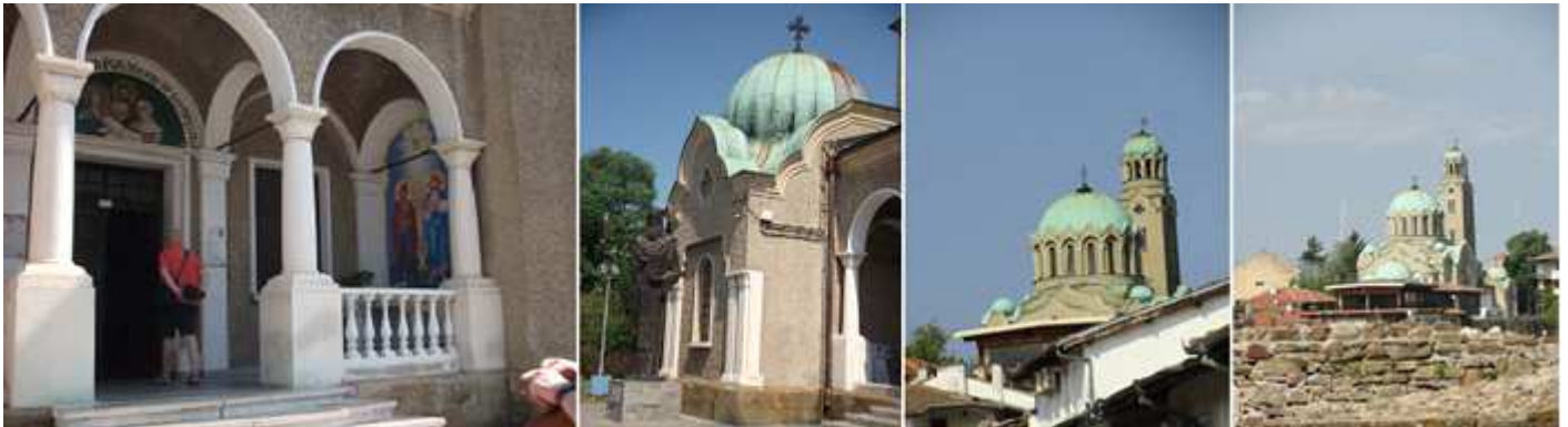
❶ Lateral con un pórtico con arcos. ❷ Otra cúpula a la izquierda del pórtico. ❸ La cúpula principal sobre un tambor con alargadas ventanas de medio. ❹ Otra toma desde la plaza "Zar Asen I". En el interior el iconostasio y trono del obispo son D. Kushlev.
