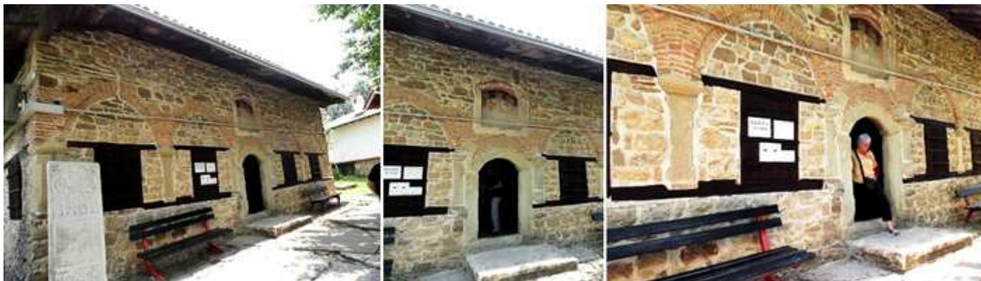
❶ En sus fachas se aprecian cinco arcos de ladrillo. ❷ Espacio central.
