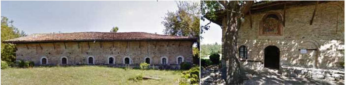
① Ventanas del lateral del lado izquierdo.
