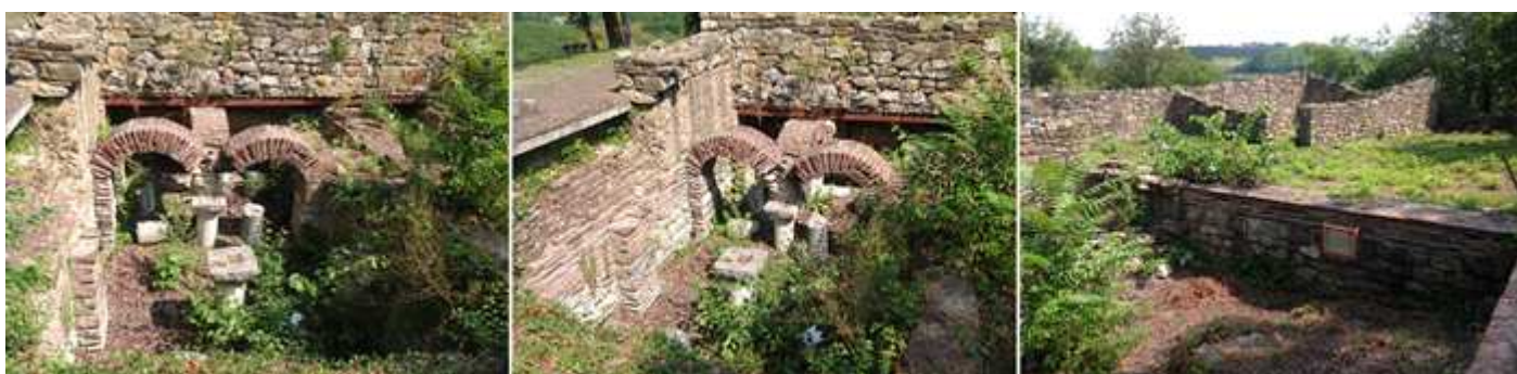
❶ Restos de una edificación que posee un subsuelo que tiene la pinta de ser unos baños. ❷ Con los arquillos y columnillas. ❸ Construcción que no he sabido traducir.
