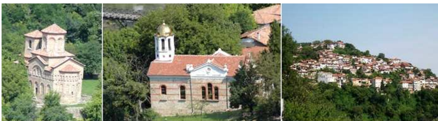
1 Otra vista de la iglesia de San Demetrio con su cabecera semicircular. El templo fue destruido en la 2ª mitad del S. XIII, y reconstruido en los años 1350. Fue saqueada a finales del S. XVIII y principios del XIX. Un terremoto la volvió a destruir en 1913 salvándose el ábside y reconstruida entre 1977 y 1985. . El templo "San Dimitar Thessaloniki "es el más antiguo de la ciudad y ha servido como iglesia real. 2 Otra panorámica con el caserío desparramado por las faldas de la colina se puede ir a Trapezitsa, en coche o con bus urbano nº 50 y 110, o funicular, que funciona de 9 a 17 h, excepto los lunes.
