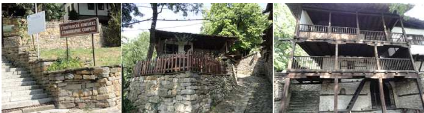
❶ Compartiendo esta casa con la de Rashova están las instalaciones del museo etnográfico. ❷ Las casas están en la ladera de esta colina con calles empinadas. ❸ Fachada de la casa Rashova con un estilo constructivo similar pero con tres alturas. Esta casa fue donada por su propietario Nencho Rashev con la finalidad de que sirviera de museo.
