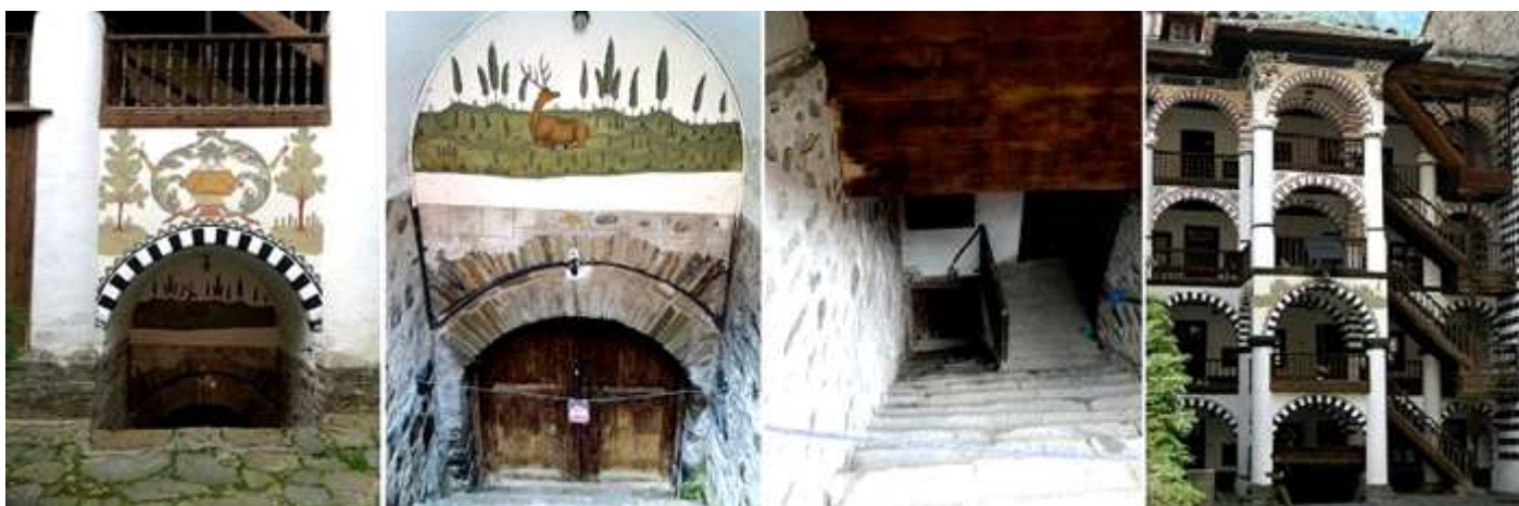
1 Una de las puertas que dan al exterior. 2 Con una pintura más mundana de un ciervo. 3 Otro pasadizo bajo las escaleras. 4 Bloque de escaleras con los descansillos cubiertos y las escaleras de madera al exterior.
