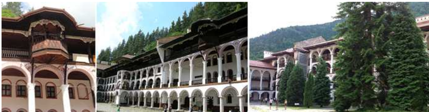
1 Balcón en la última galería de este lateral norte (frente a la iglesia). 2 Una imagen más amplia de este lateral. En su parte central se abren unos arcos más grandes que ocupan dos pisos. 3 Y el lateral oeste a donde vamos con unos crecidos árboles.
