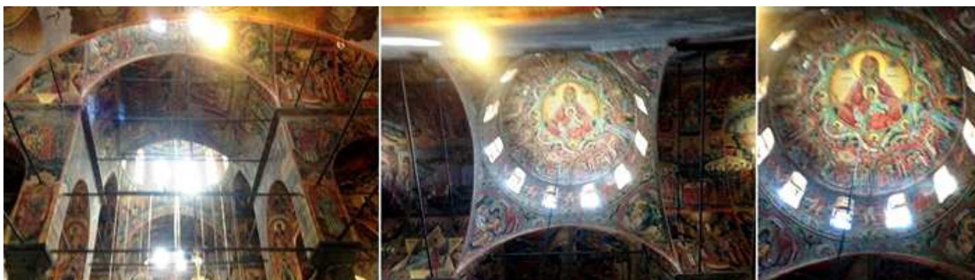
1 Tramo anterior al crucero a ambos lados se encuentra la sillera 2 La cúpula del crucero levantada sobre pechinas con un tambor abierto con ventanas de medio punto. 3 Y su cúpula pintada con la Virgen y el Niño.
