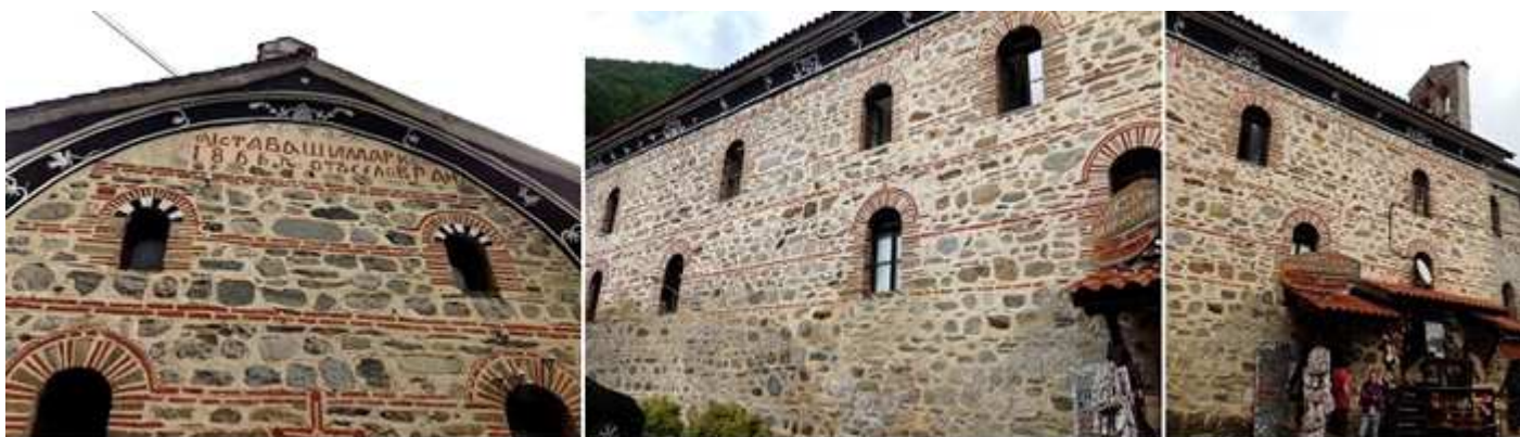
❶ En la parte superior lleva una inscripción con él años 1866. ❷ Esta construcción con n estilo similar al del monasterio con arcos de ladrillo y sus aleros pintados en negro con la misma temática. ❸ Este edificio debe contar con alguna capilla como delata su espadaña de dos vanos.
