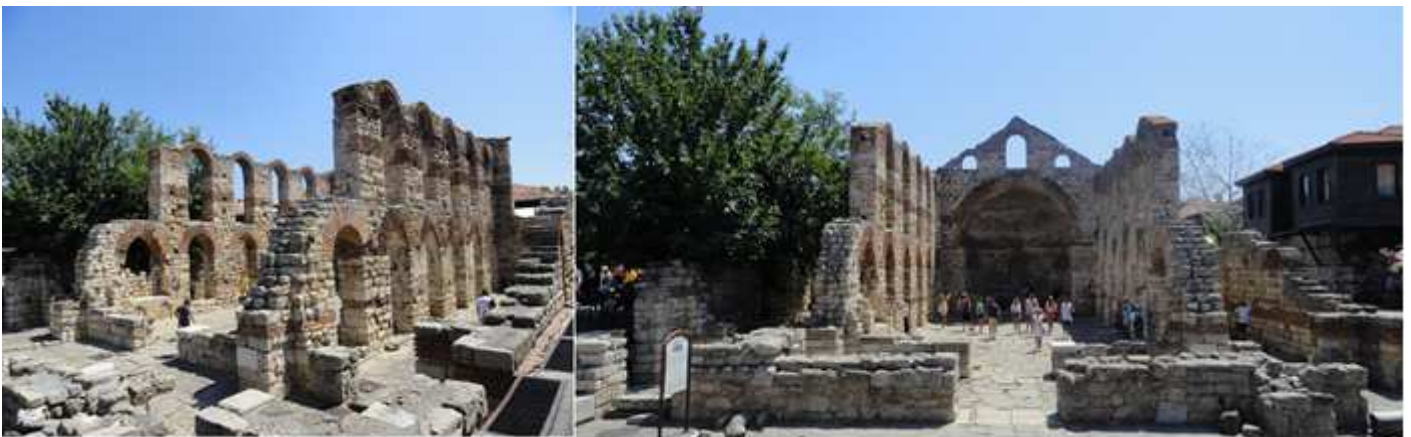
1 Solo se conservan los muros laterales de la nave central, su cabecera y parte de los exteriores. 2 Vista de la parte central, con basamentos de la construcción anterior en el primer plano.
