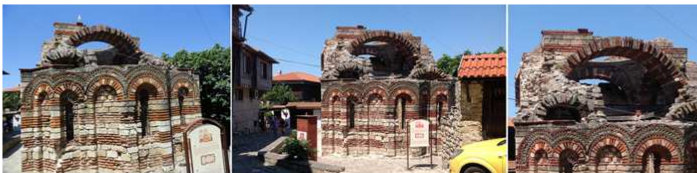
1 El frontal del ábside. 2 Sobre esta parte del arco superior se levantaba su cúpula de media naranja ocho lados abiertos con ventanales de medio punto. 3 Aquí se puede apreciar la base de la cúpula que es de planta cuadrada.
