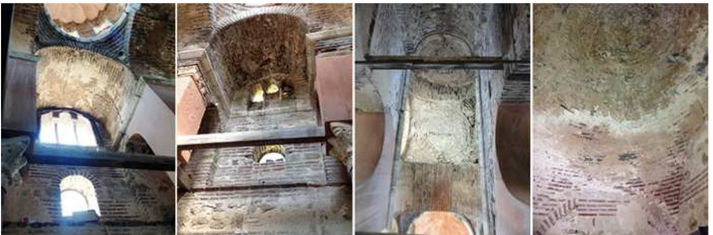
1 Brazo del crucero del lateral derecho. 2 Y el opuesto que sus ventanas están parcialmente obstruidas. 3 La bóveda del ábside central. 4 Y el detalle de su construcción.
