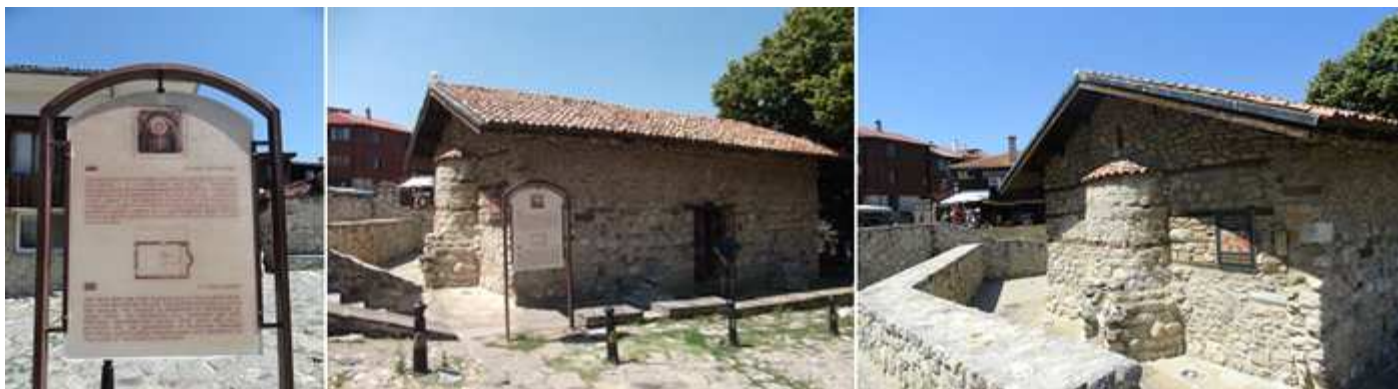
1 Panel informativo, dentro tienen un impreso en español. 2 Fachada con su puerta de entrada, y los muros perimetrales que la soterran. 3 Cabecero del templo al este con su pequeño ábside.
