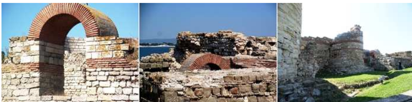
1 Uno de los espacios restaurados. 2 Y desde la parte superior de esta zona. 3 Entre los lienzos se alternan los cubos.
