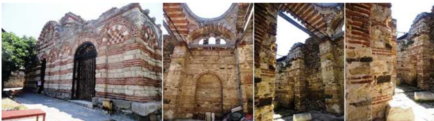
1 Lateral izquierdo con la puerta del templo al fondo y del nártex de este lado. 2 El espacio de la cúpula y el lateral derecho del templo. 3 Bajo los restos de su cúpula. Con el arco que dispone de tres ventanas. 4 Y lo que se puede ver de la nave desde las rejas de sus puertas.
