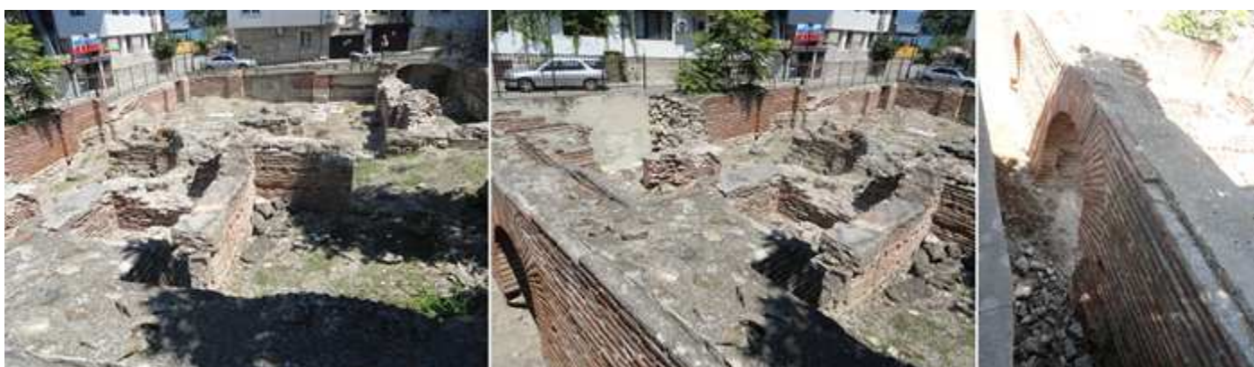
❶ Francamente es difícil de identificar con el plano las fotos tomadas. ❷ Zona del espacio intermedio. ❸ Un lateral exterior abierto con una puerta de medio punto de ladrillo.
