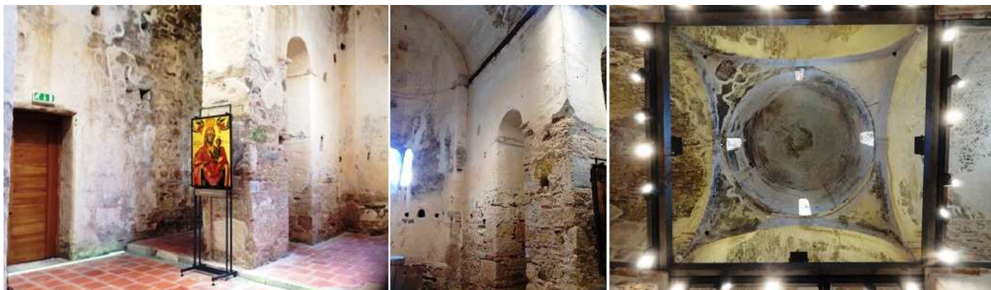
1 Lateral izquierdo del crucero abierto con una puerta adintelada 2 El ábside Mayor se comunica por un arco de medio punto a sus lados con los ábsides menores. 3 Detalle de la parte central del crucero.
