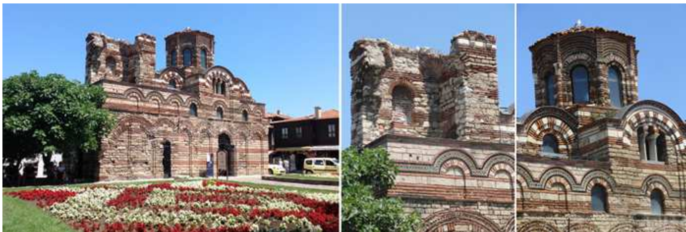
❶ Su fachada principal.
