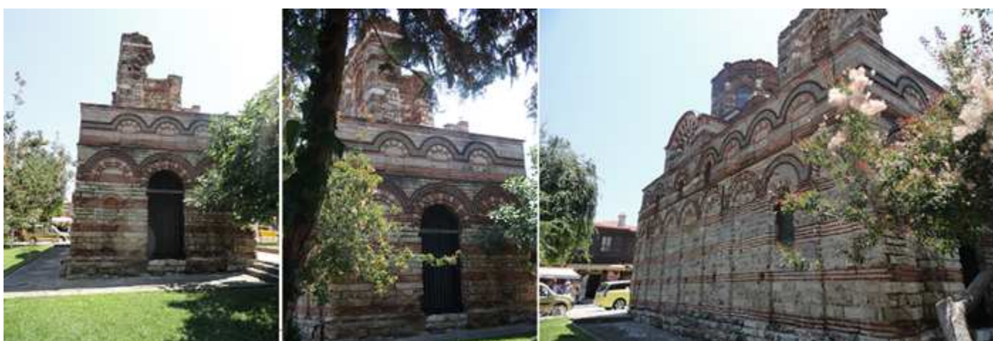
❶ Parte frontal del templo donde aparece su torre en ruinas. ❷ Con una puerta las otras dos laterales esta cegadas. ❸ Mantienen la característica de las hiladas de piedra y ladrillo, a demás de la notoriedad que le dan sus arcos.
