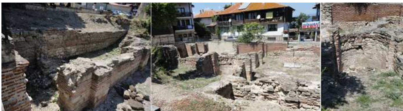
❶ Mayormente su construcción sobre los basamentos de piedra se alternan las hiladas de ladrillo y cantería. ❷ SE aprecian tres espacios longitudinales a lo ancho. ❸ Ábside semi circular de una de las salas calientes.
