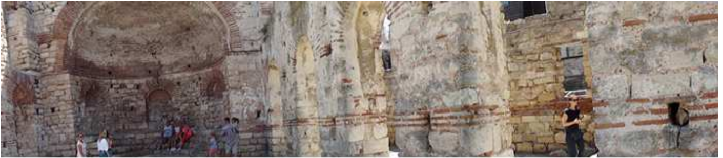
1 Panorámica de su cabecera y el lateral derecho de la nave central.
