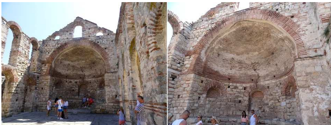
❶ Su cabecera algo más estrecha que la nave y culminada con un frontón abierto con tres ventanas. ❷ Su bóveda está construida con ladrillo lo mismo que su arco triunfal.
