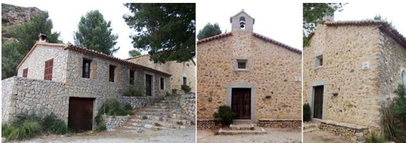
1 Dispone de una casa anexa a la ermita. 2 Es una construcción realizada con cantería. 3 Está en muy buen estado de conservación.
