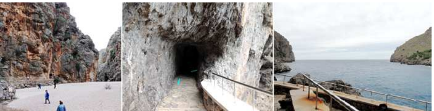
❶ Retornamos por la pasarela que nos ha facilitado su ingreso. ❷ Los túneles tiene ciertas aberturas como miradores de esta costa. ❸ Y se suceden sobre el precipicio y las rocas.
