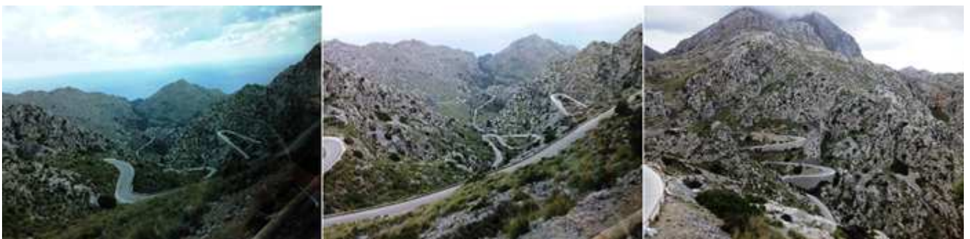
❶ El paisaje es abrupto y de forma escalonada baja la carretera. ❷ Con curvas y contra curvas. ❸ Que parece interminable.
