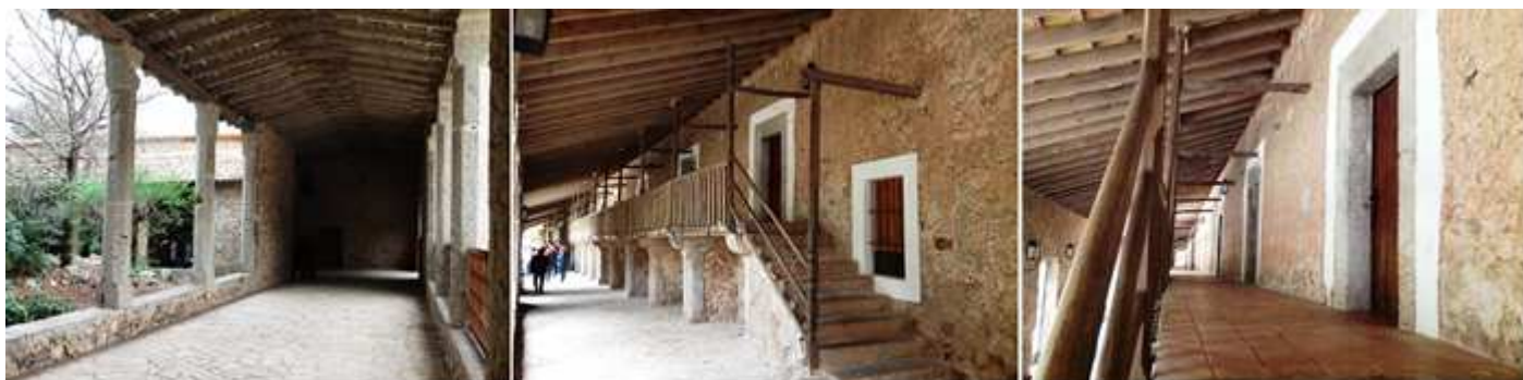
❶ Inicio de los porches, abiertos y con cubiertas de madera. ❷ En la parte superior eran los alojamientos y en la inferior se ataban las caballerías. ❸ Entrada a las estancias de los peregrinos.
