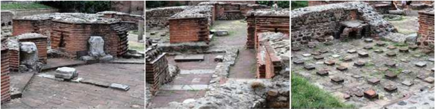
1 Muros de ladrillo como los suelos de distintas habitaciones. 2 Y basamentos con cantería y argamasa. 3 En esta foto lo que podría ser una sala caldarium, en el ángulo superior se aprecian los arquillos de subsuelo flotante.
