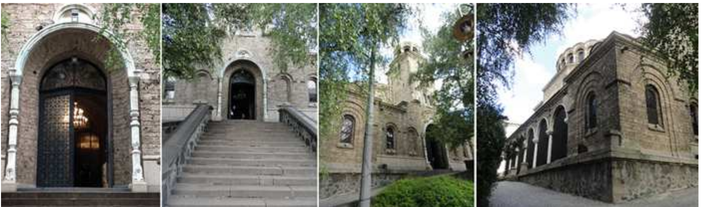
❶ Puerta de medio punto abocinada y con unas columnas torneadas en la sencilla arquivolta. ❷ Detalle de la escalinata ante la puerta principal para compensar el notable desnivel del terreno. ❸ La fachada esta con ventanas de medio en varios tamaños que iluminan el nártex. ❹ Lateral izquierdo del templo con otra galería lateral.
