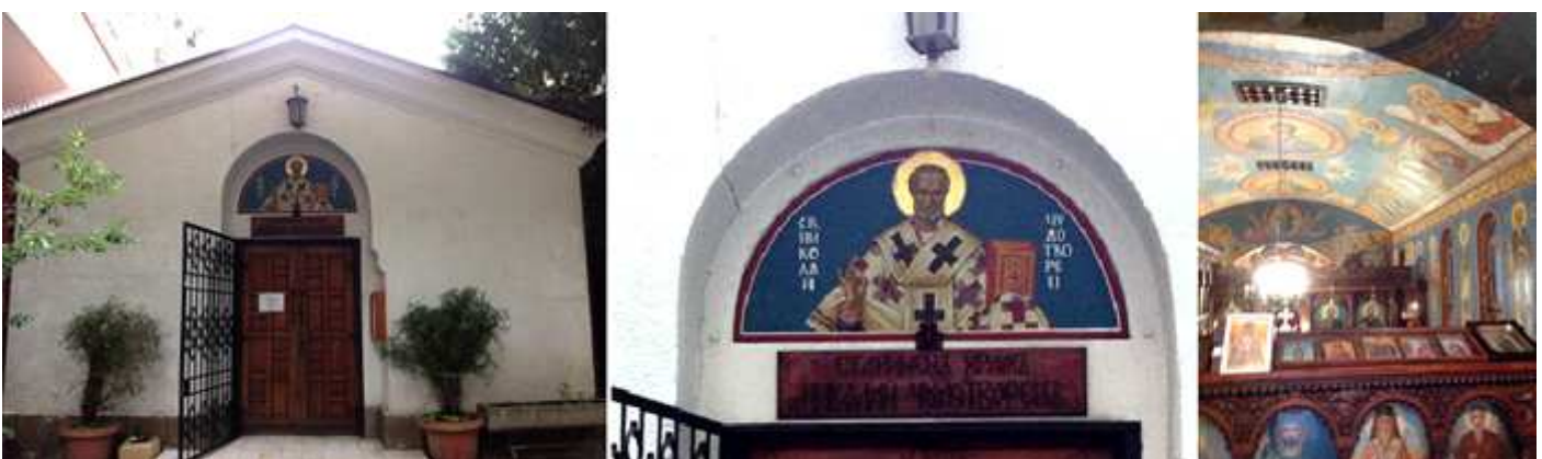
1 Fachada ante la calle ul. Tsar Kaioyan nº 8. 2 Tímpano con la pintura de su titular sobre la puerta. 3 Es de pequeñas dimensiones con planta rectangular, tras su ingreso se bajan unos escalones a la nave. Lastima no haber tenido la información in situ para haber preguntado.
