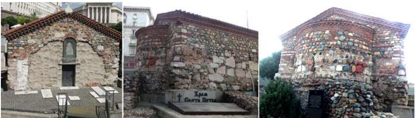
1 Sobre su puerta adintelada una hornacina con la santa 2 Latera con su ábside. 3 Este es semicircular algo más pequeño de la nave, y con un lápida.
