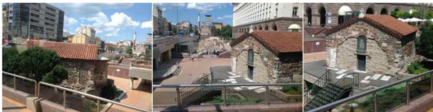
❶ La diminuta iglesia Sveta Petka Samardzhiiska. ❷ Construida con ladrillos, cantería y argamasa. ❸ Es de planta rectangular y posee un pequeño ábside semicircular.
