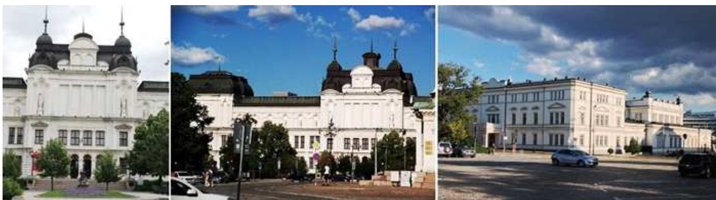
❶ Parte central de la fachada principal ❷ El edificio ocupa una manzana. ❸ Esquina con la calle Oborishte.
