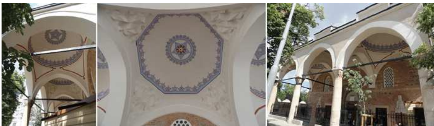
❶ Las cúpulas de sus pórtico circulares las de los lados. ❷ Y octogonal la central con una decoración en azul. ❸ Las arcadas de medio punto con columnas y capiteles.
