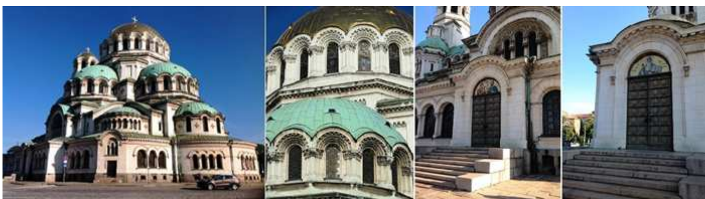
❶ Perspectiva del lateral derecho del templo. ❷ Detalle de la cúpula central y la adosada a su derecha. ❸ La puerta del crucero de este lado ante una pequeña escalinata. ❹ Todas las puertas posee unos tímpanos decorados con mosaicos con santos. Y sus hojas talladas con 17 losetas con marcos torneados helicoidalmente, y su interior con unas cruces que se sus brazos se prolongan formando unas hojas.
