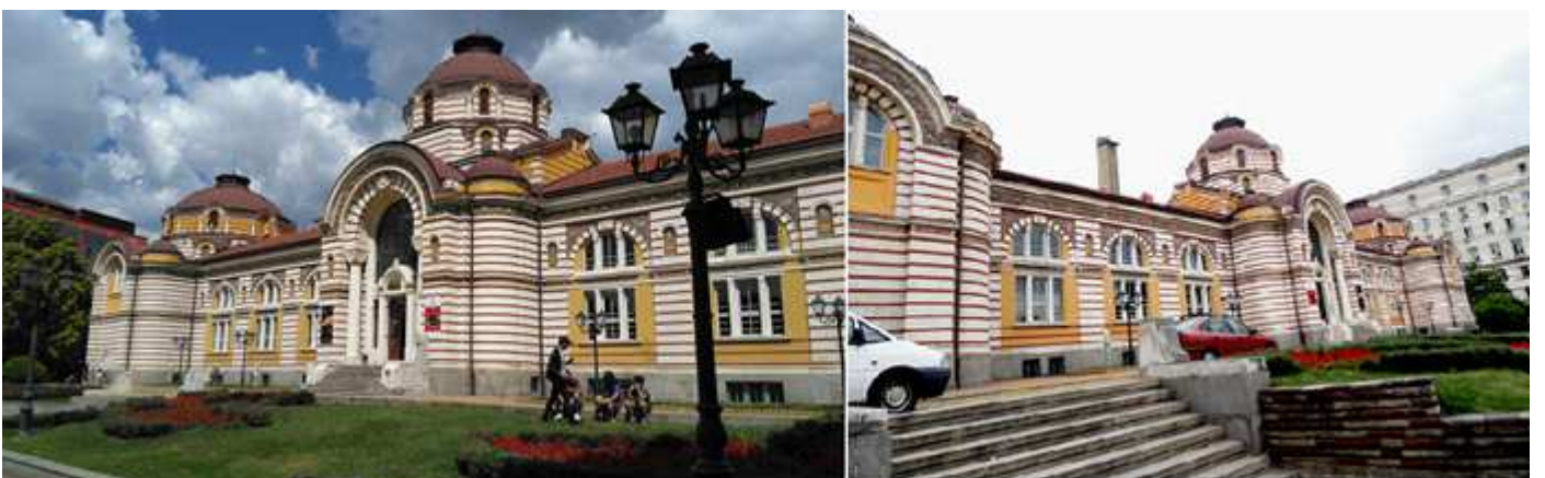
❷ Es uno de los edificios más atractivos de Sofía. ❸ Su fachada posee dos cúpulas grandes en sus laterales y otra menor sobre su puerta principal. La decoración exterior es exhaustiva en sus frontis cerámicos que recorren bajo los aleros esta fachada.
