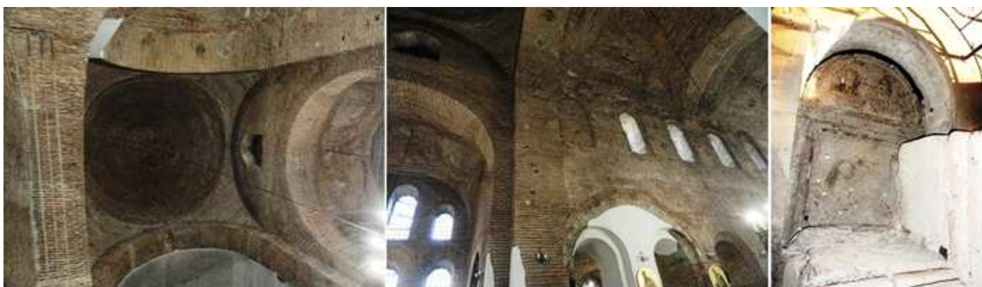
❶ La cúpula del crucero sobre trompas y a la derecha la bóveda de su cabecera. ❷ Lateral epistolar. Tras la bóveda del crucero la nave central posee otra cuadrangular y el resto es bóveda de cañón. ❸ En la parte inferior de la columna del arco con la nave central junto al crucero en el lado del Evangelio bajo la rasante del suelo se encuentra una sepultura de las muchas que posee el templo.
