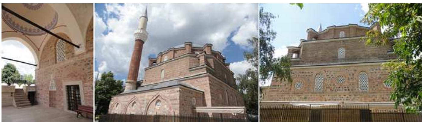
❶ Lateral izquierdo. En su exterior dispone de una fuente para las abluciones. ❷ El diámetro de su cúpula es de 15 m. y que se reconstruyó al finalizar la era soviética. ❸ Parte de su cabecera que da al parque Tsentraina Bayna.
