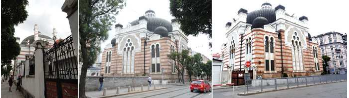
❶ Su verja ante la calle ul. Ekzarth Yosif ❷ En este lateral de la calle desde el mercado. ❸ Y la fachada que da a la calle George Washington. Todos sus ventanales posees antas columnas de mármol con capiteles de hojas.
