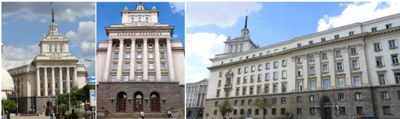
❶ El edificio de la antigua Casa del Partido, que se usó hasta el año 1990. ❷ Su frontal con tres cuerpos, sobre el inferior abierto con grandes ventanales un conjunto de seis columnas ocupan las plantas de la 3ª a la 6ª. ❸ Fachada ante la plaza Antanas y el Museo Arqueológico.
