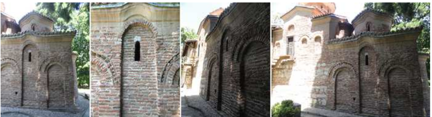
❶ La cubierta de la cúpula de la nave es ondulante ante sus ventanas. ❷ Los arcos laterales de este tramo poseen un guardapolvo decorado con esquinillas sobre los dos arcos interiores. ❸ Los arcos ciegos con apenas profundidad. ❹ Exterior de este lado epistolar. Esta parte más antigua orientada al este, es de finales del S. X o principios del S. XI.
