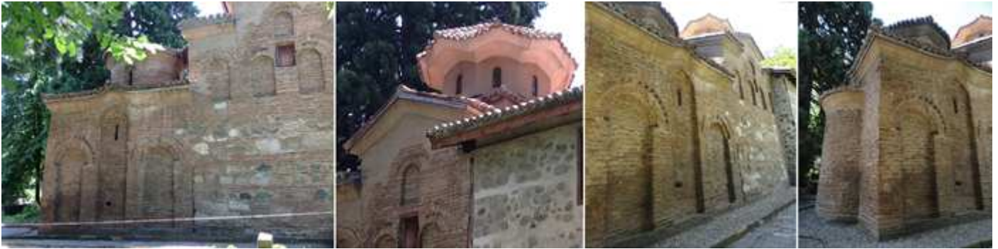
❶ A la izquierda con tres arcos ciegos y el central abierto con una ventana estrecha la parte de la iglesia del S. XI, y a la derecha el tramo del nártex del S. XIII. ❷ La parte superior con la cúpula de la iglesia de San Panteleimon. ❸ Perspectiva de este lateral del templo. ❹ Y la cabecera con un pequeño ábside semicircular.
