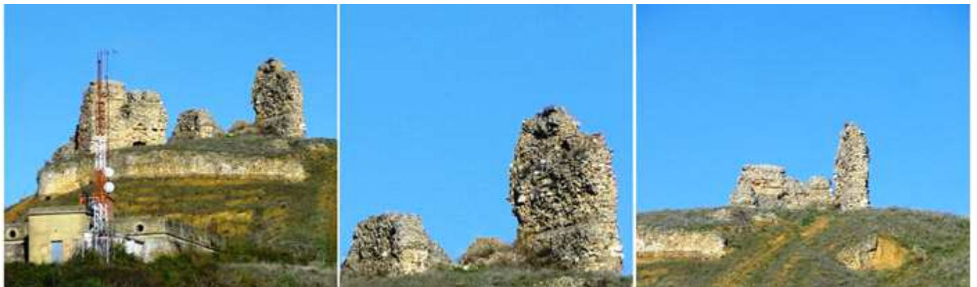
❶ La torre del oeste es la que se conserva en pie parte, es de una altura de 9m y disponía de tres plantas. ❷ Su construcción es a base de argamasa y cantería, y ha servido durante muchos años de cantera para su reutilización en construcciones locales. ❸ Otro detalle de sus restos.
