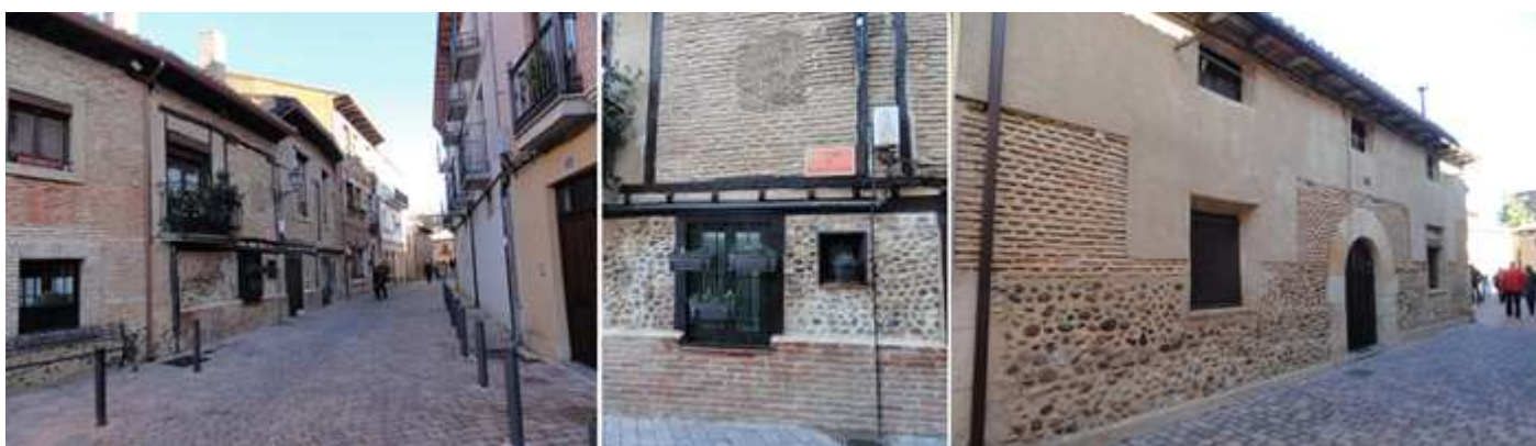
❶ Edificios de la calle Marqués de Valdavia ❷ Algunas casas también tienen empleada la construcción con paños de cantos rodados ❸ Casa en el nº 5 con una puerta de medio punto con dovelas lisas.
