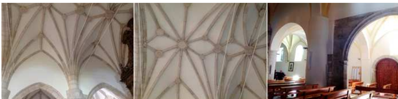
❶ Bóvedas de la capilla Mayor y del primer tramo de la nave central. ❷ Bóvedas de los tramos siguientes de crucería con distintas claves decoradas con motivos y escudos. ❸ Lateral derecho con el arco de piedra y la puerta en este lateral.
