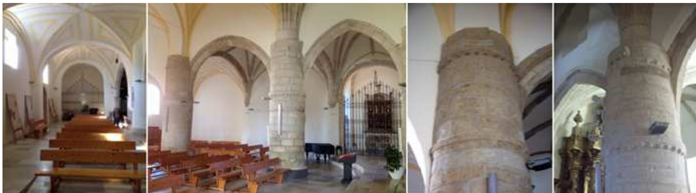
❶ Nave de la Epístola desde su cabecera. ❷ Lateral opuesto con la capilla funeraria de la familia Santander. Donde podemos apreciar las gruesas columnas circulares que tienen una decoración a bolas. ❸ Detalle de una de las columnas. ❹ Otra de ellas donde arranca los nervios de sus bóvedas.
