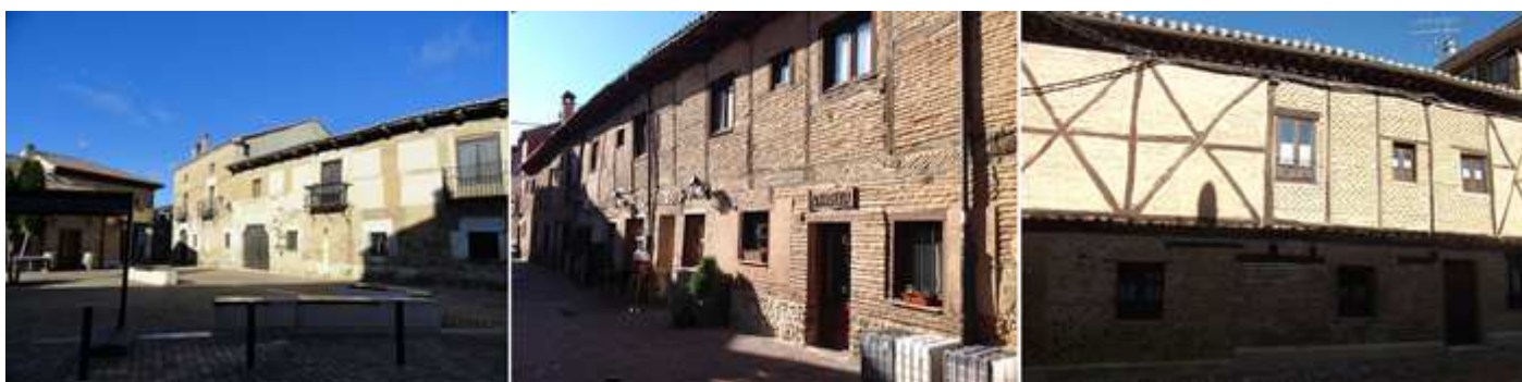
❶ Plaza del Marqués de Valdavia. ❷ Edificios donde los paños de ladrillos se alternan de distintas formas con los maderos de madera. ❸ O se alterna también con espacio lucidos.
