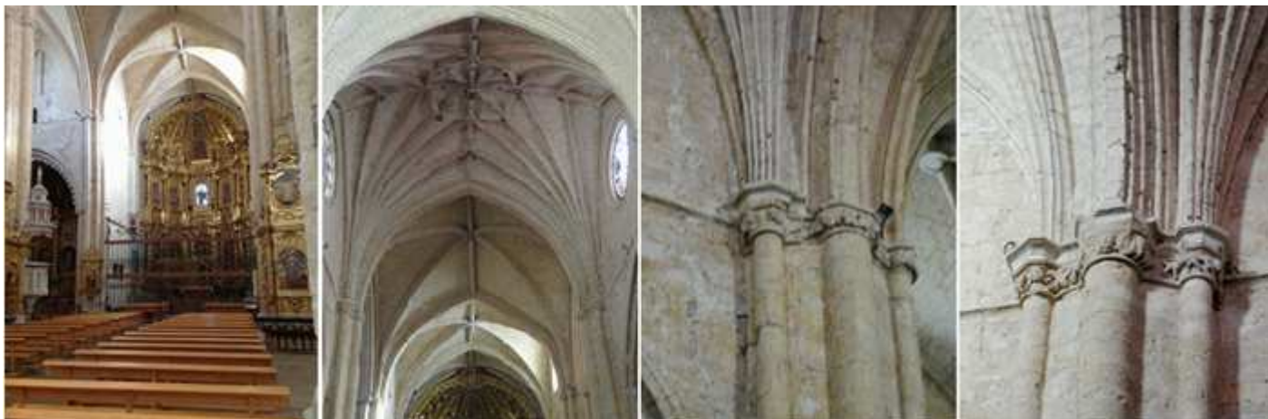
❶ Vista de la nave central. ❷ Con las bóvedas de la misma donde se aprecian el cambio de la construcción de crucería sencilla y los tramos posteriores en estrellada tardo gótica. ❸ Una fina imposte recorre la nave central a la altura de los capiteles de sus columnas. ❹ Y sobre los mismos arrancan los arcos y nervios de sus bóvedas.
