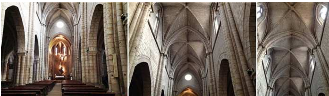
1 Nave con una altura notable. La capilla Mayor compuesta por cuatro paños abierto con ventanas de medio punto con columnas cuadradas lo mismo que sus nervios y un arco apuntado sobre capiteles lisos y columnas redondas. 2 Perfectamente iluminada con sus ventanales apuntados. 3 Con bóveda de crucería.
