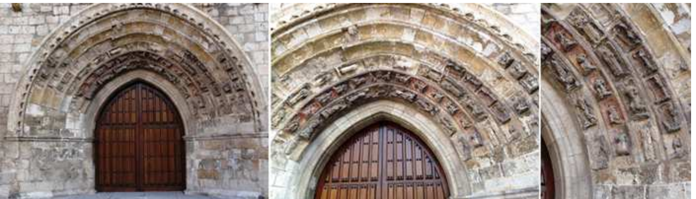
❶ Portada con un guardapolvo baquetonado y con arcuaciones a su interior, parte de las imágenes de sus arquivoltas se han perdido. Y la parte central la mayoría de los personajes de sus arquivoltas son ángeles o personas con dalmáticas. ❷ Con un arco apuntado en su interior y una imposta corrida. ❸ Detalle de la parte derecha de la portada.
