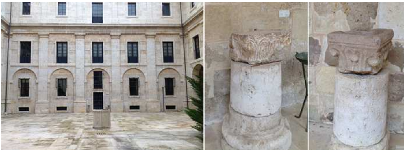
❶ Una de las pandas sus arcos esta cerrados con ventanas. ❷ Capitel románico del S. XII. ❸ Pila agua bendita de piedra arenisca, posiblemente de un capitel reutilizado con hojas y volutas posee su parte inferior fragmentada y sobre un fuste redondo adaptado para la exposición lo mismo que la basa redonda. Del S. XII.
