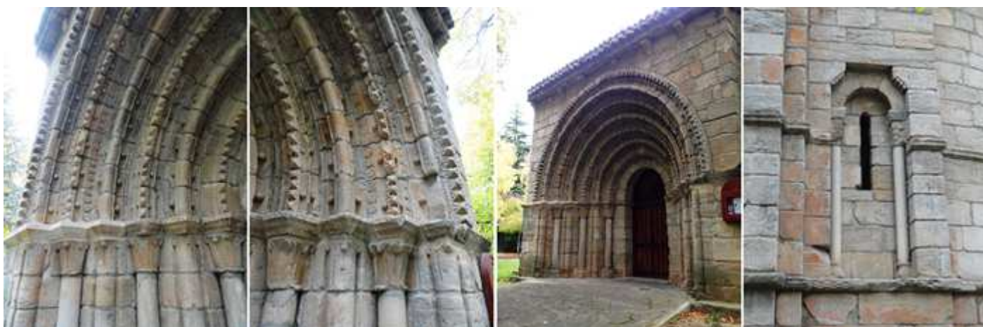
❶ Las arquivoltas con bastante decoración se alternan unas con relieves con puntas de diamantes y a los lados con bolas y flores de botón sobre sus baquetones, con otras que el baquetón a sus lados tienen estas florecitas de cuatro pétalos redondas. ❷ El lado opuesto derecho. ❸ El ábside está precedido por un tramo recto con esta ventana alargada con una ventana de aspillera con una arquivolta lisa con columnillas y capiteles.
