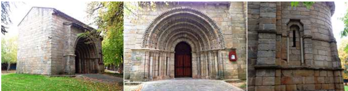
❶ El templo tiene una portada adelantada cubierta con un tejado con canecillos. ❷ Detalle del abocinamiento producido por sus arquivoltas en sentido decreciente. ❸ Exterior del presbiterio ante su cabecera.
