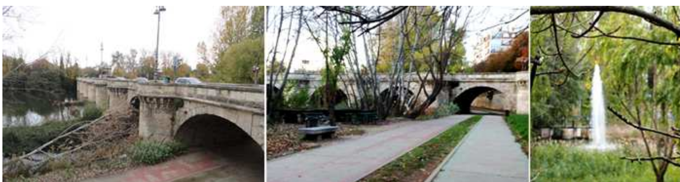
❶ Estos tajamares de forma semicircular terminan con forma de Matacanes. ❷ Unos asfaltados corredores dispone en esta lado. ❸ Al otro lado del surtidor otras esclusas.
