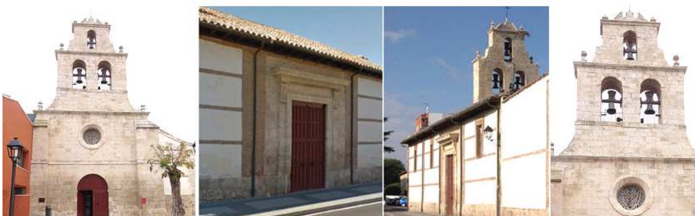
❶ Fachada a la plaza de Juan XXIII, entre sus contrafuertes una puerta de medio punto sobre la que dispone de un óculo. ❷ Puerta adintelada en la calle Hermanos Madrid. ❸ Perspectiva desde esta calle y colindante el convento de La Piedad. ❹ Y un segundo cuerpo separado por una imposta corrida su espadaña de tres vanos.
