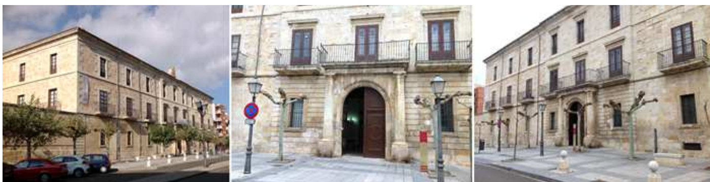
❶ Es un edificio que dispone de una manzana con el espacio de su patio lateral. ❷ Su portada en el centro con sendas columnas toscanas sobre pódium y sobre ella los balcones de la planta noble. ❸ Dispone de tres patios con un patio central.
