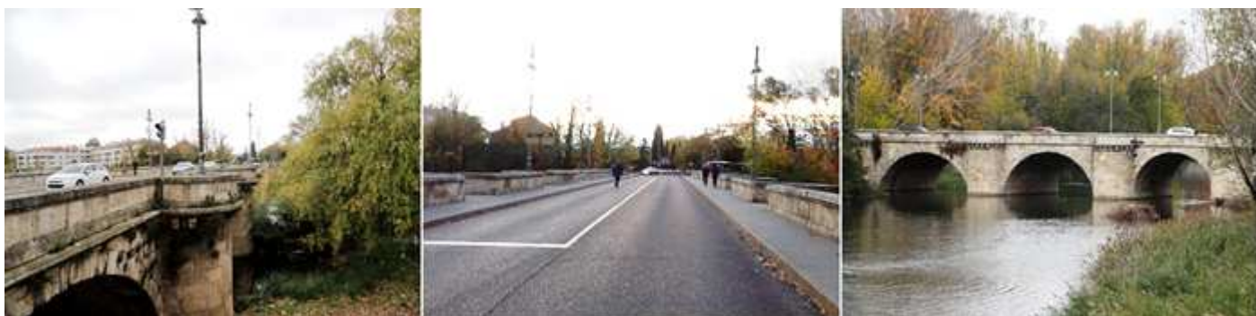
❶ El puente originalmente tenía siete arcos de medio punto, actualmente posee ocho. ❷ Fue reformado para hacerlo más ancho y poder absorber mejor la circulación aunque originalmente tenía los tajamares prismáticos hoy día son cubos. ❸ Vista del puente aguas abajo. Comunica el centro de la ciudad con el barrio de Allende el Río y el Monte Viejo.
