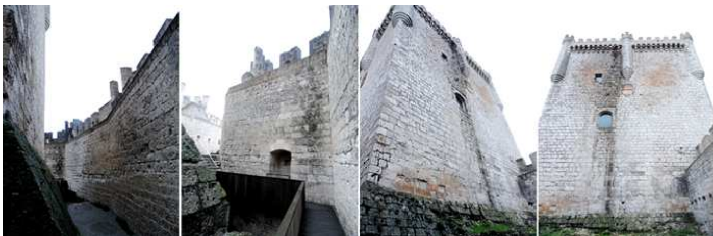
❶ El talud de la torre y las murallas con un espacio muy estrecho. ❷ Estancia bajo uno de los cubos de las murallas en esta parte. ❸ La base de la torre esta reforzada con un talud. ❹ Bajo esta parte tiene algunas construcciones subterráneas abovedadas.
