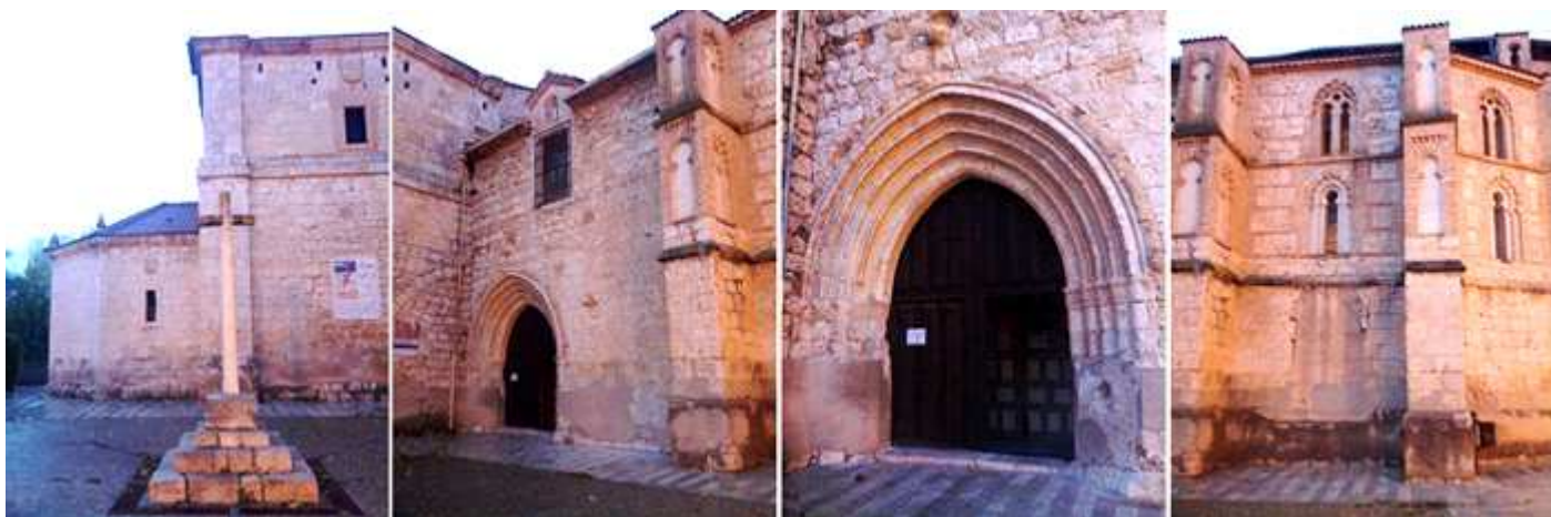
❶ Plaza con un crucero. Al fondo la capilla de Don Juan Manuel ❷ En el lado epistolar se abre su portada apuntada. ❸ Con cinco arquivoltas baquetonadas de distinto grosor. ❹ Lateral del presbiterio donde se pueden observar ventanas con arco de herradura.
