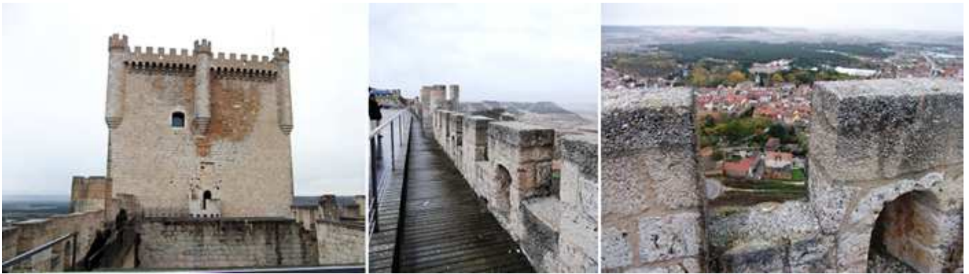
❶ Adarve del patio de la torre y la Torre del Homenaje al fondo. ❷ Paseo de ronda o adarve de este patio que comunica con los doce cubos y dos torretas que tiene a sus lados esta parte. ❸ Con almenas y saeteras.
