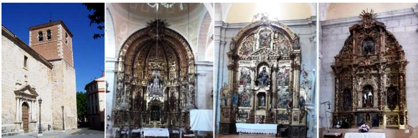
❶ Fachada del lateral del Evangelio con la puerta de acceso de medio punto y dobles columnas sobre pódium y con un frontis triangular, en este lado esta adosada su torre de planta cuadrada de tres cuerpos siendo los dos últimos de ladrillo. Se reformo en le S. XVIII. ❷ Retablo Mayor finalizado ene 1729, con la talla de San Miguel del S. XVII. ❸ Retablo de San Salvador de los Escapulados dedicado a la Virgen del Carmen de 1684. ❹ Retablo de la Virgen de la Soledad que en el ático tiene un Calvario. De S. XVI
