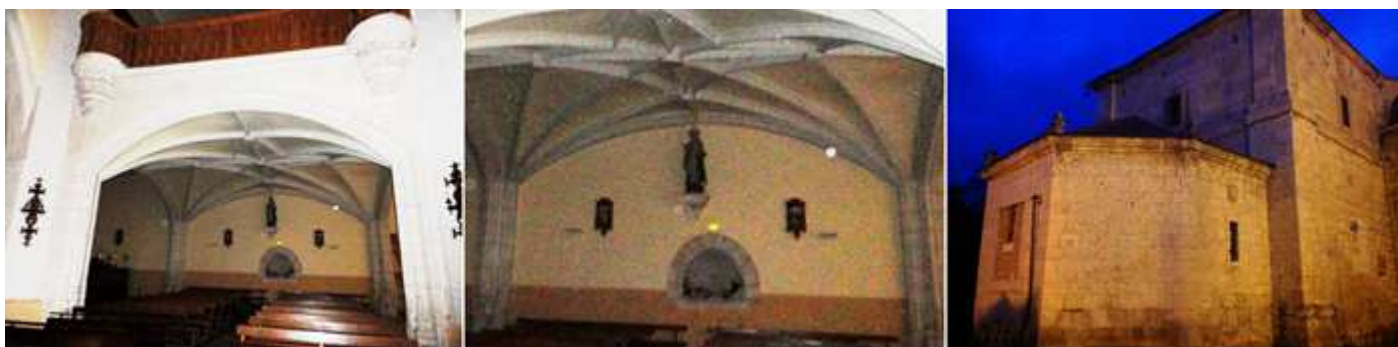
❶ El coro alto sobre un arco rebajado a los pies del templo. ❷ Al fondo una hornacina con forma de arco se encuentra la talla de Jesucristo yacente. ❸ Lateral exterior del templo.
