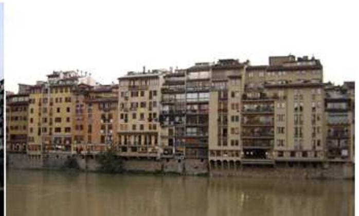
2 Algunas construcciones en las márgenes del río Arno.
