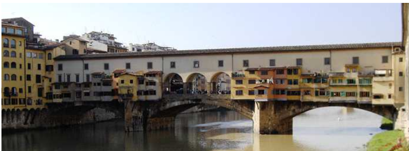
❶ Cuenta con tres grandes arcadas sobre el río Arno y algunas de sus construcciones sobresalen por lo laterales del propio puente. Inicialmente fue un puente de madera y luego en piedra, después de la inundación de 1333 se reconstruyó en 1345. Sus arcadas minen 27, 30 y 27m respectivamente.
