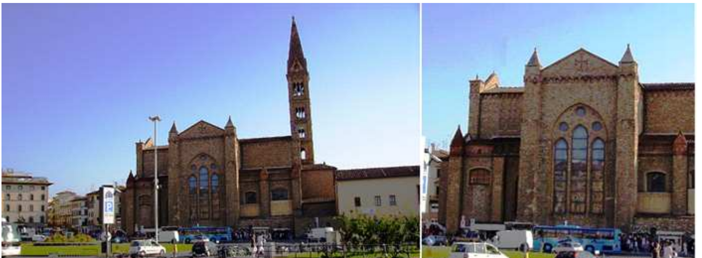
❶ Lateral del templo sobre la plaza de la Estación y su elevado campanario de planta cuadrada. ❷ Lateral con el brazo del crucero epistolar abierto con tres amplios ventanales apuntados.
