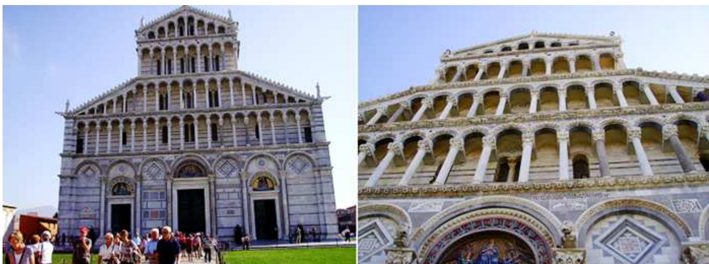
❶ Esta fachada frente al baptisterio se termino de construir en el S. XIII. ❷ Sobre sus puertas dispone de cuatro cuerpos de galerías profusamente decoradas sus arcos, capiteles, impostas y relieves.
