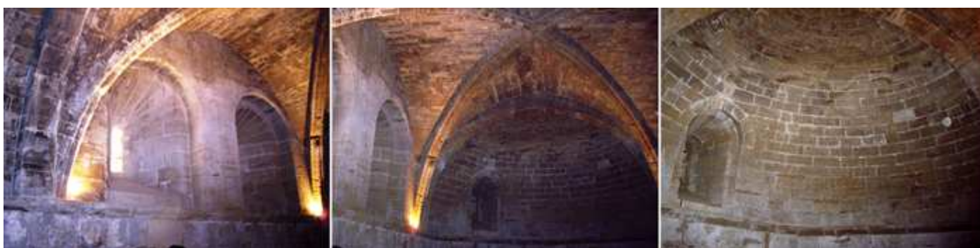
❺ Lateral izquierdo frente a las escaleras y con dos ventanas que dan al exterior de la calle Nuestra Señora de Cillas. ❻ Cabecera semicircular con otra ventana a la izquierda. ❽ Arco fajón de la cabecera y toda la sala esta recorrida por una imposta.
