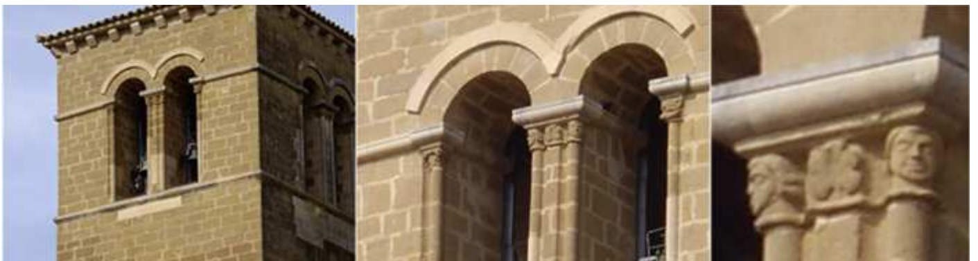
❶ Detalles de esta torre, con sus ventanas de arcos de medio punto con columnitas y capiteles decorados con figuras vegetales y humanas. ❷ Sus dobles ventanas con un guardapolvo liso y una imposta corrida por debajo y a la altura de sus capiteles otra. ❸ Decoración de los capiteles corridos para sus columnillas.
