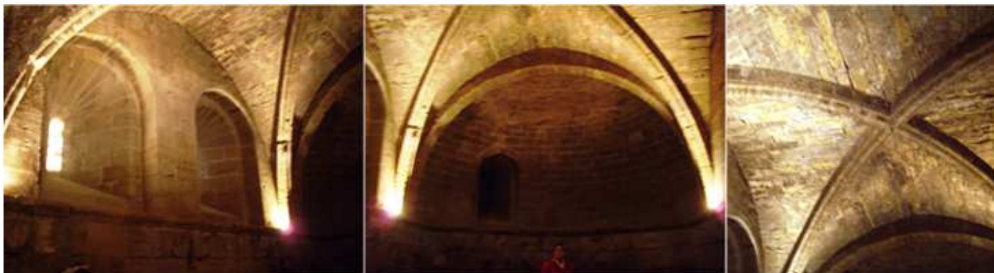
❶ Sala de la Campana, con ventanas de medio punto muy abocinadas. ❷ Con bóveda de crucería. ❸ Con nervios baquetonados.
