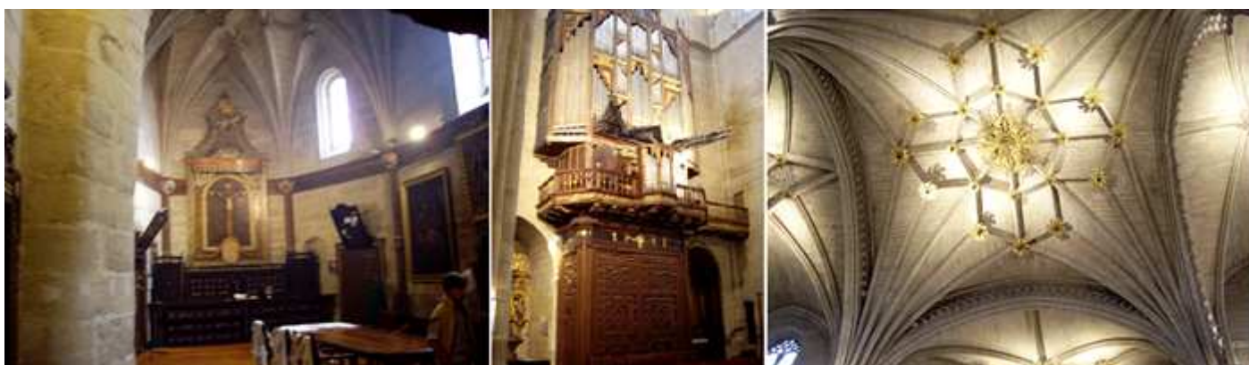
❶ Sacristía. ❷ El órgano del S. XVIII sobre el cajón de entrada epistolar. ❸ Bóveda estrellada de uno de los tramos de la nave central.
