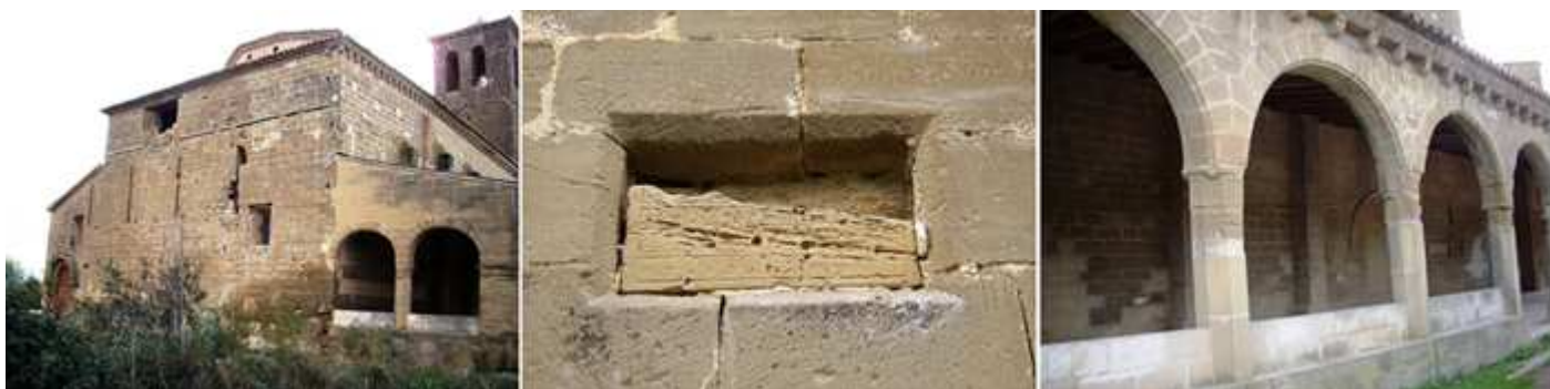
❶ Cabecera recta del templo con la puerta anterior. Donde se aprecian tres ventanas alargadas de arpillera, dos adinteladas y una superior parcial. ❷ Vano con una lauda sepulcral fragmentada. ❸ El pórtico abierto con arcos de medio punto.
