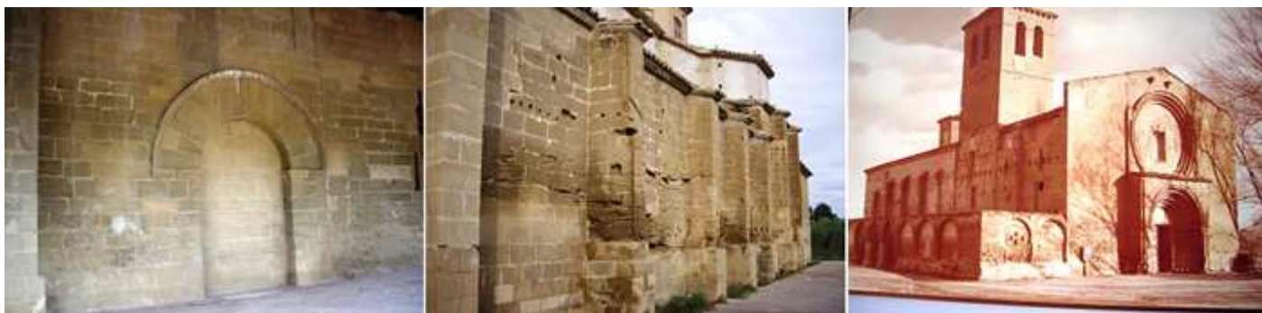
❶ En el interior del pórtico tiene esta puerta que da al lado del Evangelio. ❷ Contrafuertes en el exterior del lado epistolar. ❸ Imagen retrospectiva de Salas.
