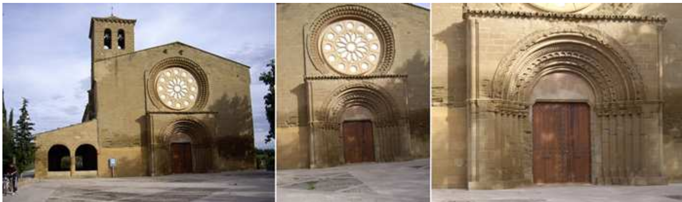
❶ Fachada de la Iglesia de Santa Mará de Salas, en el lado de poniente. ❷ Donde predomina su rosetón y la trabajada portada. ❸ Su portada de seis arquivoltas, que apean en sendos capiteles.
