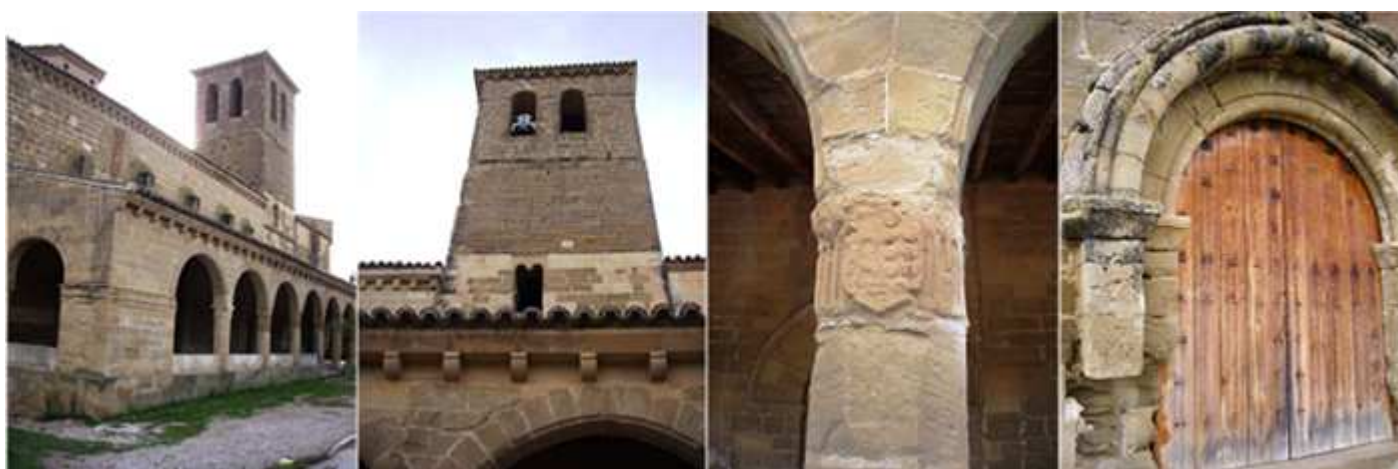
❶ Detalle del pórtico y la torre ❷ En este lado apreciamos una ventana germinada que ha perdido su mainel. ❸ Escudo en una columna del porche. ❹ Y una puerta posterior de medio punto con dos arquivoltas sobre una imposta corrida.
