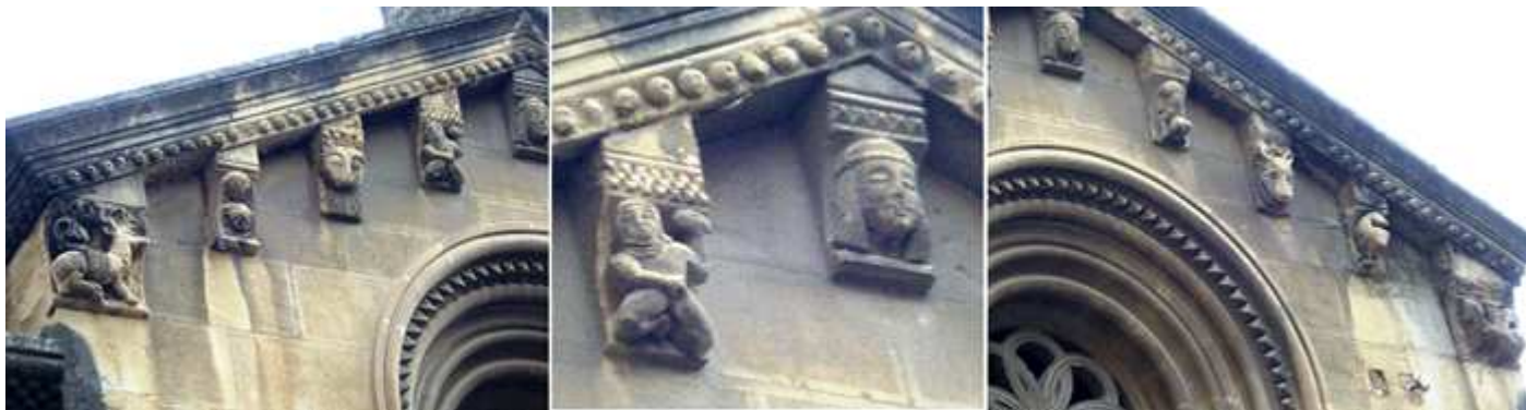
❶ La parte superior de la portada es a dos aguas y su alero dispone de canecillos y decoración a bolas. ❷ Canecillos diferentes con imágenes humanas, animales y figuras geométricas. ❸ Su óculo baquetonado y decorado con puntas de diamante teniendo el interior unos lazos entrelazados y en el centro una rosácea hexapétala.
