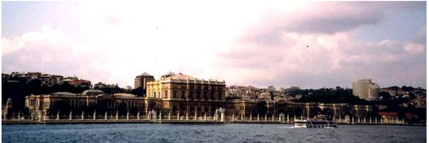
❶ La fachada que da al Bósforo tiene una dimensión de 600m.
