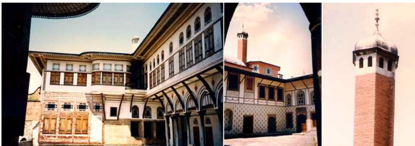
❶ Otra de las terrazas del palacio Topkapı. El patio y estancias de las Favoritas. ❷ Rincón con otra de las torres del palacio. ❸ Construida en ladrillo con planta hexagonal.
