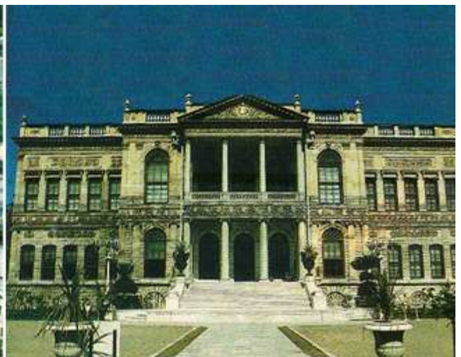
❷ Fachada de la parte Administrativa, el palacio tiene unas
