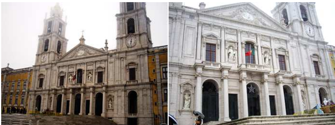
1 La fachada posee una anchura de 220 m, de largo. De la colección de campanas con dos carrillones, se pueden escuchar hasta en 20 km. 2 Las habitaciones palaciegas dan todas a esta fachada.
