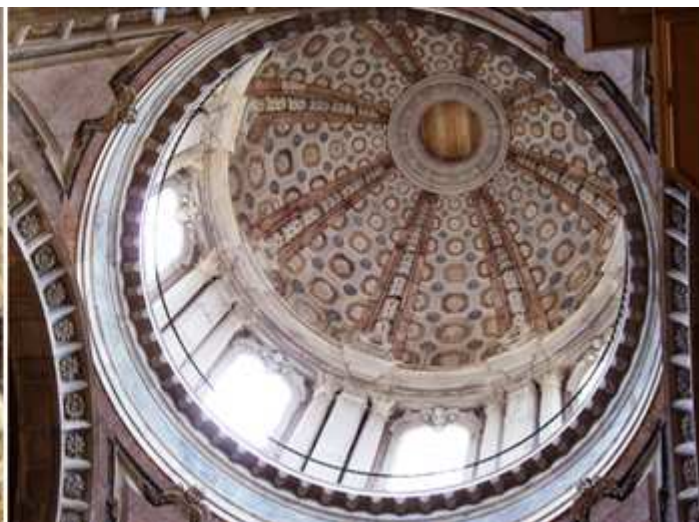
❹ La enorme cúpula del crucero con ocho gajos y ventanas. Con 65 m de altura y un diámetro de 13m. Fue la primera en construirse en Portugal y necesitó dos años de trabajo para terminarla.
