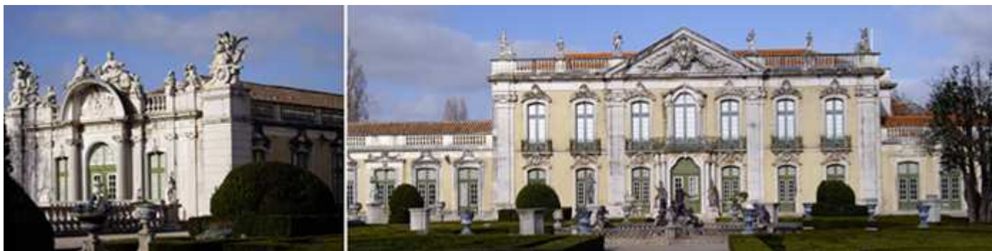
❶ Lateral izquierdo con el Pabellón Robillón. ❷ El ala con la fachada de las Ceremonias, situada en esta parte central. Toda la balaustrada tiene tres estatuas a cada lado.
