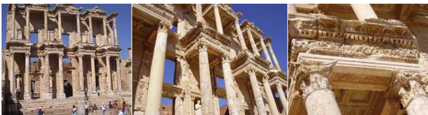
❶ Fachada de dos alturas con cuatro bloques de columnas, que cada bloque dispone de una hornacina con una escultura. ❷ Las estatuas de la planta baja, simbolizan la sabiduría (Sophia), conocimiento (Episteme), la inteligencia (Ennoia) y valor (Arete). ❸ Detalle de los capiteles y del friso que sostienen del segundo piso.
