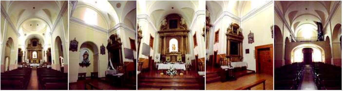
❶ Nave única. ❷ Capillas del crucero del lado epistolar. ❸ Altar Mayor con la Virgen del Carmen una talla barroca. ❹ Lado derecho del crucero. ❺ Parte inferior del templo con el coro y órgano elevado.
