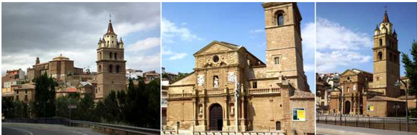
1 Panorámica desde el puente del Cidacos. 2 Fachada principal realizada entre 1680 y 1700, tiene forma de retablo barroco. 3 La torre fue terminada en 1532, y más tarde se complementó con los chapiteles. En la parte derecha de la fachada se encuentra el edificio de los Aniversarios.
