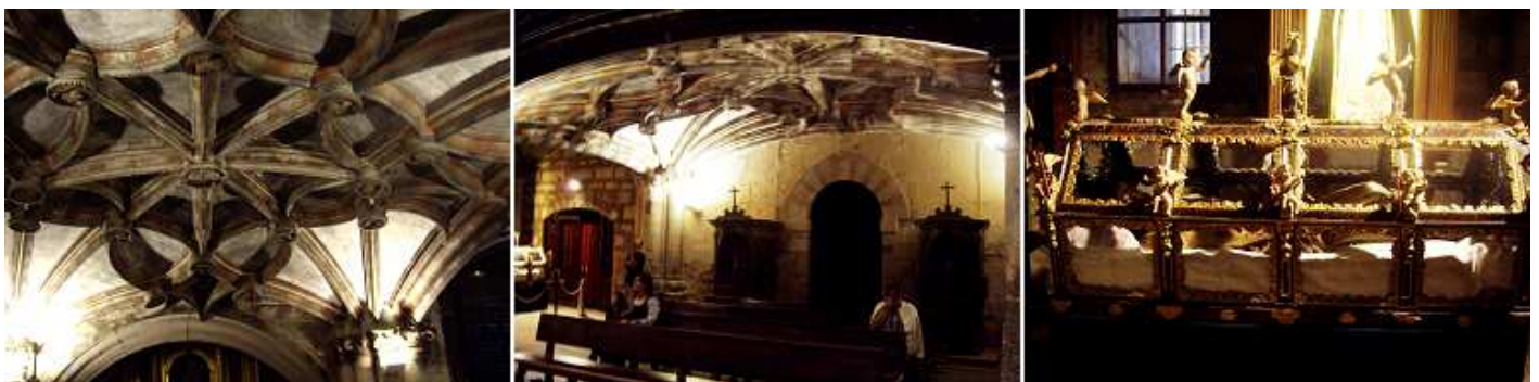
1 Bóveda de crucería del arco rebajado del coro 2 Parte inferior del templo bajo el coro. 3 En el lado de la Epístola de esta parte del templo se encuentra este Cristo yacente.
