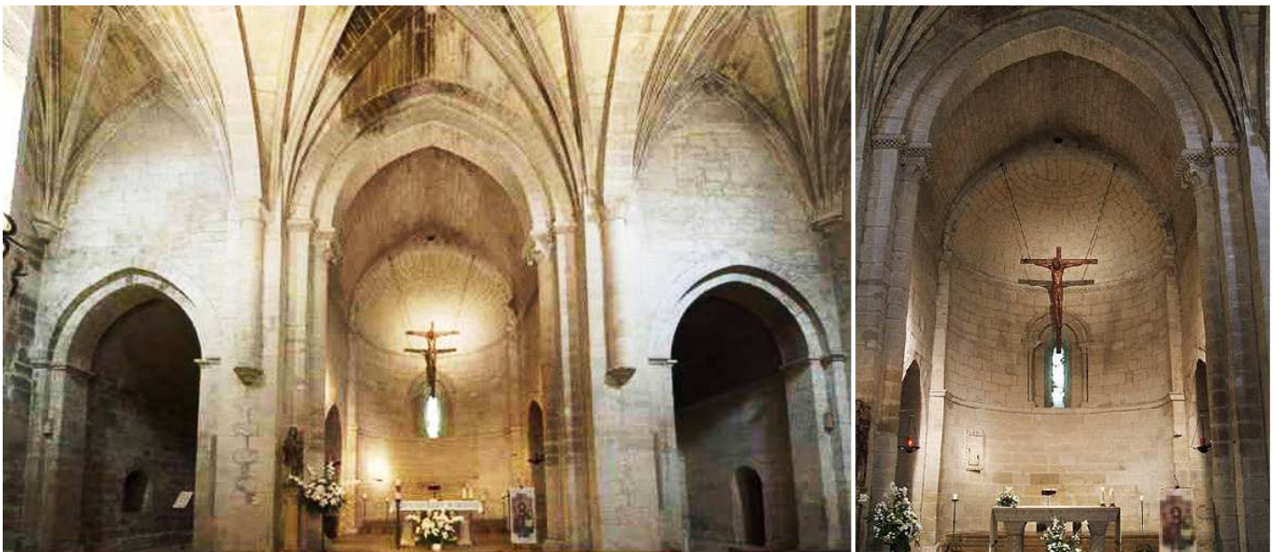
❶ Cabecera del templo con su ábside central con arcos apuntados y su bóveda de crucería ❷ Detalle del mismo con una ventana de medio punto con arquivolta y columnillas, sobre una imposta corrida.
