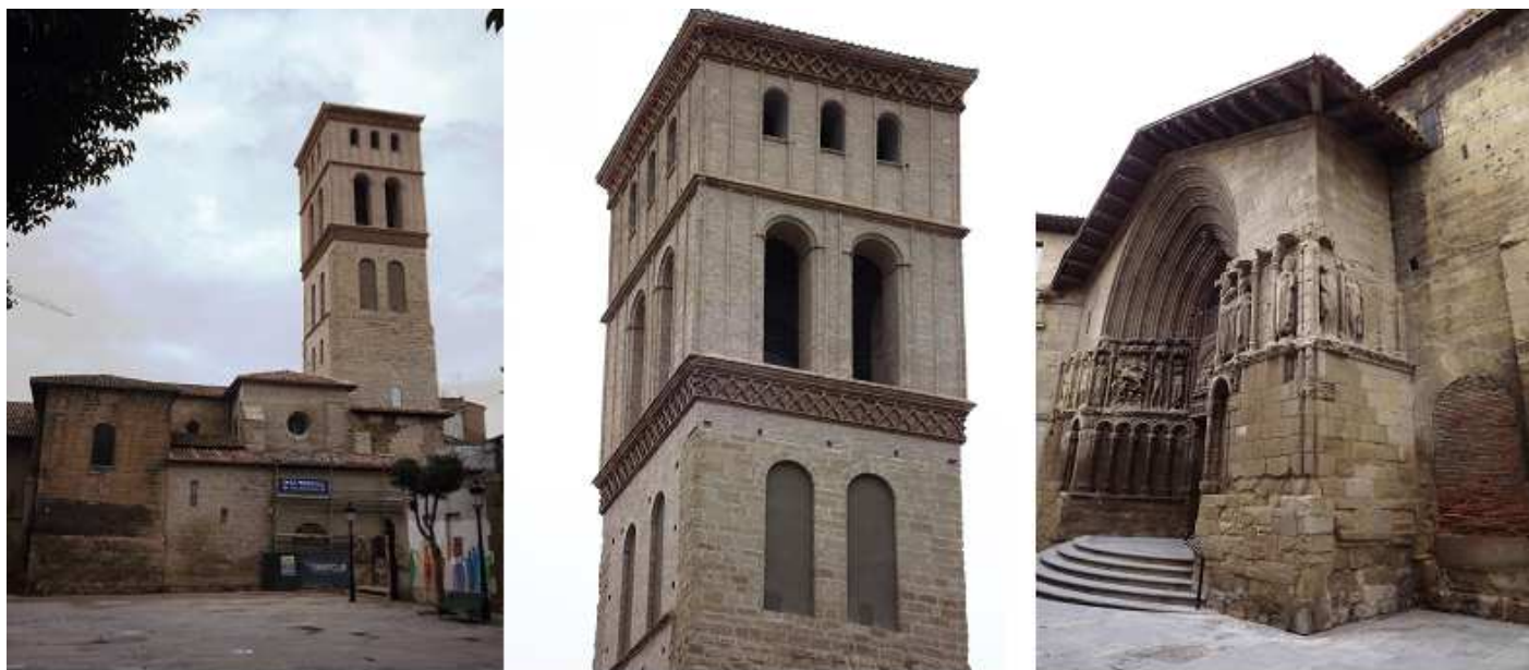
1 La iglesia ante la plaza, que al retirar el edificio colindante da imagen mucho más interesante del templo. 2 Dos últimos cuerpos de la torre realizados en ladrillo. La base es construcción románica. 3 Detalle de la portada con un amplio alero y un tramo de escaleras.
