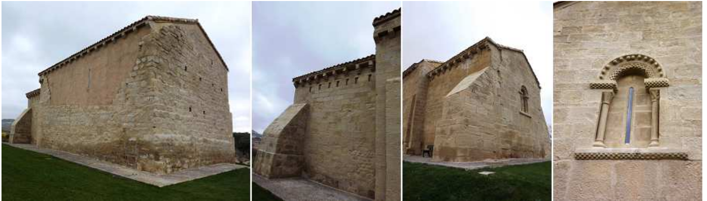
❶ Lateral del Evangelio con canecillos lisos. ❷ El alero de su cabecera esta con canecillos de rollos o cilindros. ❸ En la cabecera, está dotada de dos grandes contrafuertes. ❹ Ventana ábside con arquivolta que descansa en imposta, ambas con decoración de taqueado jaqués.
