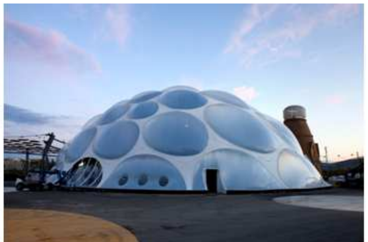
❸ Y otra visión del edificio con menos luz solar.
