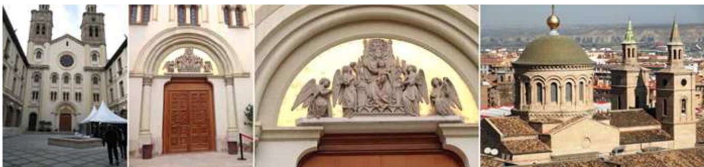
1 Fachada de la iglesia (desacralizada) en el centro del edificio. 2 Con una puerta de medio punto. En su interior se encuentra el Salón de la Corona. 3 Que posee un tímpano con una Virgen sedente con el Niño sobre su regazo y acompañada por cuatro ángeles. 4 Cúpula del crucero y sus torres, tomada desde la terraza del museo Pablo Serrano.
