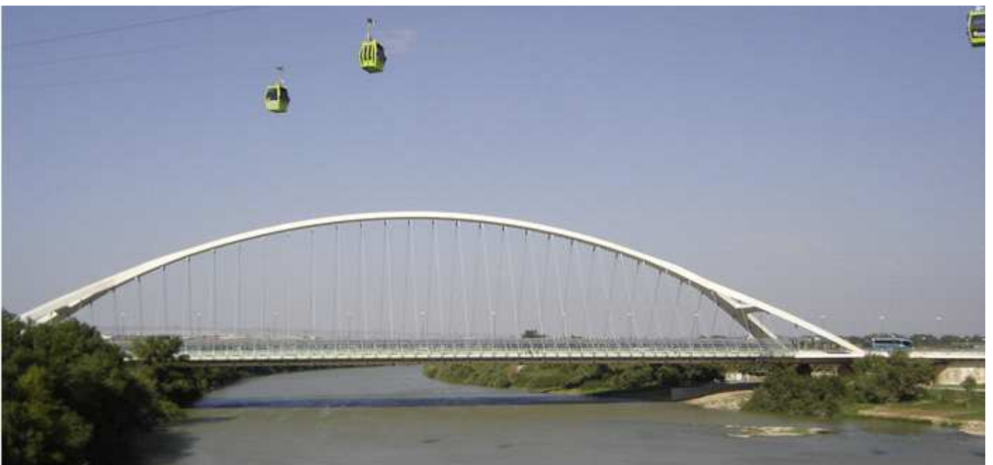
① Puente del Tercer Milenio. Que conecta los barrios de Las Delicias y La Almozara con el barrio del ACTUR -Rey Fernando. Es el mayor puente de arco en hormigón suspendido del mundo.
