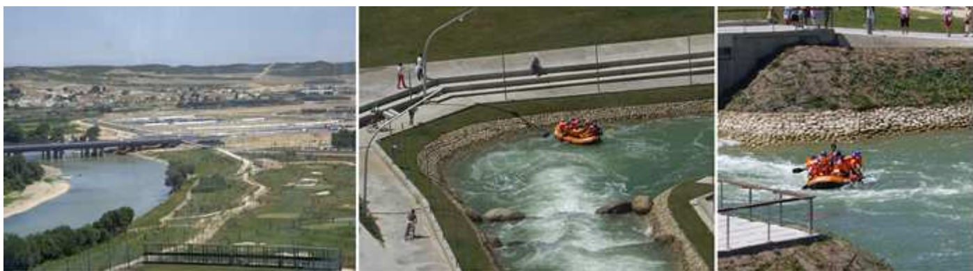
❶ La Autopista A-2 y abajo las instalaciones del Golf. ❷ El curso del Canal de aguas bravas. ❸ Otro tramo junto a la Torre del Agua.
