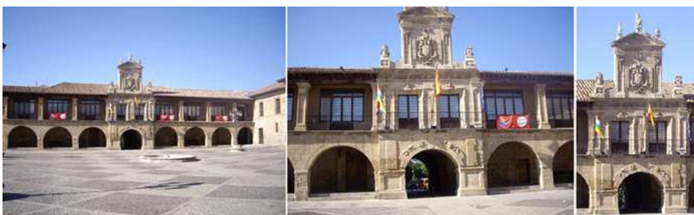
❶ Plaza de España S. XVIII. Construcción barroca con soportales y sobre los balcones centrales una espadaña. ❷ A este lugar se traslado la casa consistorial edificando sobre este arco de la puerta de las murallas desde la plaza del Santo. ❸ El edificio cuenta con dos plantas, la inferior porticada y la superior con galerías cerradas salvo la parte central que dispone de un balcón corrido construido sobre el arco transitable en piedra con sus puertas dinteladas orladas y con angelotes en su clave central y sobre el alero una espadaña que en su cuerpo central está el escudo de Felipe V y sobre el mismo un frontón con la escultura de la diosa de la Fama.
