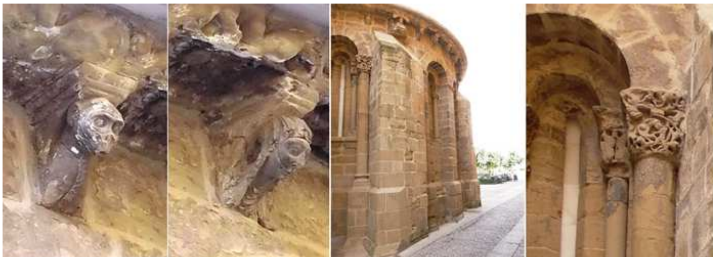
1 Canecillo con la cara de un mono. 2 Este con la de una mujer con velo. 3 El absidiolo central que corresponde a la capilla de San Pedro, con dos gruesos contrafuertes que separan los tres paños con dobles ventanas con columnillas y capiteles. 4 Detalle de uno de sus capiteles historiados y la imposta corrida del pilar central de los arcos.
