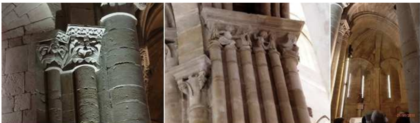
❶ Dos capiteles románicos, uno con dos aves y el otro con dos caras humanas enfrentadas. ❷ Capiteles a modo de frisos sobre las columnillas. ❸ Capilla de San Pedro con ventanas con doble derrame.
