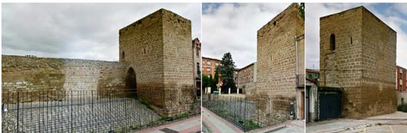
❶ Lienzo y torreón en la calle Sor María de Leiva. Con una de sus puertas de recodo. ❷ Tramos que fueron restaurados en el año 2006 y 2009. ❸ Torreón en la Avda. de Calahorra a la altura del nº 29.
