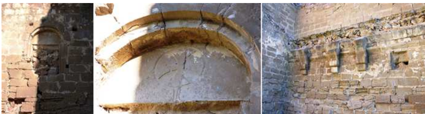
❶ Detalle de una ventana o nicho de medio punto en el muro de la nave ❷ Detalle de la parte superior de la misma que conserva su tímpano con una cruz patada con brazos curvilíneos. ❸ Arranques de los arcos fajones de la sala capitular.
