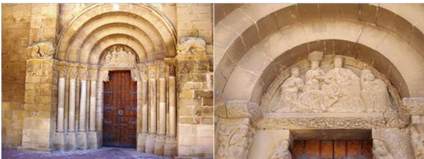
1 Portada en los pies del templo al oeste entre los contrafuertes y con un tejazoz. 2 Sus arquivoltas están si decorar en arista, pero le aportan un abocinamiento a la misma.
