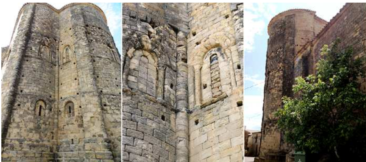
❶ Los gruesos contrafuertes, llegan casi hasta el alero que es liso sin canecillos. ❷ Otras dos ventanas cegadas. ❸ Y el tercer ábside, dando este a la calle que nos lleva a la ermita de Nuestra Señora de Puyal.
