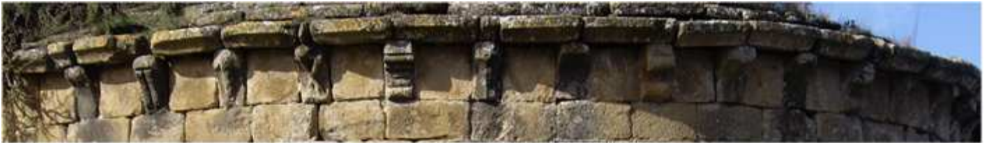
❸ Vista de los canecillos que nos encontramos en el ábside.
