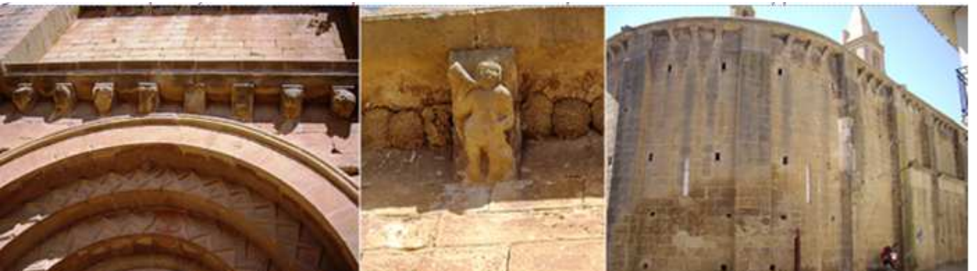
❶ Las arquivoltas centrales Las centrales tienen decoración de triple zigzag y de rombos. ❷ Detalle de un canecillo del tejeroz. ❸ Vista de ábside exterior con dos ventanas de aspillera.
