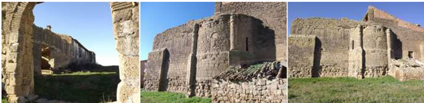
❶ Arco de entrada del muro perimetral parcialmente derruido. ❷ Lateral de la iglesia con una parte de su ábside. ❸ Otra imagen de esta parte del templo.
