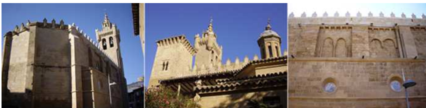
1 Ábside poligonal con cubierta de horno. 2 Detalle de su lateral al paseo del Muro. 3 Y de los arcos ciegos en este paño en la fachada norte.
