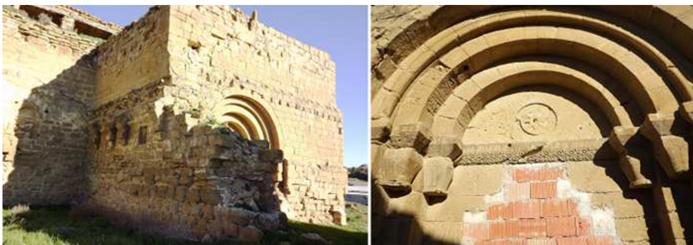
❶ Colindante con el crucero se encuentran los restos de su sala capitular de la que quedan los arranques de sus arcos, y una ventana de medio punto colindante con la nave de la iglesia. ❷ Su portada con cuatro arquivoltas y tímpano con crismón sobre ménsulas.
