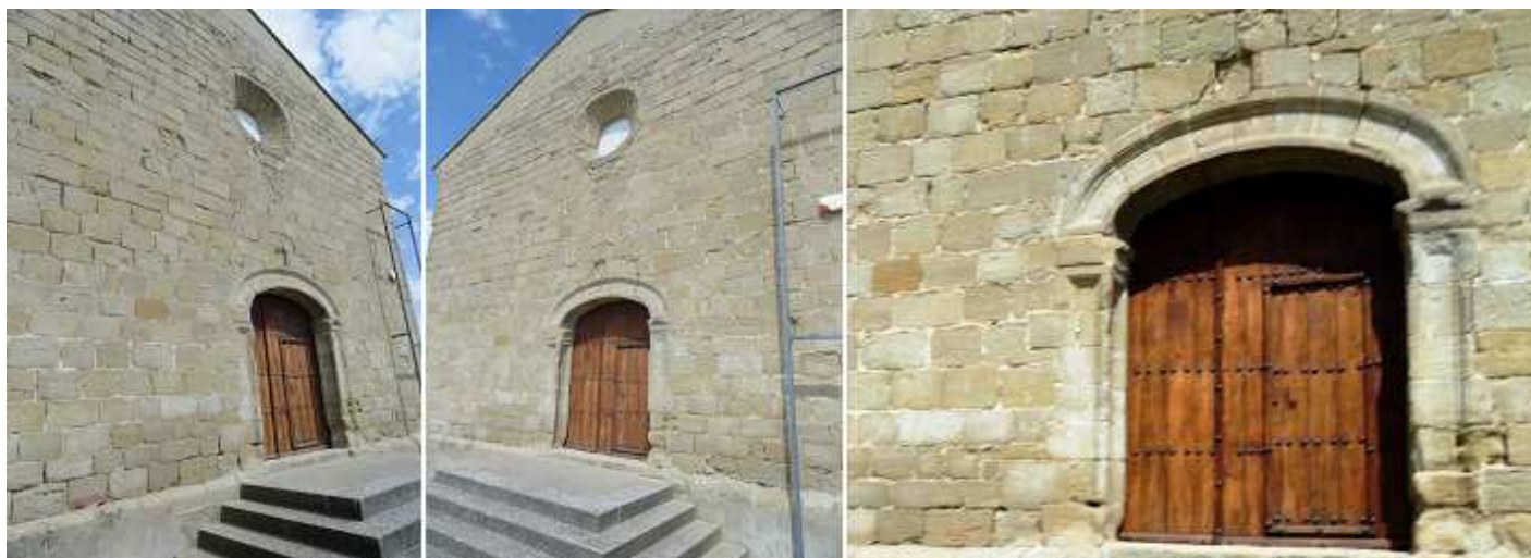
❶ Su fachada muy simple con una puerta y un óculo sobre la misma. ❷ Y una grada de escaleras. ❸ Su puerta con un arco rebajado.
