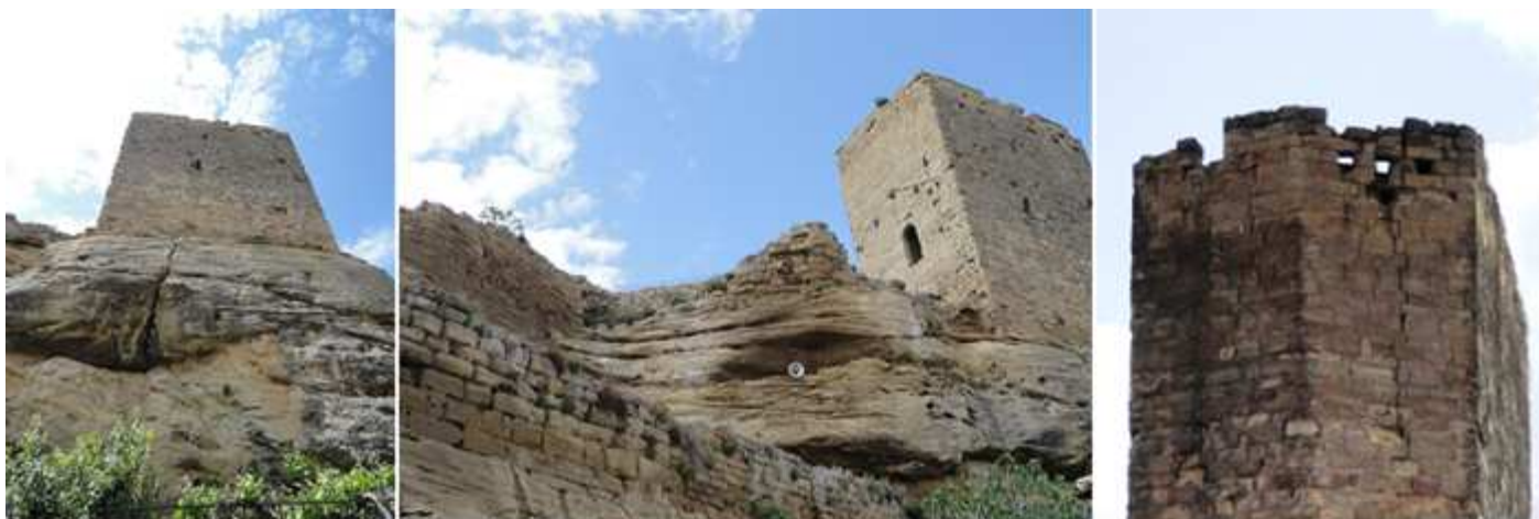
1 Sobre un gran bloque pétreo es este escarpado rocoso que está encima del pueblo. 2 Algunas partes de sus murallas ya totalmente desmochadas. 3 otra de las caras de su torre.
