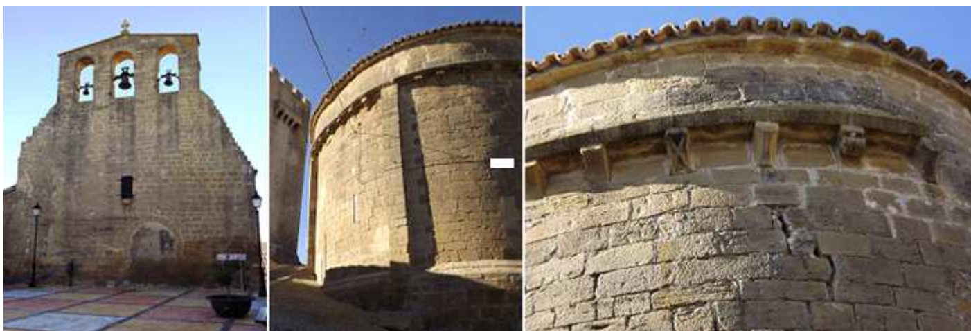
1 Fachada de Santo Tomás de Canterbury. 2 Ábside con columnas adosada de sección cuadrada. 3 Detalle del ábside y sus variados canecillos.
