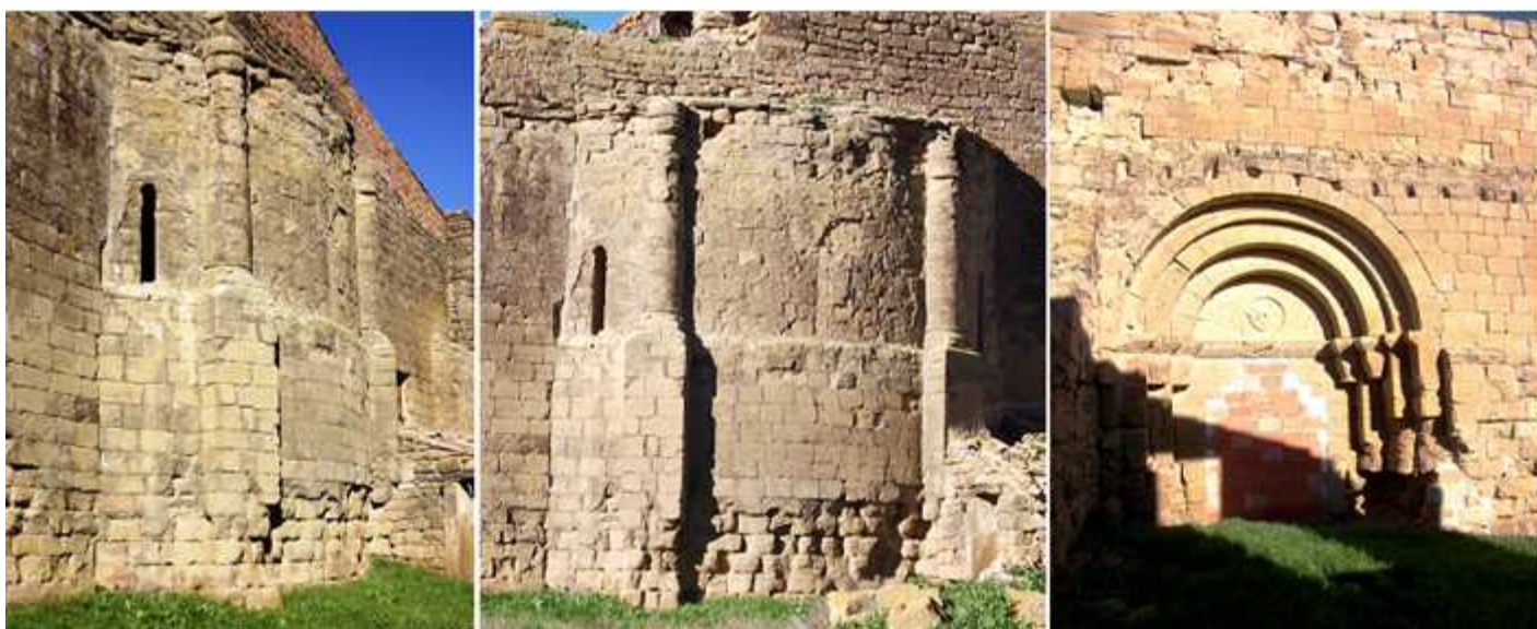
❶ Lateral del lado de su cabecera con el ábside. ❷ Su ábside con una gran basa con dos columnas contrafuertes cuadradas, para convertirse en circulares en la parte superior, y abiertas con tres ventanas de derrame interior, estado la central cegada. ❸ La portada en la prolongación del crucero en el lado de Epístola.
