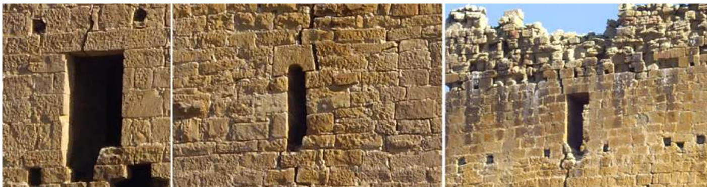
1 Uno de los vanos adintelados en su frontal sobre la puerta. 2 Y un ejemplo de sus saeteras. 3 Otra de su parte posterior.
