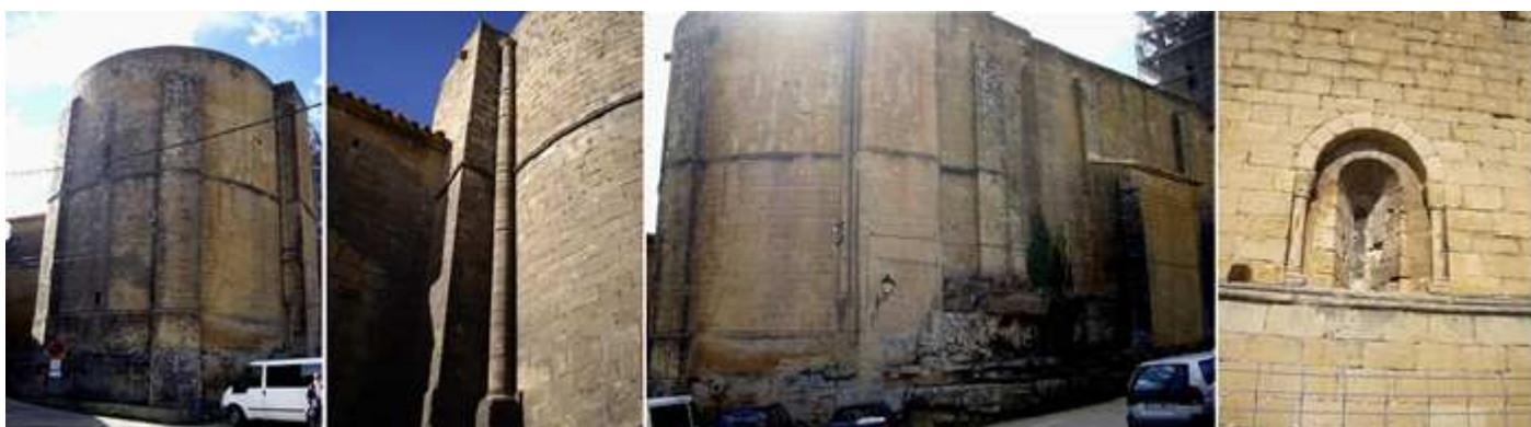
❶ Su ábside semicircular con una altura notable. ❷ Columna cilíndrica adosada al ábside. ❸ Lateral del Evangelio con el resalte de una de sus capillas laterales. ❹ Ventana con derrame exterior en la parte baja del ábside que da a la cripta.
