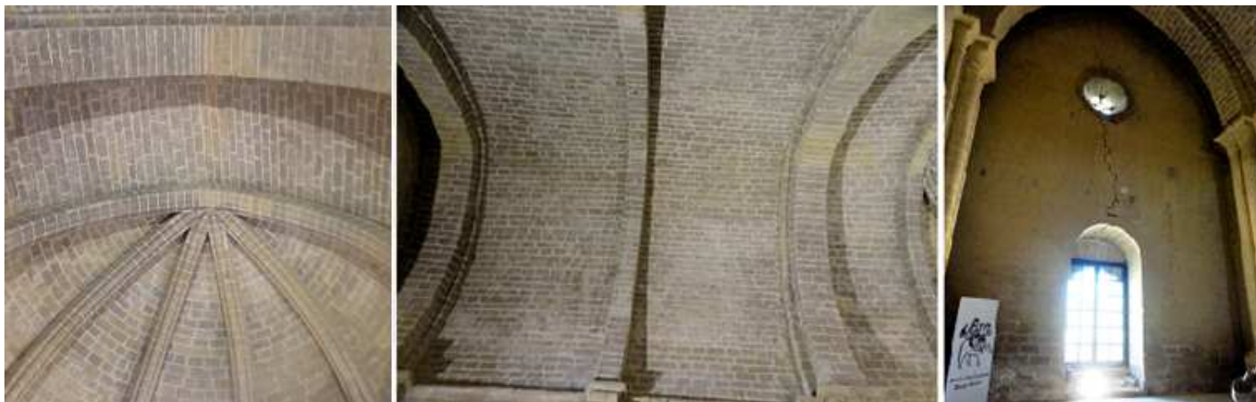
❶ Detalle central del arco triunfal y de la bóveda de la cabecera. ❷ Con arcos apuntados se sostiene la bóveda de la nave. ❸ Detalle de la parte inferior del templo y la limitada dimensión entre el arco y el muro como si esta iglesia tuviera prevista una mayor dimensión y se cerró anticipadamente
