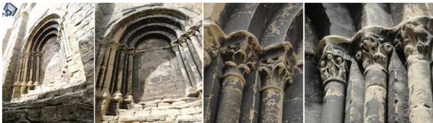
❶ La puerta con cuatro arquivoltas y un leve guardapolvo que descansan sobre las cuatro capiteles con columnas. ❷ La puerta para adaptarse parcialmente al desnivel dispone de una grada de escalones. ❸ Los capiteles del lado izquierdo más interiores. ❹ Y los tres primeros de lado opuesto izquierdo.
