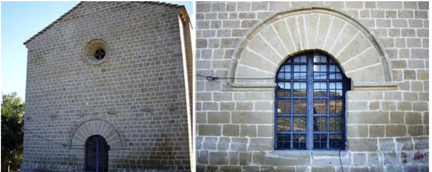
① Portada a los pies de la iglesia y con un óculo en su parte superior. ② Con grandes dovelas lisas en su arco y cerrado con un guarda lluvias y las impostas.
