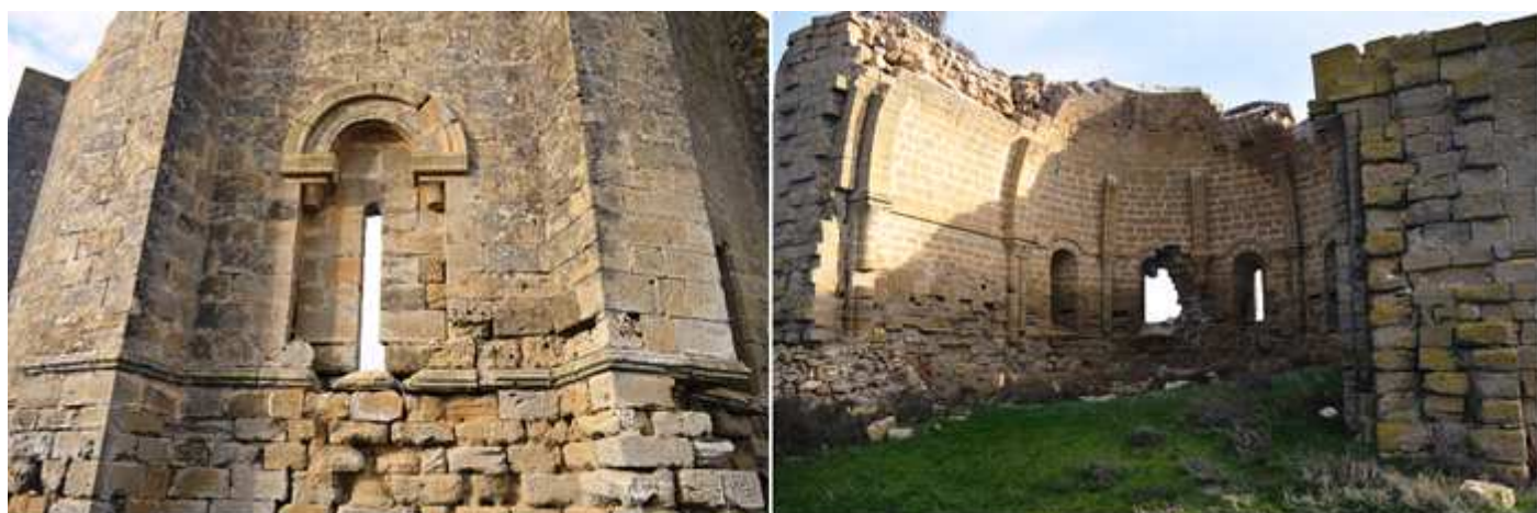
📍 Una de sus ventanas del ábside ente gruesos contrafuertes, dotada con arquivolta y guardapolvo baquetomados sobre imposta y con capiteles lisos a los que les falta sus columnillas. 📍 Por su parte interior se puede apreciar el cascarón absidal con las cinco ventanas que posee entre dos impostas. Fotos: Javier Pérez Malón.
