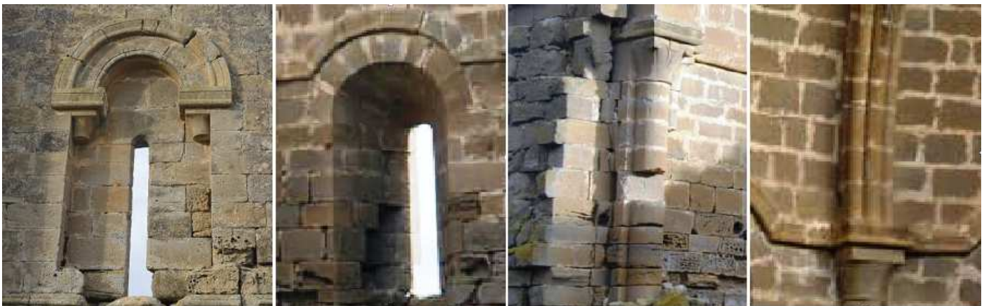
❷ Detalle de una de sus ventanas por el lado exterior. ❸ Detalle de una interior con gran derrame y la imposta superior que las recorre que posee una decoración de dientes de sierra en la parte interior de la misma. ❹ Columna y capitel con palmetas del presbiterio. ❺ Y los nervios del ábside y sus capiteles lisos. Fotos: Javier Pérez Malón.
