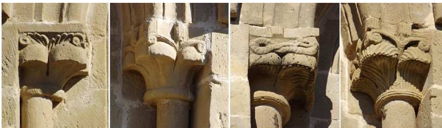
❶ - ❷ Capiteles de la ventana exterior del lado epistolar. ❸ - ❹ Capiteles de la ventana del ábside.
