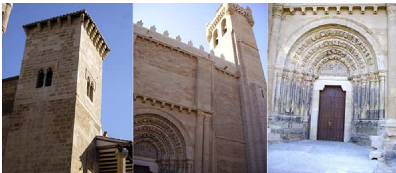
❶ Torre gótica. ❷ - ❸ Fachada de la portada norte que da a la calle Mediavilla y su portada con cinco arquivoltas historiadas.
