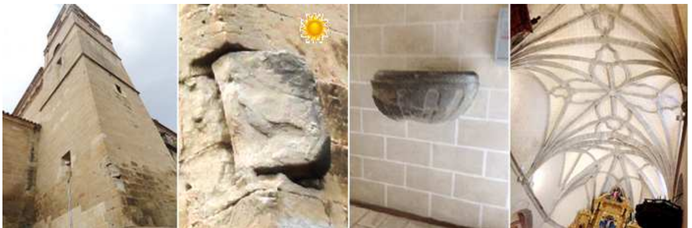
1 Perspectiva de su torre de planta cuadrada adosada al lateral epistolar junto a su puerta lateral, es de cuatro cuerpos. 2 En el ángulo inferior del primer cuerpo se aprecia los restos del bloque de piedra que se ha fragmentado y poseía un reloj de Sol. 3 Pila de agua bendita de piedra semicircular con los gallones excavados planos y sin mucho relieve en su exterior, esta encastara a la entrada de su puerta epistolar. 4 La bóveda estrellada del templo.
