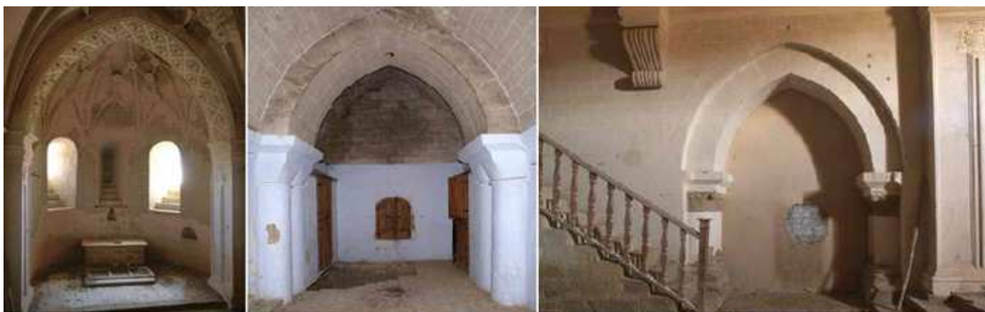
❶ Ábside con sus ventanas de gran derrame. ❷ Capilla norte del crucero, con arcos apuntados, sobre dobles columnas. ❸ Escalera de acceso a la planta superior de la nave del templo convertida en sala capitular. Fotos de J.L. Remón
