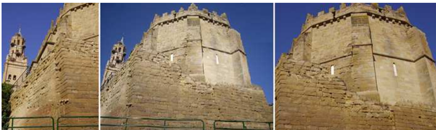
❶ Lateral epistolar junto a su cabecera. ❷ Esta es poligonal con grandes contrafuertes y coronada con almenas. ❸ Y con parte del recinto amurallado.
