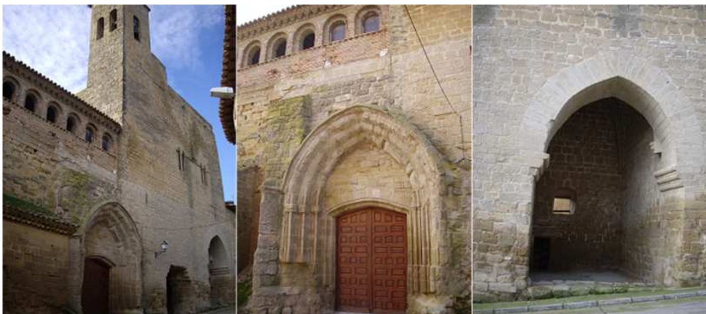
❶ Fachada donde se aprecia la iglesia adosada a la torre que da a la calle Mediodía. ❷ Puerta de arco apuntado con tres arquivoltas baquetonadas que se encuentran muy erosionadas de acceso a la iglesia. S. XIV. ❸ Esta es la puerta de la torre.
