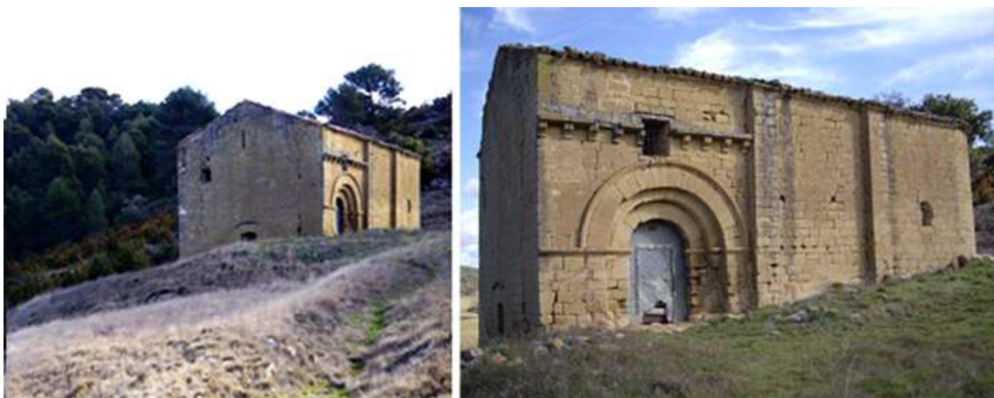
❶ Accediendo por la ladera, dadas las últimas lluvias, apenas se aprecia camino de acceso. ❷ Se encuentra a 200m del camino del castillo, con su portada en el primer tramo de la nave.
