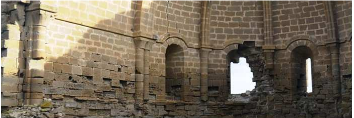
❶ Las columnas redondas adosadas, en el presbiterio con capiteles con palmetas y los arcos fajones con arista viva, en el ábside los nervios son baquetonados y capiteles lisos, sus ventanas con derrame interior. Fotos: Javier Pérez Malón.
