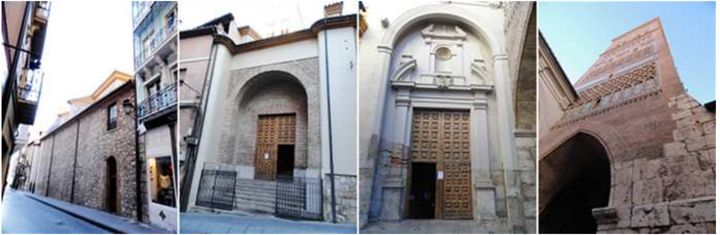
❶ Calle Nueva con el lateral exterior de la Epístola del templo y al fondo la puerta de este lado ❷ Puerta del lado epistolar con un arco de medio punto y unas escaleras para su ingreso. ❸ Esta es la puerta de la calle de el Salvador con un arco de medio punto y su puerta enmarcada con columnas y pilastras rectas, culminada con entablamento de frontis partido curvo con una hornacina vacía. ❹ Junto a la puerta se alza adosada la torre del templo, y que también tiene un pasadizo para la circulación de arco apuntado.
