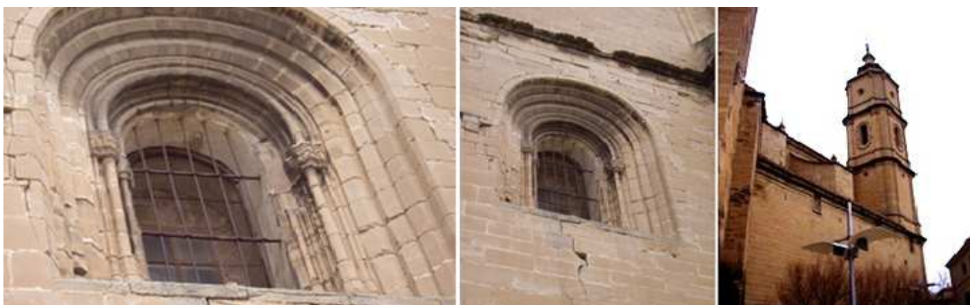
❶ - ❷ Primer plano de la ventana con sus arquivoltas y dos columnillas, en el frente y dos más finas en el fondo. ❸ Vista lateral.
