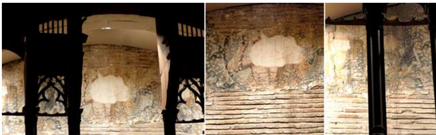
❶ Pinturas en el fondo de la pared del Coro. ❷ Otro plano de las pinturas. ❸ estas se pueden observar mejor subiéndolo a la torre
