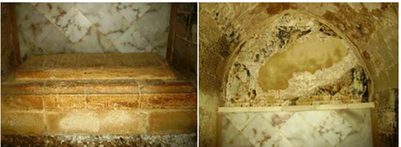
❶ Sarcófago en la parte inferior de la arcada .
