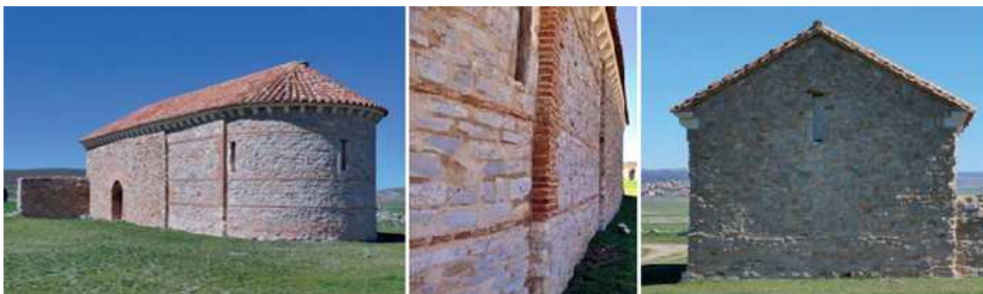
❶ Fachada de la Epístola con puerta de medio punto en ladrillo y su cabecera. Y está abierta con tres ventanales adintelados. ❷ Detalle de la construcción con cantería e hiladas de ladrillo en el presbiterio y cabecera. ❸ Hastial que posee una estrecha abertura adintelada. Fotos: https://www.editorialw.es/
