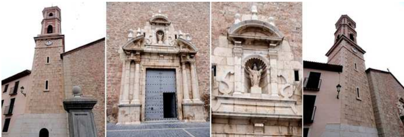
❶ A la izquierda de su fachada se sitúa la torre de planta cuadrada de tres cuerpos. ❷ Portada con puerta adintelada con dobles columnas redondas sobre pódium a los lados y sobre el entablamento un frontis curvo abierto con una hornacina. ❸ Hornacina avenerada con la imagen del Salvador. ❹ Los dos últimos cuerpos del campanario son octogonales.
