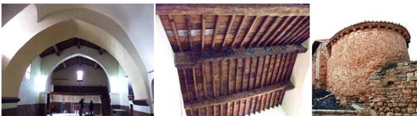
❶ Nave, dividida en dos tramos por un arco apuntado que se apoya. ❷ Con una cubierta de madera a dos aguas. ❸ Esta parte posterior es la que se amplía en el S. XVI.
