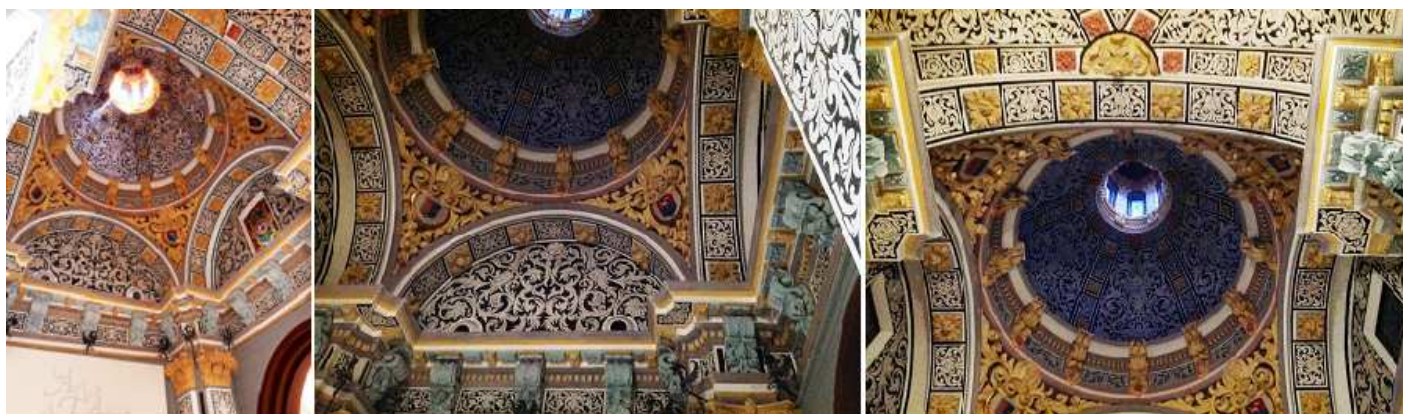
1 Cúpula de la capilla sobre el mausoleo con una linterna. 2 -3 Detalles de la profusa decoración de sus arcos pechinas, etc..
