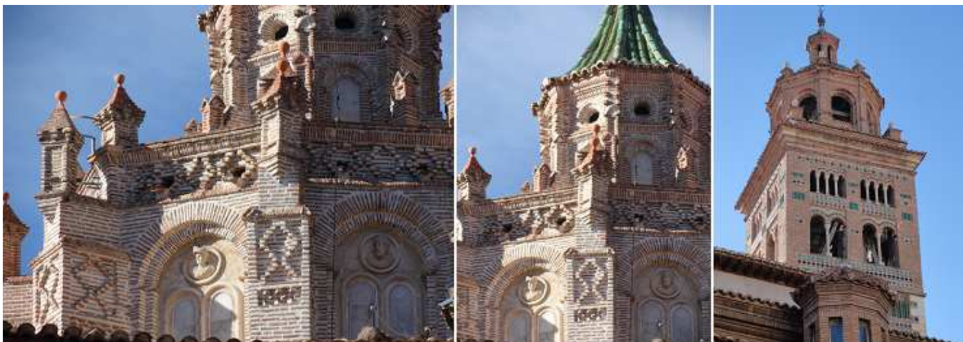
❶ - ❷ Dos detalles del cimborrio en su exterior donde se aprecian las labores con el ladrillo en contrafuertes y balaustradas. Los ventanales tienen unos maineles de piedra. ❸ Parte superior de la torre, compuesta por cuatro cuerpos y coronada con una linterna, está fechada en 1257, salvo la linterna del S. XVII.
