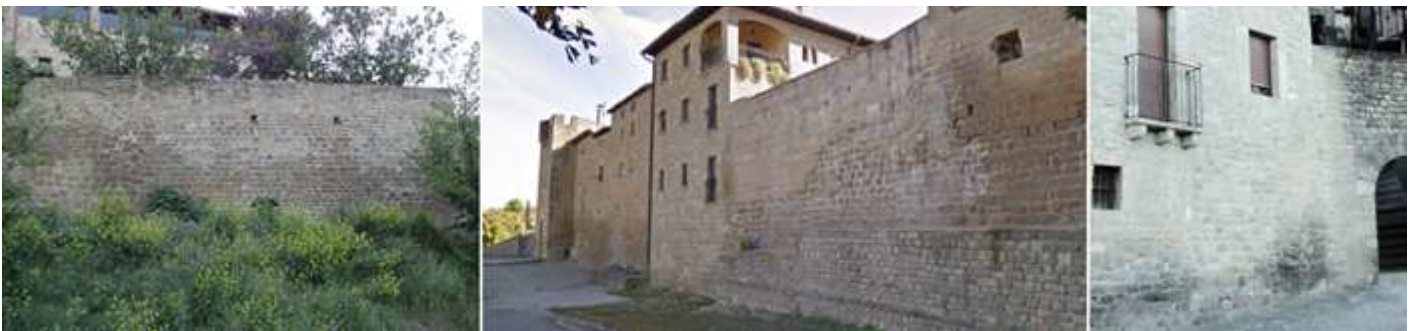
❶ Un lienzo suelto. ❷ Junto a la puerta de poniente en los muros de las murallas se han abierto con construcciones modernas. ❸ Otro ejemplo junto al portal de Levante.
