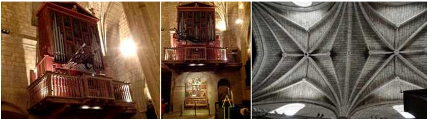
❶ En el lateral de la nave junto al coro está suspendido el órgano ❷ Bajo el órgano se encuentra la portada que está oculta por la capilla construida. ❸ Bóveda de la nave central.
