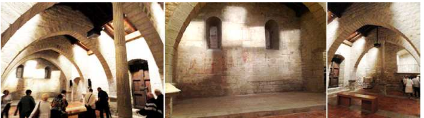
1 x. 2 · Ábside con las pinturas entre las dos ventanas de medio punto 3 Sustentada su cubierta a dos aguas con dos arcos apuntados, uno de ellos reforzado por una columna.
