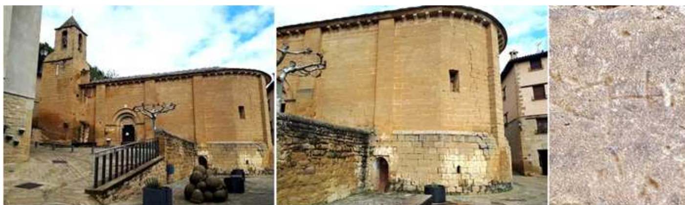
❶ Detalle de las dos plazas con el desnivel existente. Su campanario está abierto con un vano por cada cara. ❷ En la parte inferior de la cabecera su cripta con la finalidad de salvar el desnivel del terreno. Con su puerta de acceso independiente al de la iglesia. ❸ En sus muros aparecen diversas marcas de canteros y cruces. Fotos: Jesús Zarramaga.
