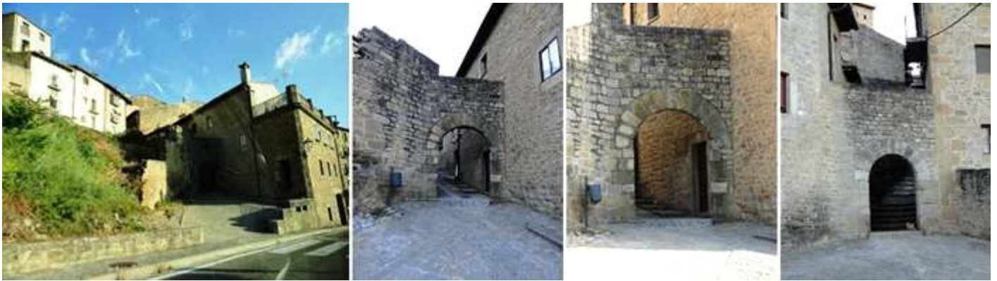
1 Portal de Uncastillo, es el primero que encontramos si tomamos la carretera A-127 de Zaragoza a Sangüesa 2 En un portal de medio punto sencillo. 3 Que sus dovelas están lisas. 4 Otro sencillo portal que sigue después, este es el de Levante
