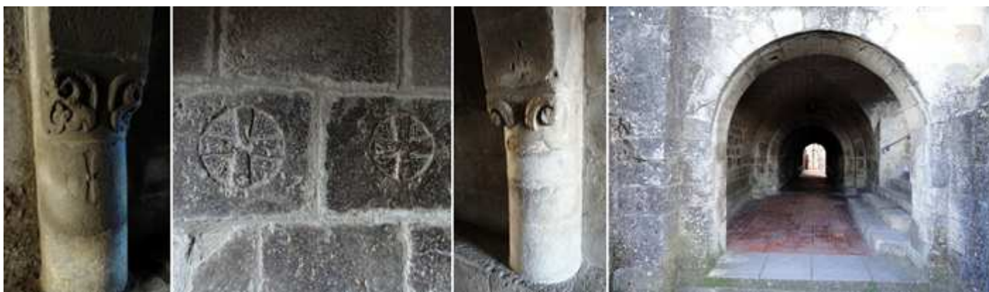
❶ Volutas y hojas vegetales. ❷ Diferentes cruces sobre sus muros y columnas como señal de enteramientos medievales. ❸ Otro capitel distinto. ❹ Entrada del pasadizo en la parte opuestas y a su derecha el acceso directo del mismo por unas escaleras a su portada.
