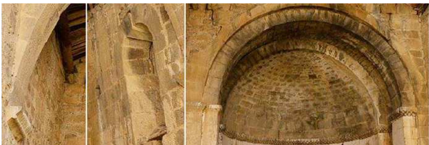
❶ Los arcos fajones arrancan sobre ménsulas sencillamente decoradas. ❷ En el lateral de la Epístola dispone de dos ventanas con derrame interior. ❸ Un arco triunfal precede a su cabecera sobre pilastras rectas con pódium y con impostas taqueadas. Su cabecera se completa con un arco triunfal con dovelas de aristas vivas. Fotos: Carlos Ripalda.
