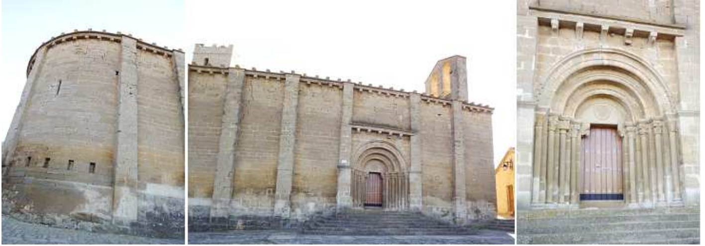
❶ Detalle de su ábside con columnas adosadas y ventanas de aspillera. ❷ Lateral del lado de su Evangelio donde se encuentra su portada entre los contrafuertes. ❸ Portada con cuatro arquivoltas.
