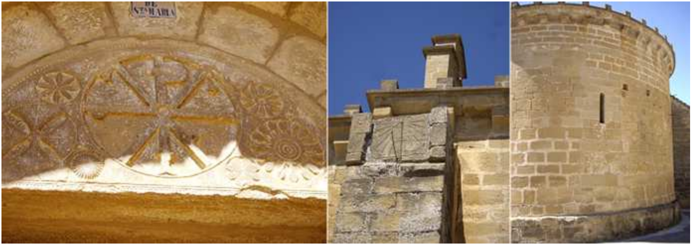
1 En la portada destaca el tímpano con un crismón rodeado de flores o estrellas inscritas en círculos 2 Detalle del reloj de sol en su lateral 3 Ábside semicircular abierto con una ventana de aspillera y su tejado con canecillos lisos.
