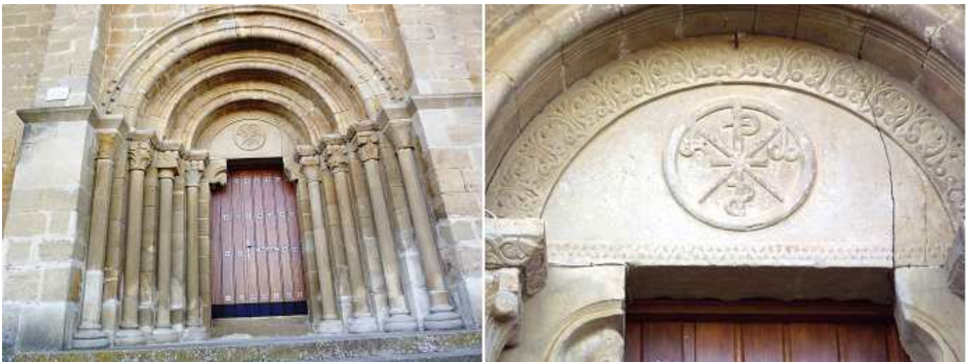
❶ Puerta principal situada entre contrafuertes en el muro norte. ❷ Sobre ménsulas dispone de un tímpano con un crismón en su centro y labrado en su contorno.
