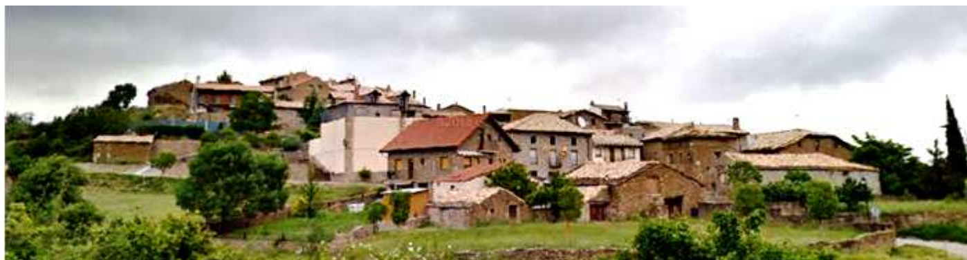
❶ Panorámica de la localidad de Bagüés.
