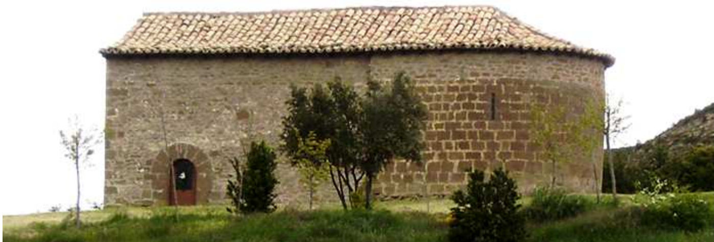
① Ermita del S. XI construida por Ramiro I en 1063, del templo original conserva su cabecera semicircular y el presbiterio, en sus muros posee dos cabezas incrustadas. Foto: Ayuntamiento Los Pintanos.
