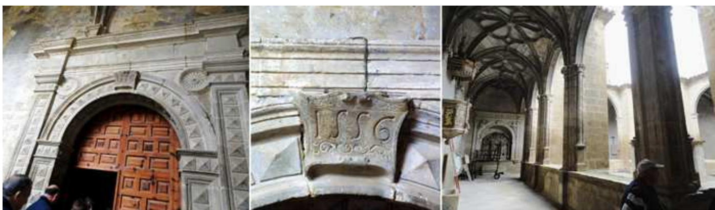
❶ Puerta con un arco de medio punto que al igual que sus columnas están decoradas con puntas de diamante. ❷ En la clave del arco de la puerta se encuentra la echa de sus construcción, 1556. ❸ Una de las pandas del claustro, donde se aprecian sus bóvedas de crucería.
