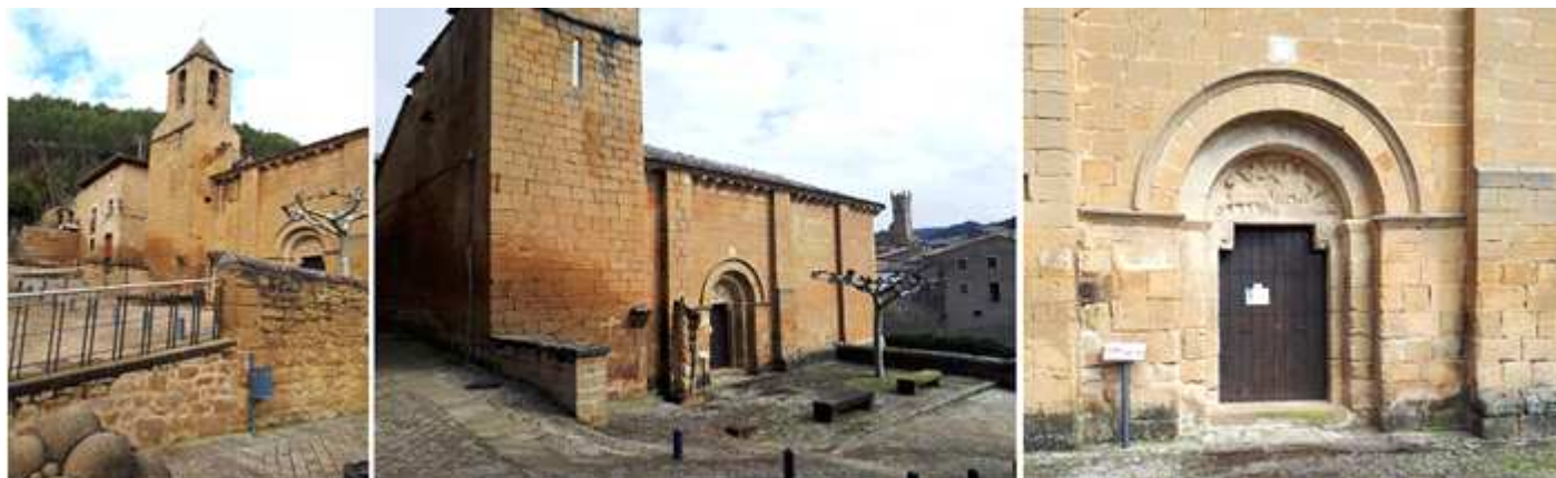
❶ Vista del templo desde la plaza inferior. ❷ Fachada del lateral epistolar con su portada situada en el segundo tramo de la nave. ❸ Esta puerta alojada entre los contrafuertes con dos arquivoltas de aristas vivas que reposan en una imposta biselada corrida y cubierta con un guardapolvo también biselado. Fotos: Jesús Zarramaga.
