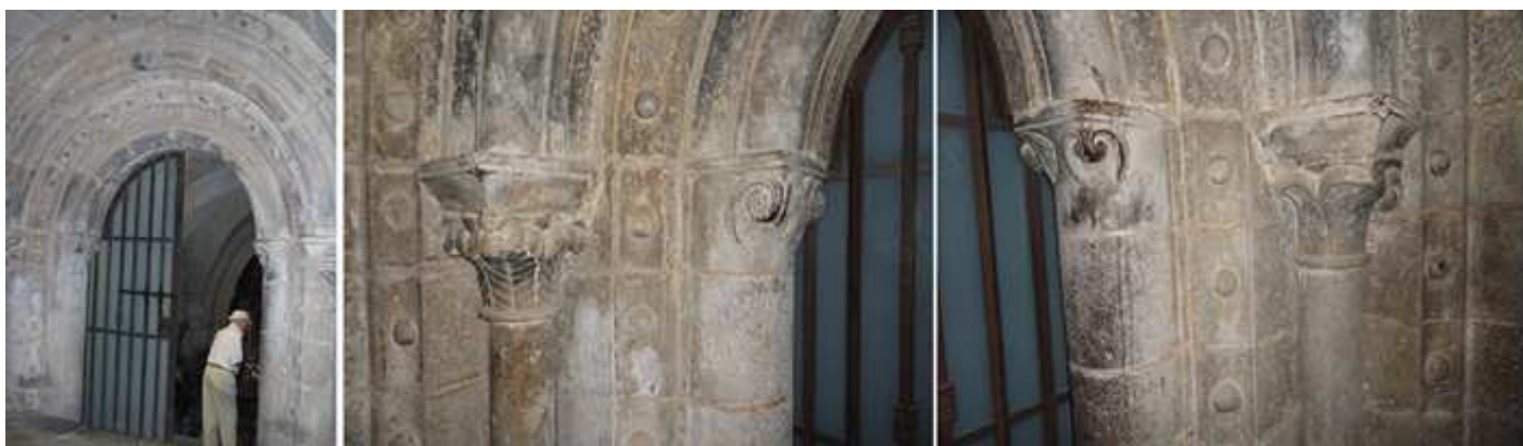
❶ Portada de medio punto de acceso a la cripta por el pasadizo, con cuatro arquivoltas (sin tímpano). ❷ Los capiteles con decoración vegetal, y las arquivoltas (exterior e interior) y jambas decoradas con bolas. ❸ Lateral con los capiteles en lado derecho de la portada.
