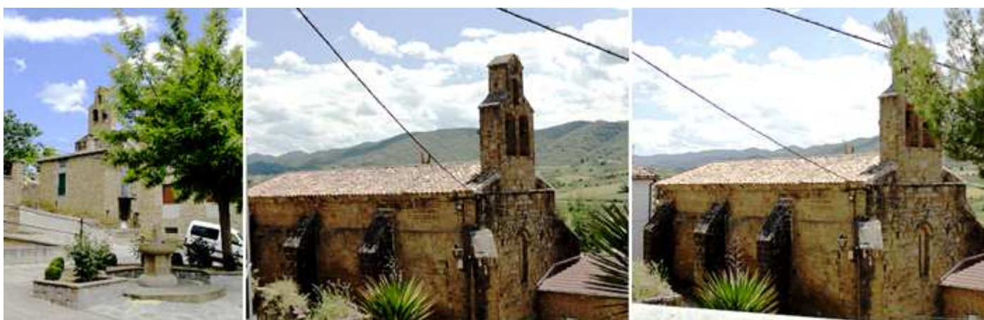
❶ Plaza Ángel Hidalgo Obispo de Jaca, con una fuente. ❷ Lateral izquierdo de la iglesia y sus gruesos contrafuertes. ❸ En el paño del hastial una ventana de medio punto muy estrecha y con guarda lluvias debajo posee una más amplia.
