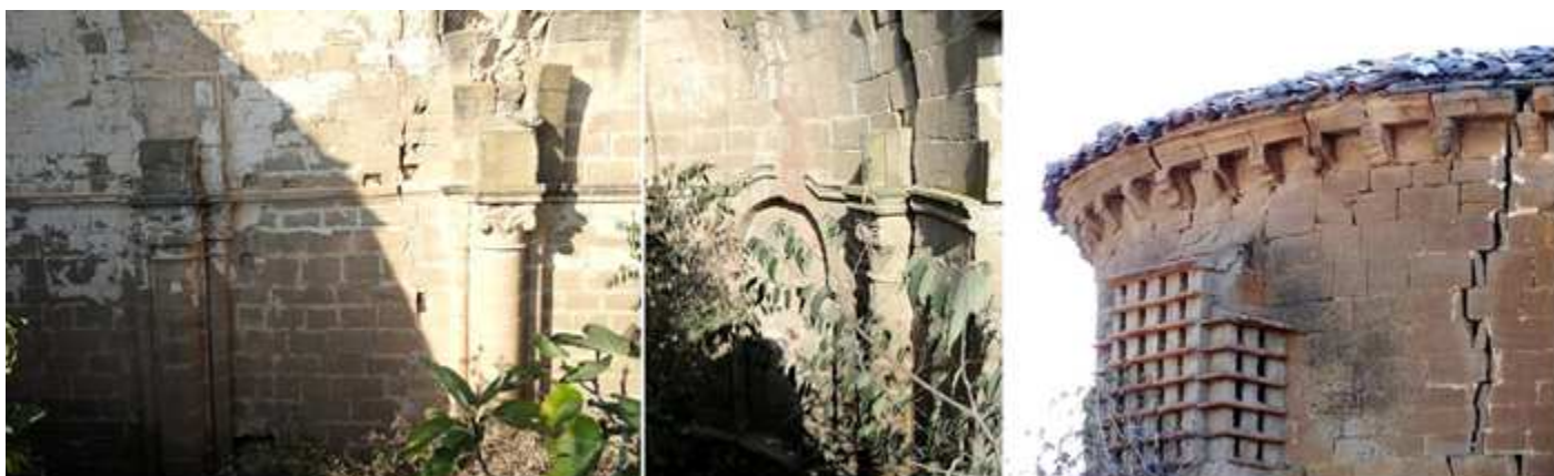
❹ En el muro norte columnas semi redondas adosadas y de sus capiteles arrancaban sus arcos. Todo el templo esta recorrido por una imposta.. ❺ Parte de su cabecera en lo que la maleza permite apreciar de la misma. ❻ La zona norte del ábside convertida en un Palomar, con un alero con atractivos canecillos geométricos y con caras.
