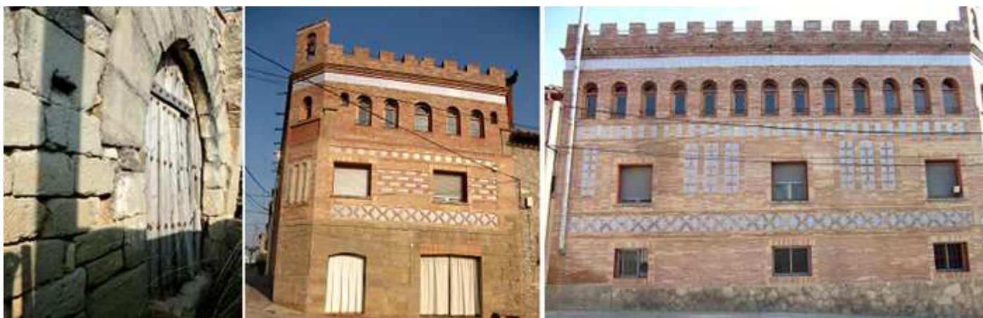
❶ Portada de pedio punto en esta casa en obras. ❷ Casa de la calle xxx, de tres alturas construida en ladrillo. ❸ Además de alguna decoración de rombos, cruces, y almenas poseen el último piso una galería de arquillos de medio punto y su cornisa con almenas, se complementa con variada decoración de azulejos.
