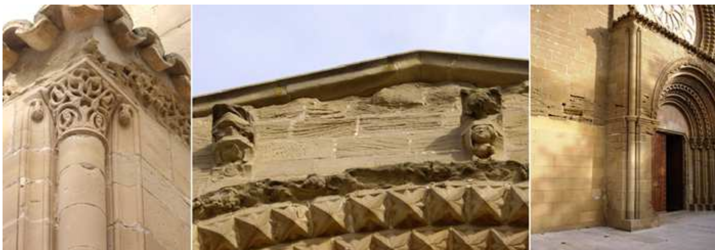
1 Y columna adosada, sobre el cuerpo saliente de la portada, que la protege con un tejazor. 2 Los dos canecillos que conserva bajos su alero moderno. 3 El tímpano es liso, presumiblemente estaría decorado/pintado.
