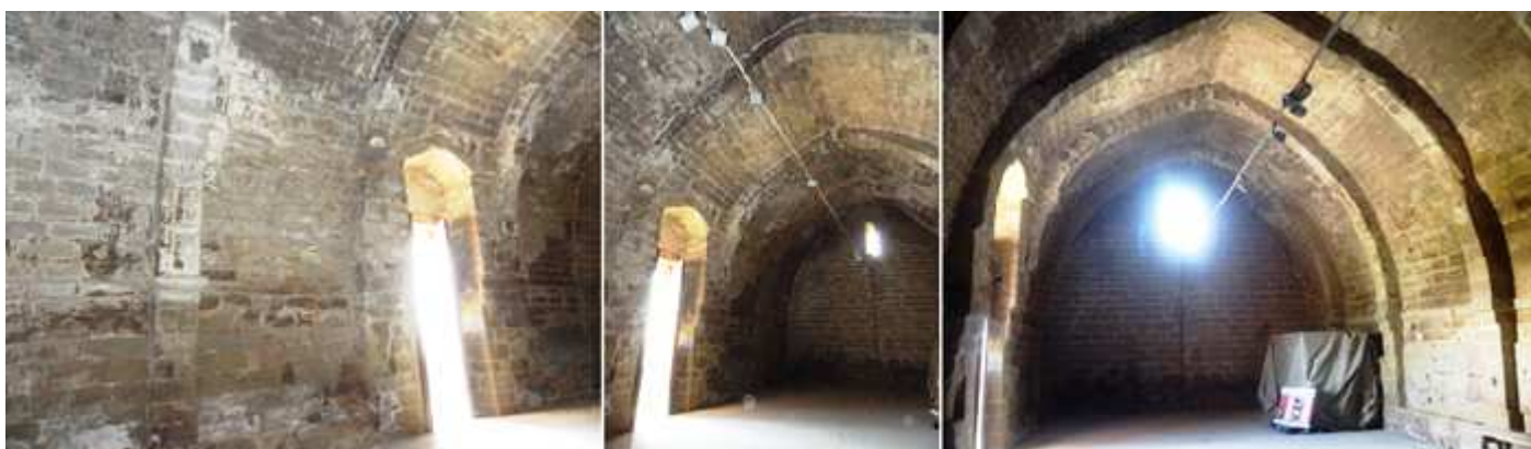
1 Lateral de la Epístola con su puerta. 2 La nave con bóveda de cañón apuntado sostenida con arcos fajones. 3 Vista de la parte inferior del templo.
