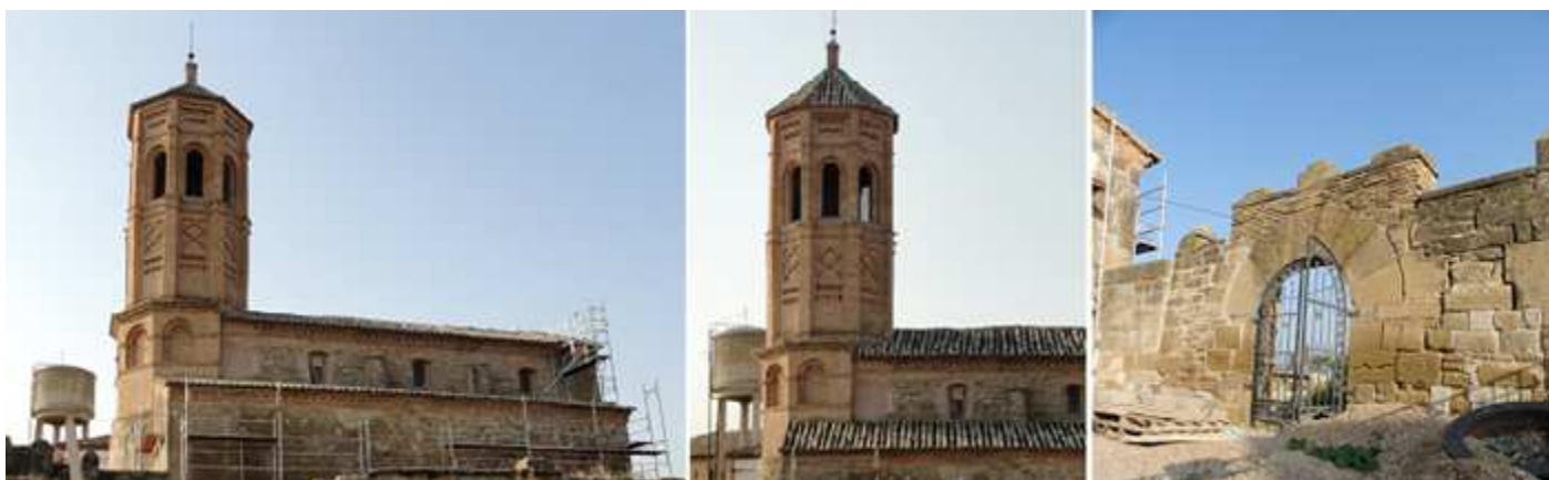
❶ Silueta del templo desde la ermita. ❷ La nave de la Epístola totalmente cerrada y las ventanas de la nave central. ❸ Portón lateral de medio junto a la fachada del templo.
