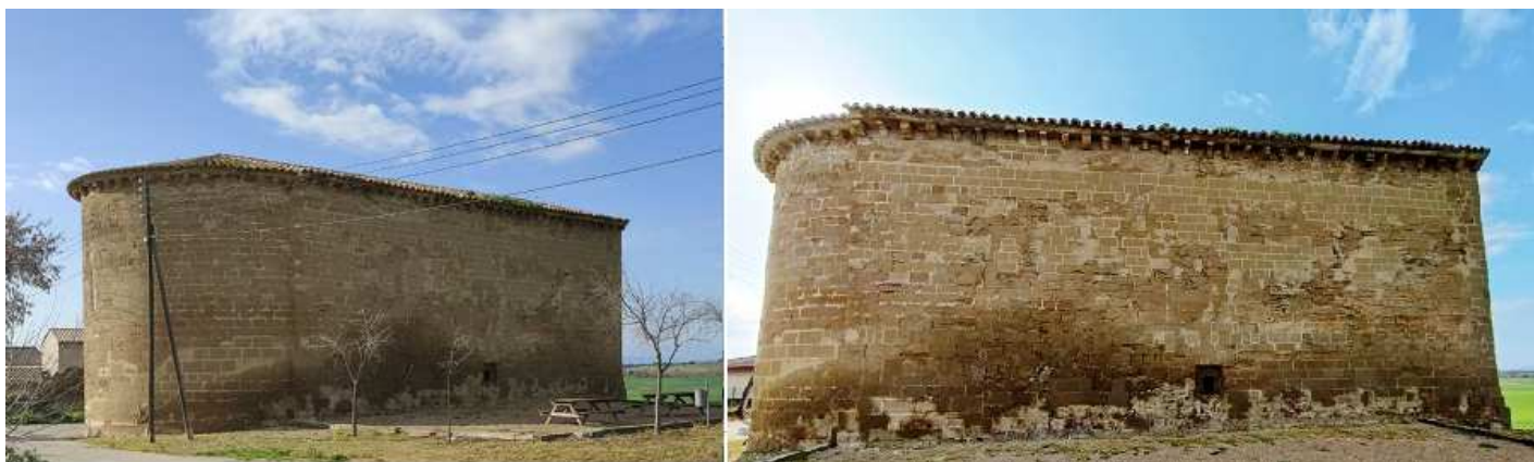
❶ En su parte posterior cuenta con un espacio lúdico. ❷ Fachada lateral sur. En la que dispone de una pequeña apertura adintelada en su parte inferior. Fotos José Joaquín Gallego.
