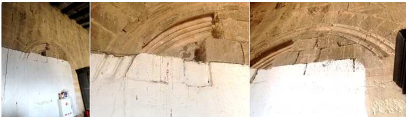
❶ Primitiva portada de acceso con arquivoltas en el tercer tramo de la nave de la Epístola. ❷ Con un arco ligeramente apuntado que dispone de dos arquivoltas. ❸ Toda esta zona es un almacén del templo.
