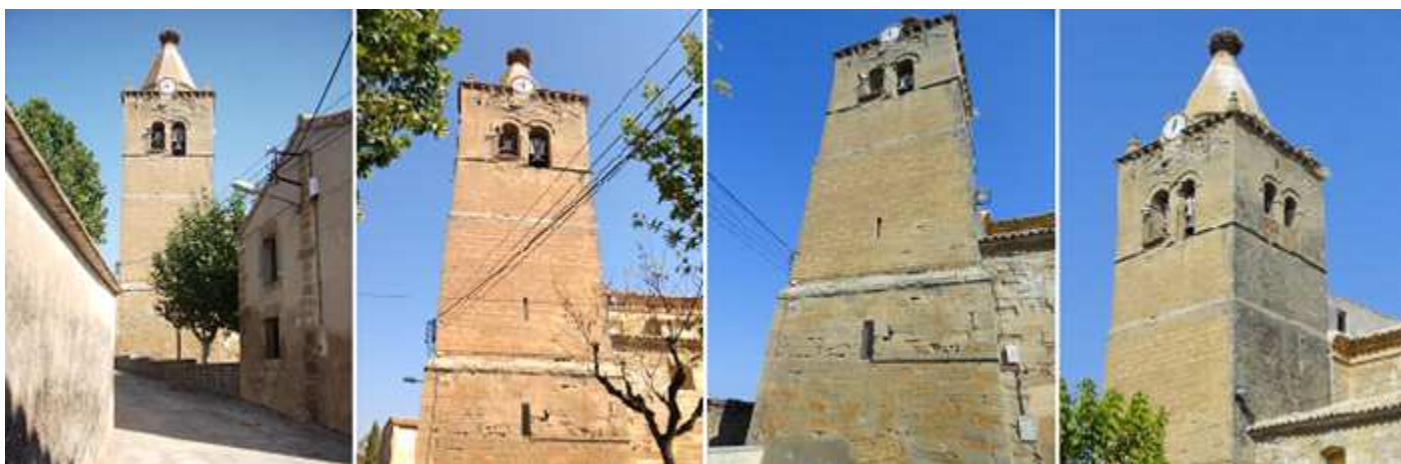
❶ Detalle de la torre desde el lado exterior de la Epístola ❷ Los tres cuerpos se distinguen por la reducción de la planta en cada uno en altura. ❸ Se cubre la torre a cuatro aguas con un chapitel de piedra octogonal de construcción posterior sobre un tambor. ❹ En algunas de sus caras se le colocó un reloj.
