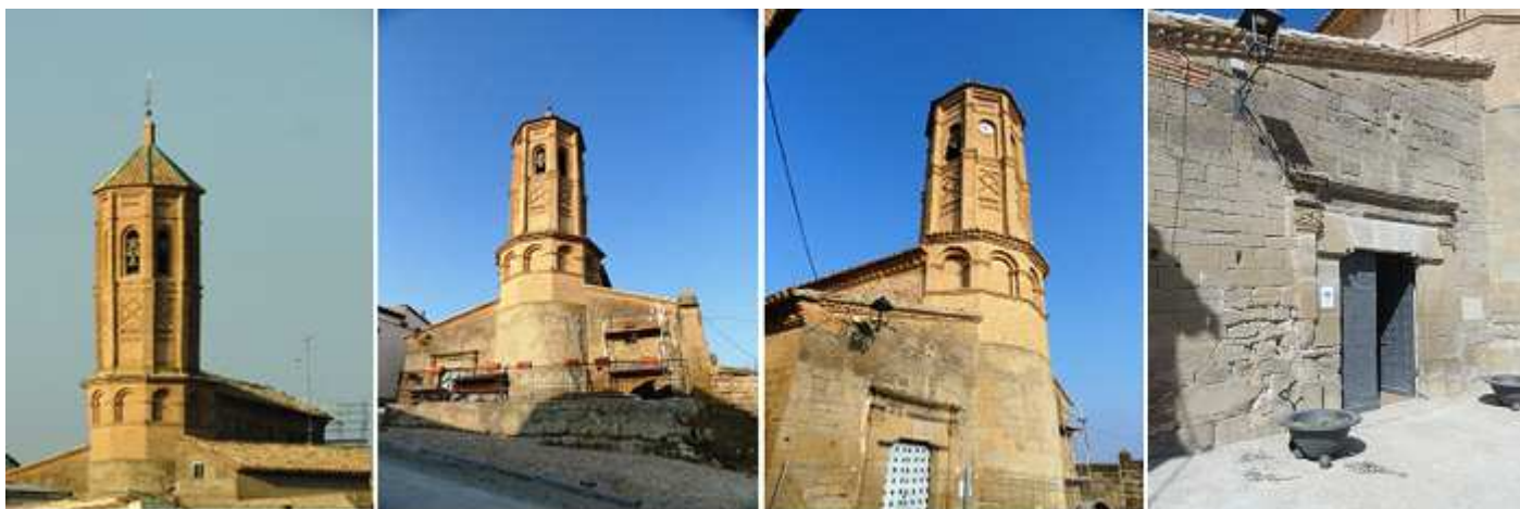
1 Su torre se alza considerablemente sobre los tejados de las naves. 2 Parte izquierda de su actual fachada. 3 En uno de los vanos de medio punto del campanario está instalado el reloj. 4 En la que se abre la puerta del templo.
