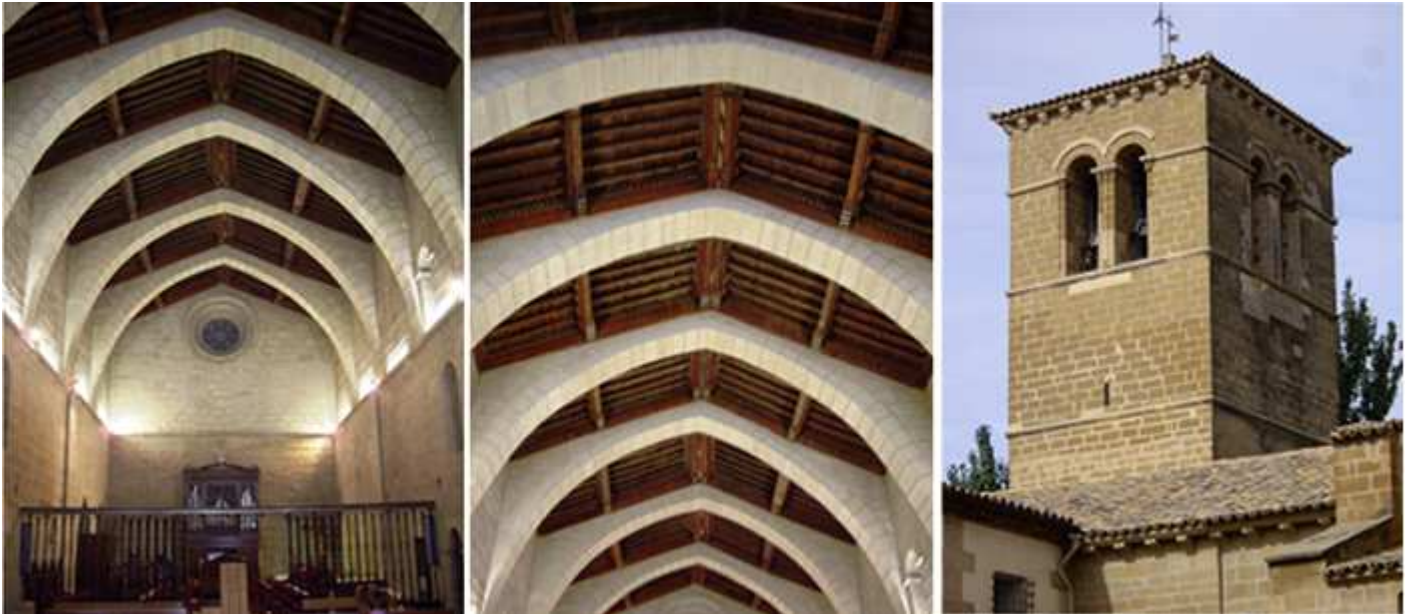
❶ El templo es de nave única, y lo más destacable es su artesanado policromado. ❷ Con arcos fajones apuntados sostienen su cubierta a dos aguas. ❸ Torre del primitivo templo románico.
