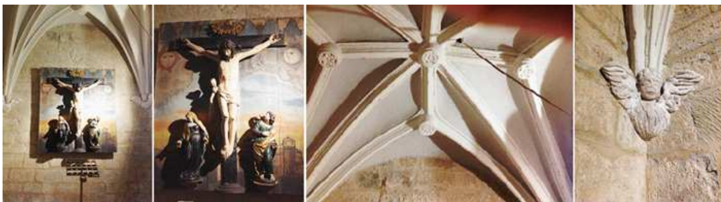
❶ Capilla en el lateral derecho con un calvario. ❷ Santo Cristo crucificado junto a su madre María y San Juan. ❸ Bóveda de crucería de esta capilla. ❹ Ménsula de arranque de los nervios de la bóveda.
