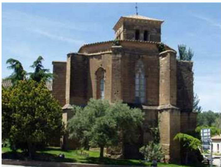
1 Ábside de la iglesia de San Miguel en estilo gótico.
