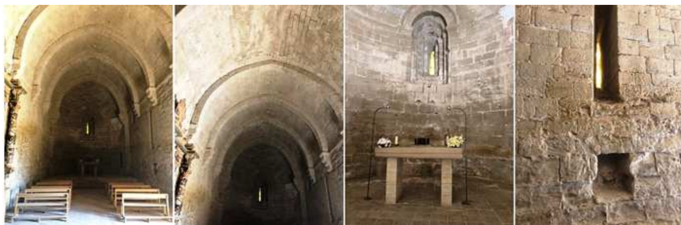
❶ Detalle de la nave. ❷ Con bóveda de cañón apuntado y arcos fajones que arrancan de ménsulas. Y una imposta recorre la nave del lado de la Epístola y la cabecera. ❸ Cabecera con una ventana con degradación escalonada. ❹ Una de las ventanas de aspillera. Fotos: José L. Martínez.
