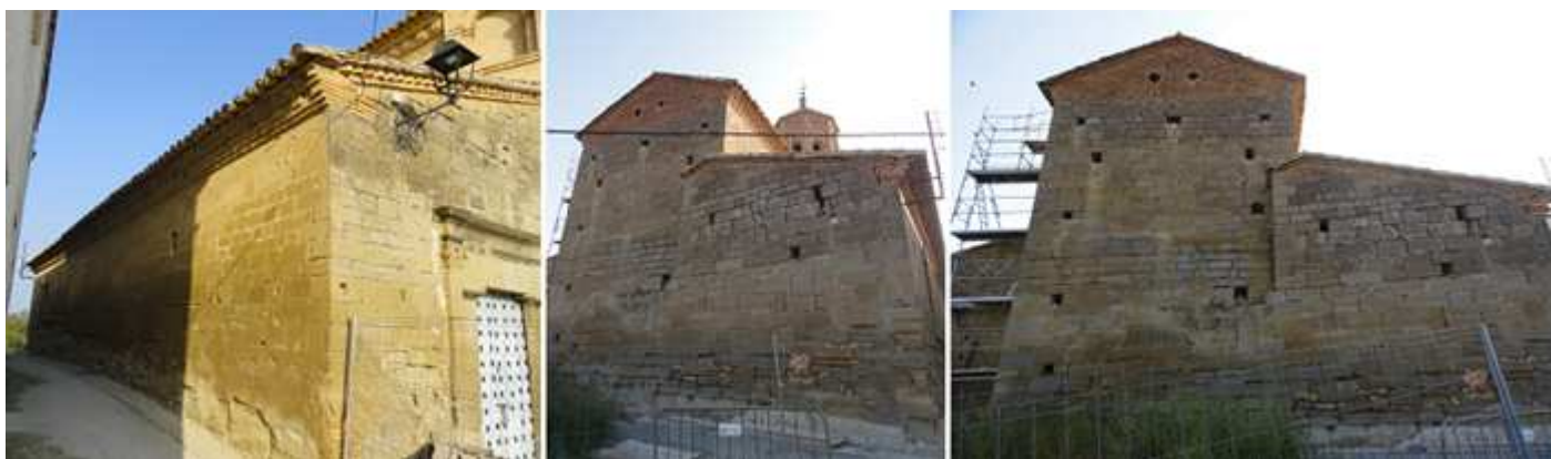
❶ Exterior del lado izquierdo del templo junto a la puerta. ❷ Parte posterior con su cabecera y a la derecha el muro de la sacristía. ❸ Esta parte da a un terraplén.
