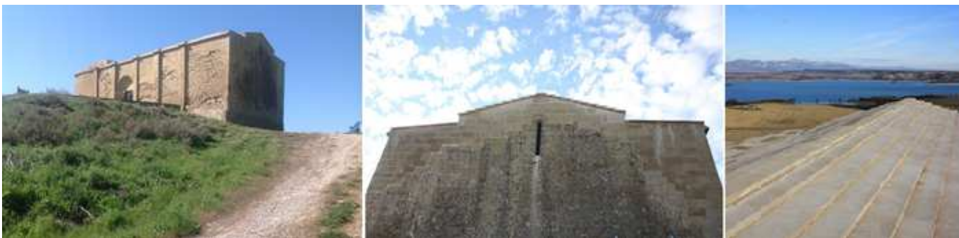
❶ Fachada sur, el edificio está construido con piedra sillar caliza ❷ Ábside con una ventana de aspillera. Y una cubierta a dos aguas. ❸ La nueva cubierta de losas de piedra. Fotos http://www.alazets.com
