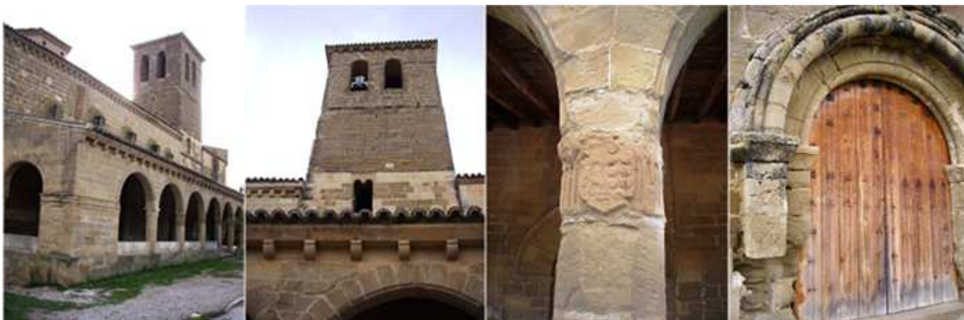
❶ Detalle del pórtico y la torre ❷ En este lado apreciamos una ventana germinada que ha perdido su mainel. ❸ Escudo en una columna del porche. ❹ Y una puerta posterior de medio punto con dos arquivoltas sobre una imposta corrida.
