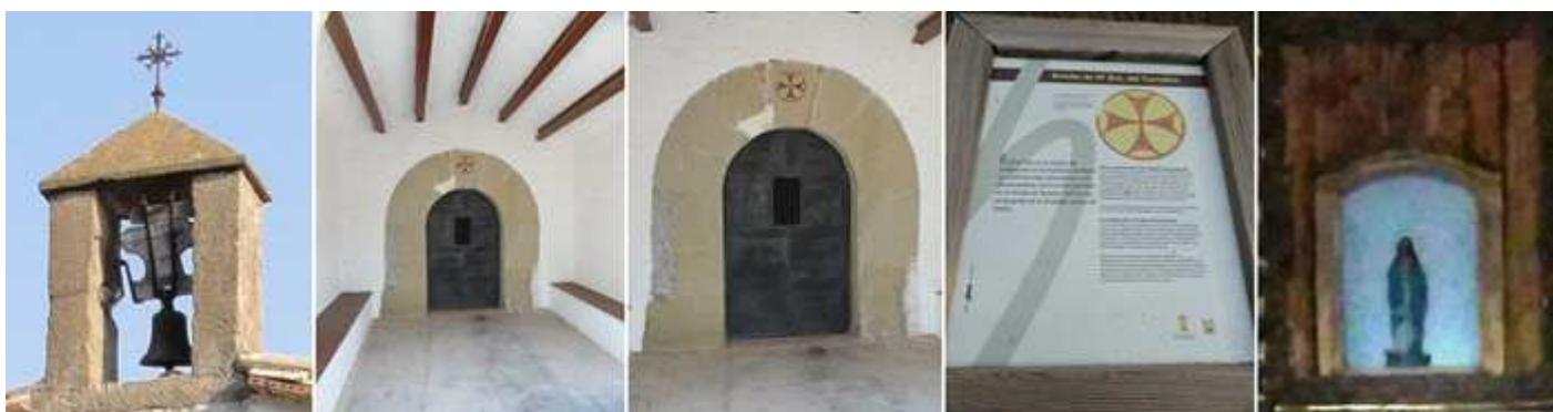
❶ Espadaña de un solo vano. ❷ Interior del pórtico con sendos bancos laterales para resguardar de las inclemencias del tiempo. ❸ Su puerta con dovelas lisas y sobre su clave la Cruz patada de la Orden de los Hermanos Hospitalarios. ❹ Información sobre la Orden de San Juan de Jerusalén. ❺ Imagen de la Virgen Inmaculada dentro de un pequeño retablo barroco.
