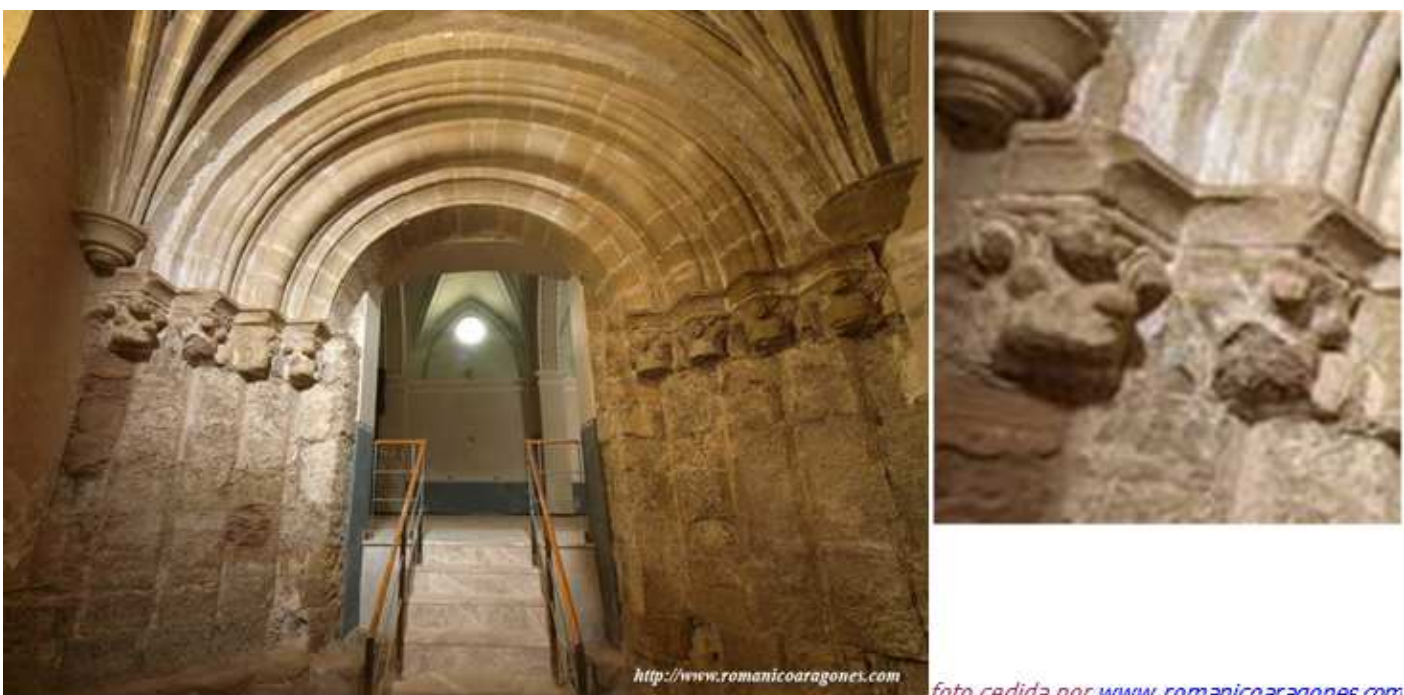
1 Portada con cuatro archivolts baquetonadas sobre capiteles con motivos vegetales. Su portada original, se conserva gracias a que la torre adosada con posterioridad se construyo delante de ella, se compone de cuatro archivolts en degradación. Su interior no se pudo visitar, en espera de tener el acceso pues esta iglesia está cerrada al culto, incluye la portada que hay debajo de la torre, cedida, para su apreciación. La talla policromada de rasgos góticos del S. XII de la Virgen con el Niño, está en Museo Provincial de esta ciudad.
