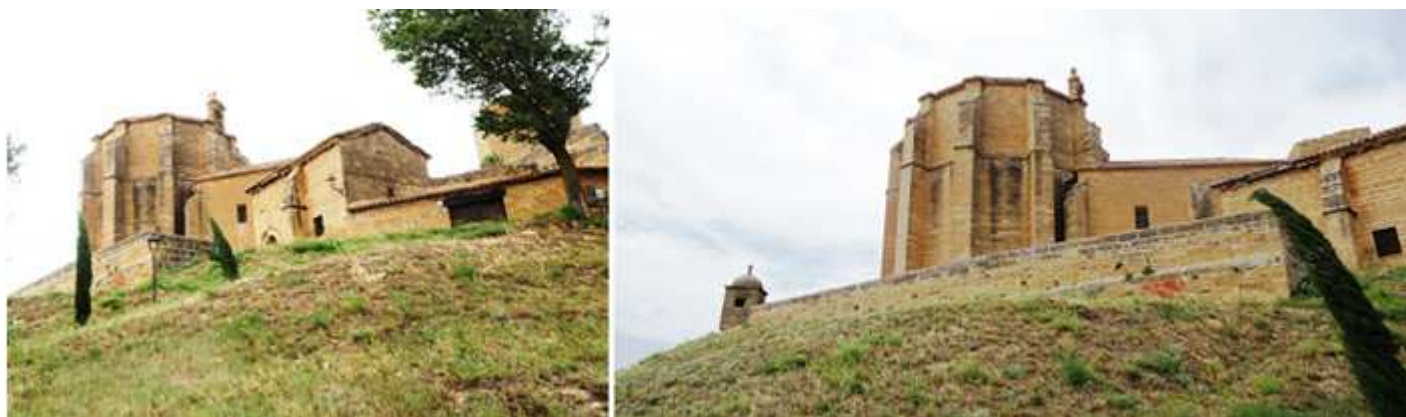
❶ Cabecera de Santa María, junto a la ermita de San Juan. ❷ La terraza de la iglesia está sostenida por un muro que la protege.
