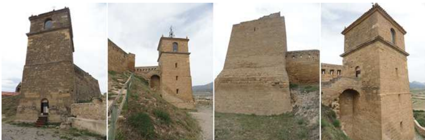
❶ Una de la caras de la torre del Reloj, abierta con una puerta de medio punto. ❷ La torre también se mantiene comunicada con el castillo con una pasarela. ❸ Unos lienzos exteriores del castillo de su Torre Mayor. ❹ Y la pasarela que accede a esta torre del Reloj planta cuadrada. En la Torre del Reloj se encuentra un Museo.
