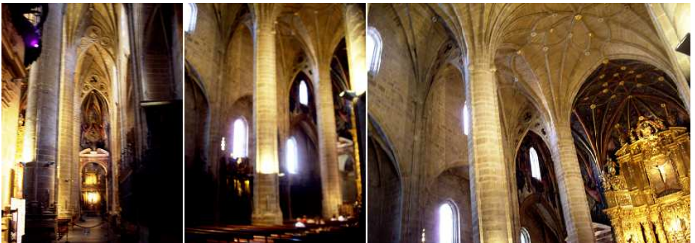
1 Nave de la Epístola. Al fondo en la cabecera de esta nave la capilla y sepulcro de Santo Cristo con un crucifijo del S. XV. 2 Lateral de la nave del Evangelio. 3 Detalle de la bóveda de crucería y de la capilla mayor, que esta cúpula ultima está adornada por unos frescos del S. XVIII.
