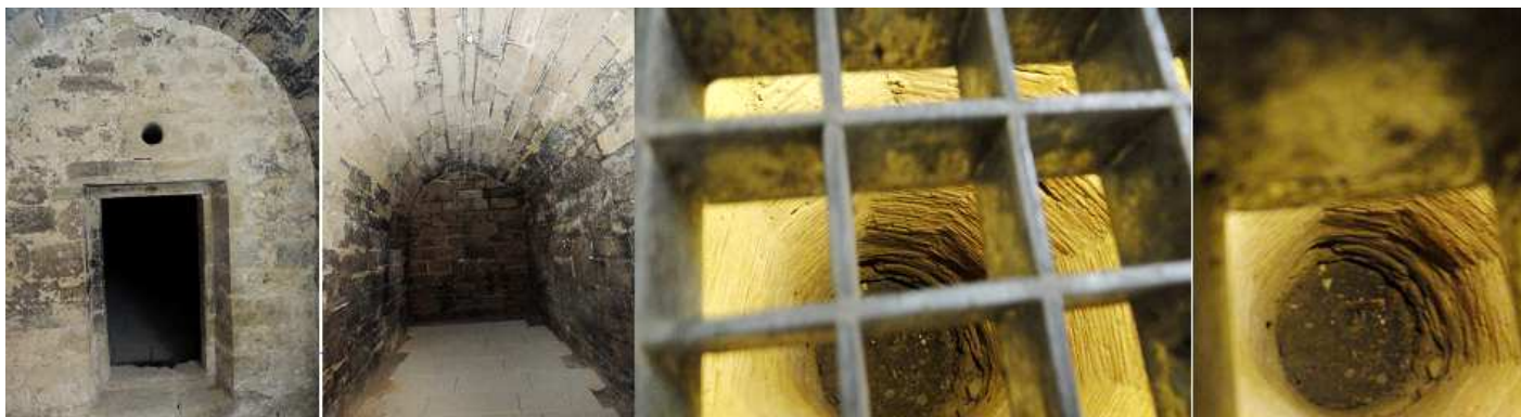
❶ Puerta de acceso. ❷ Sala con bóveda de cañón. ❸ Espacio con la boca del pozo. ❹ Con cierta profundidad.
