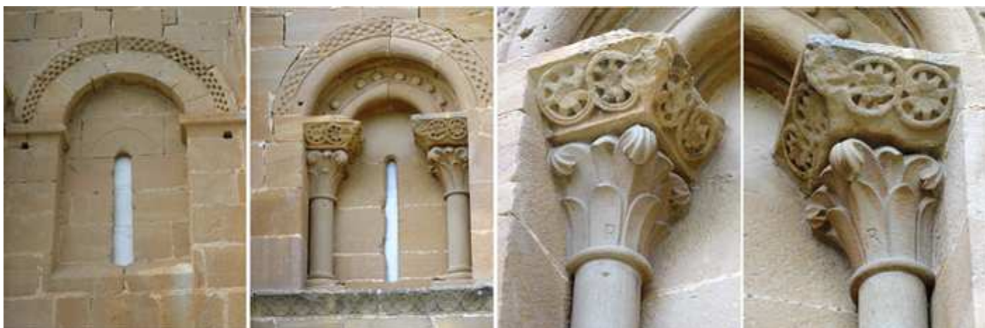
❶ Ventana de medio punto con el guarda lluvias taqueado. En el lateral de la portada. ❷ Ventana del presbiterio con una arquivolta decorada con taqueado en su parte exterior y baquetonada en su interior donde aloja otra ventana con una arquivolta con decoración a bolas y baquetonada sobre capiteles y columnas en el presbiterio. ❸ La arquivolta descansa sobre una con roleos con flores con un capitel con hojas (con la marca ®- reconstruido) en el lado izquierdo. ❹ Y el del lado derecho de las mismas características.
