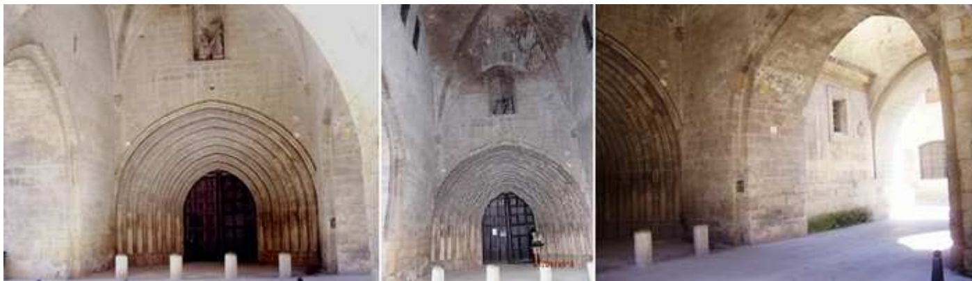
❶ Portada abocinada en la calle El Cristo. ❷ La portada occidental es de transición románico-gótica, de finales del siglo XIII, compuesta por unas arquivoltas, subrayadas por unas columnas que descienden hasta el suelo. ❸ Pórtico compuesto por 3 arcos.
