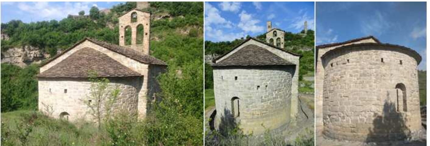
❶ Parte posterior del templo con un ábside algo más bajo que la nave. ❷ Todo el templo está construido con sillarejo irregular. ❸ En la parte central se abre la segunda ventana que posee el templo.
