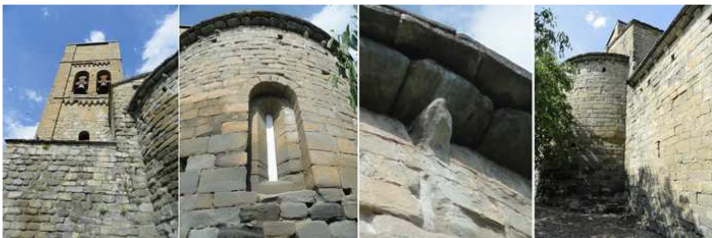
❶ La torre desde este lado de la cabecera. ❷ Con un sencillo ábside con una ventana de aspillera con derrame dentro de un arco de medio punto de arista viva. ❸ Bajo su alero con canchillos, que todos están tan erosionados que no se aprecia su estilo. ❹ Lateral a la derecha con una capilla o Sacristía.????
