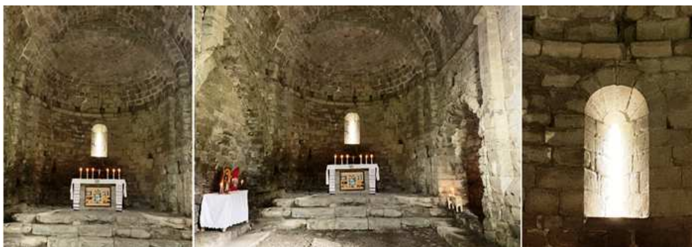
❶ Cabecera elevada con tres escalones. ❷ A los lados se aprecian los arcos apuntados de sus respectivas capillas, que actualmente están cegados. ❸ Su ventana de medio punto con derrame interior. Fotos: Javier Torres.
