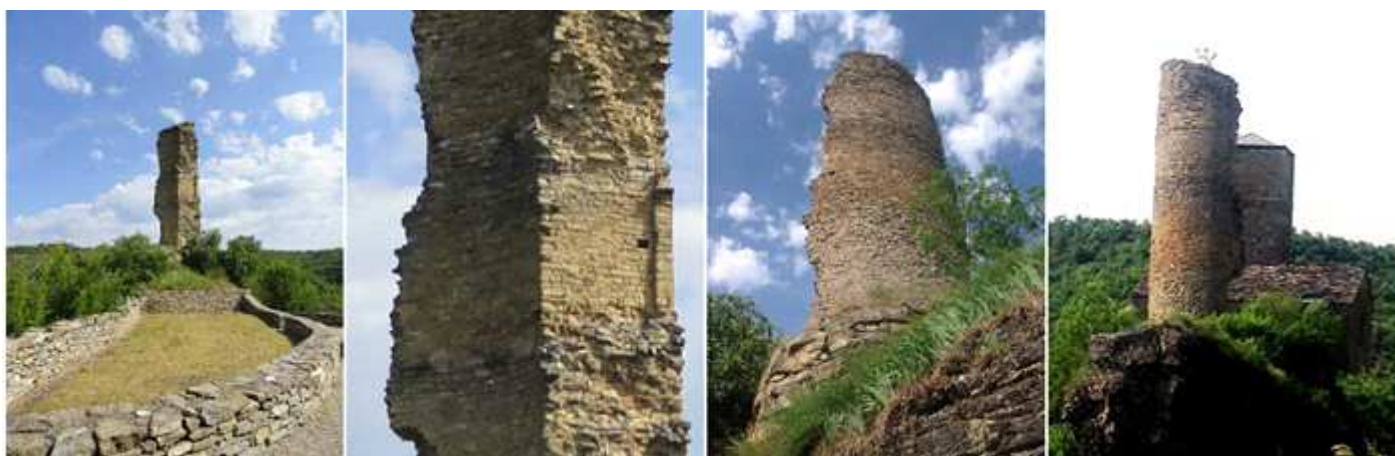
❶ Debió tener un diámetro de 9m y cuatro pisos en su interior. ❷ De ella se conserva esta mínima parte. Que recientemente la han consolidado. ❸ Detalle de su exterior que alcanzaba los 12m de altura. ❹ Se eleva sobre un espolón de roca y desde ella se domina una gran distancia.
