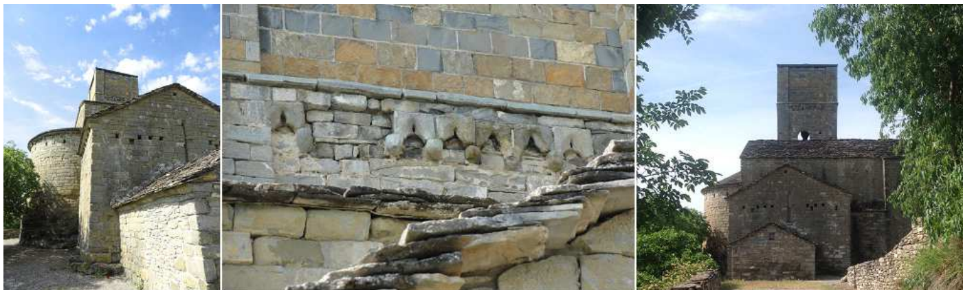
❶ Esta capilla o sacristía, con una alta ventana de aspillera. ❷ Detalle de la decoración que posee la torre, bajo su imposta corrida en el cuerpo de las campanas. ❸ La iglesia desde el camino junto a la torre de la Mora.
