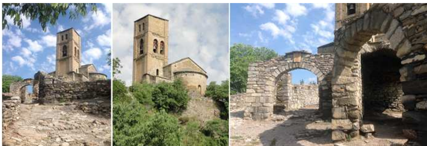
❶ Antes de llegar a la iglesia se encuentra esta cerca con un arco, y a la derecha se encontraba la abadía. ❷ La imponente torre de Santa María. ❸ Arco de entrada y algunas dependencias de la abadía.
