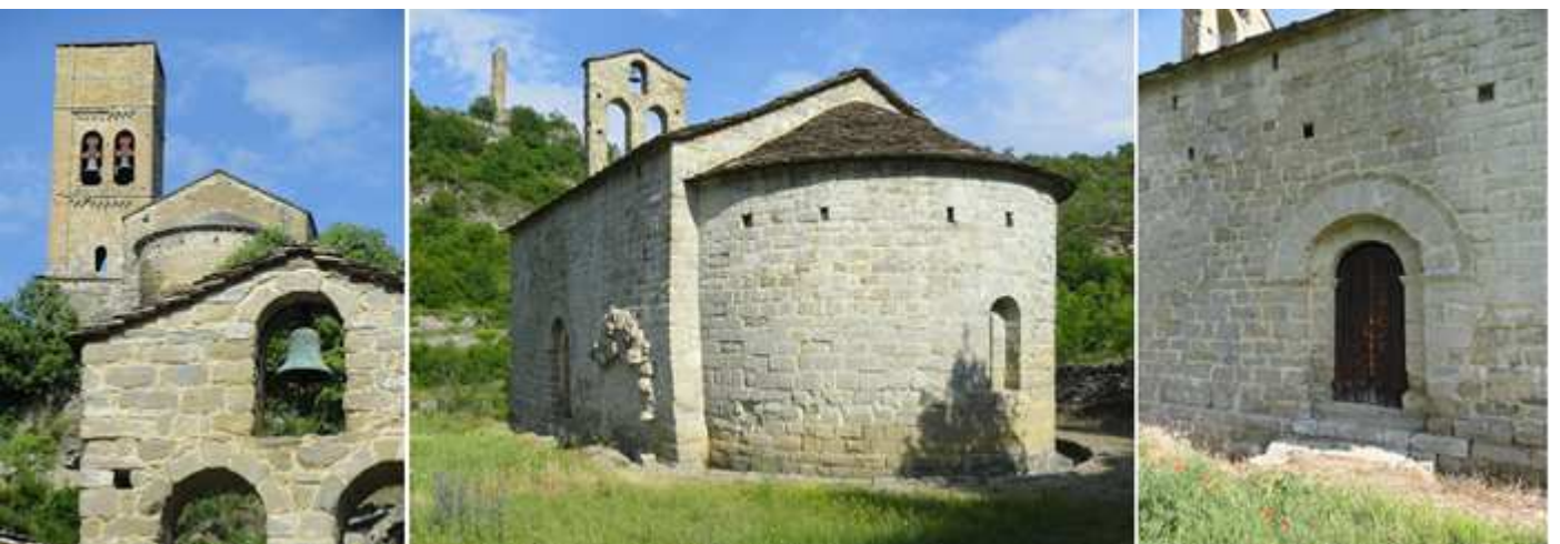
❶ Su espadaña con tres vanos (dos vacíos y una campana) y al fondo la torre y ábside de Santa María de Baldos. ❷ Perspectiva del lado sur y el ábside esta sobre un zócalo. ❸ La puerta de este lado con arquivoltas lisas que descansan en impostas y se accede a la misma por unos peldaños.
