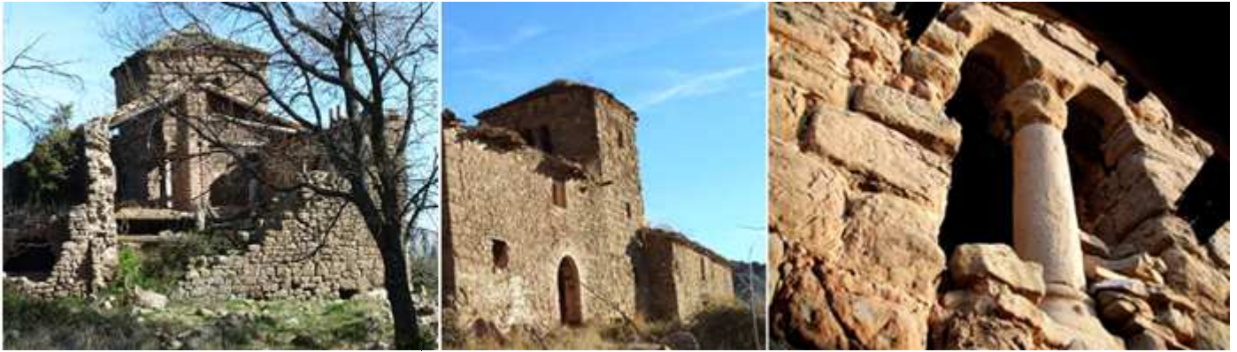
❶ Construcción ante la ermita y en su lateral norte. ❷ La puerta de la casa, la torre de la ermita y el lateral epistolar con su entrada con un puerta moderna ❸ Uno de sus ventanales geminados de la torre que fueron cegados, con sus capiteles y basas muy erosionados. Fotos Eduardo Pardo Royo.
