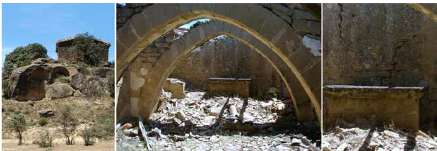
❶ Cabecero recto de la ermita sobre la roca donde está la necrópolis. ❷ En su interior, está totalmente hundido, en el que solo se conservan dos arcos fajones apuntados que sostenían su techumbre. ❸ Ara del altar. Todo está construido con cantería.
