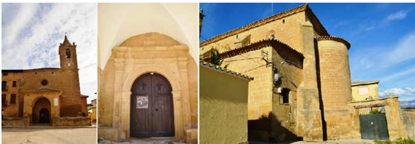
❶ Portada con un pórtico abierto que su puerta de medio punto y la torre adosada a la derecha. ❷ El acceso de su puerta con columnas adosadas a sus lados y con un entablamento situada en el lado de la Epístola. ❸ Detalle exterior de las capillas laterales y su cabecera con un ábside semicircular y contrafuertes en sus ángulos. En este lado se encuentra su sacristía. Fotos: Silvia Arilla / Archivo Fotográfico Hoya de Huesca (SIPCA – www.sipca.es )
