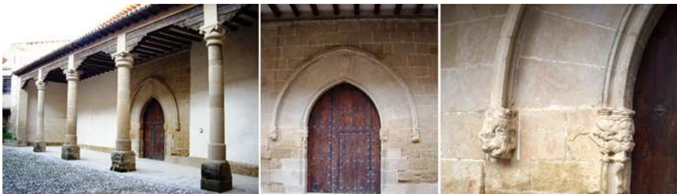
❶ Bajo este pórtico abierto esta la puerta gótica de acceso al primitivo palacio. ❷ Puerta de arco apuntado con dovelas lisas y un su interior una fina arquivolta sobre un capitel corrido que tiene un animal mitológico alado que parece llevar algo a su boca. ❸ Detalle de la imposta y ménsula de características similares donde descansa el guardapolvo de esta puerta.
