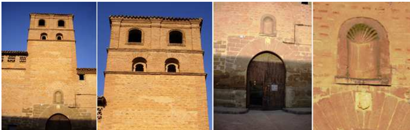
❶ Fachada del monasterio con su torre. ❷ La parte superior separada por unas impostas corridas dos cuerpos con ventanas de medio punto. ❸ Con un gran portadón de medio punto. ❹ En su clave central ostenta el escudo y una hornacina avenerada vacía.
