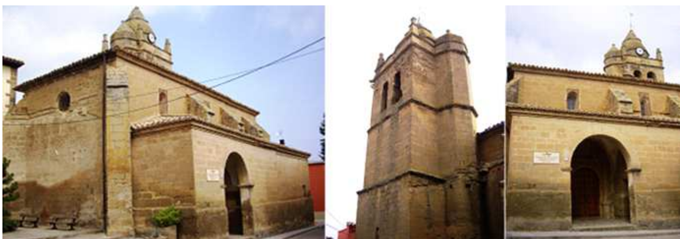
❶ Fachada de la Iglesia de San Clemente de Ibieca. Con su pórtico, dos capillas y la sacristía. ❷ Su torre de planta cuadrada con tres cuerpos que esta separados por impostas rematada con un chapitel piramidal, en un lado dispone de su escalera con una estructura hexagonal en el lado oeste. ❸ Pórtico que cobija la puerta de entrada con arco de medio punto.
