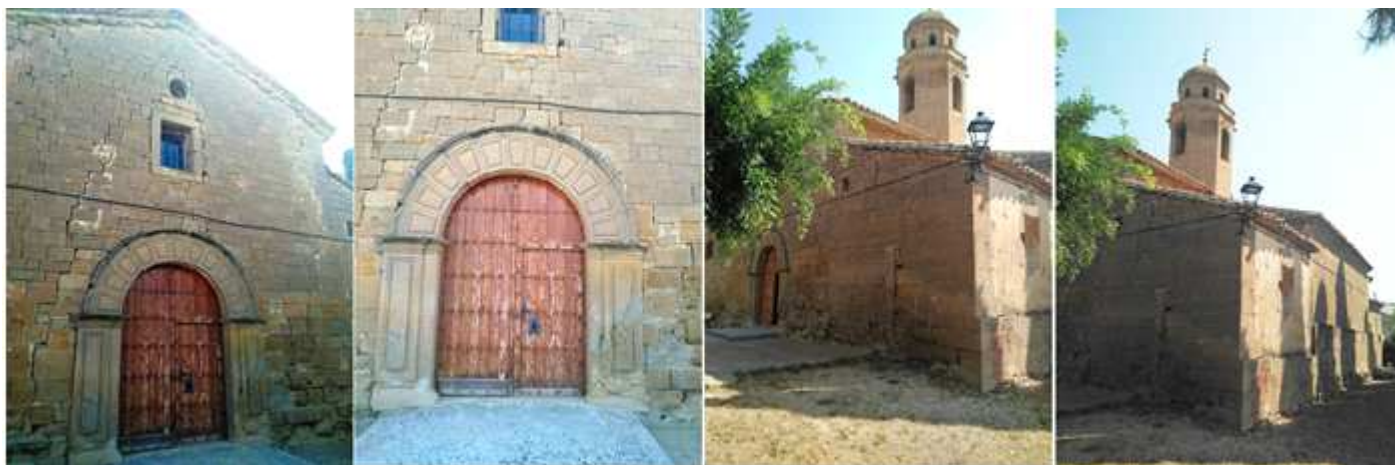
❶ Fachada con una puerta de medio punto y sobre la misma una ventana adintelada y un pequeño óculo encima. ❷ Sus dovelas y las jambas con relieves y cubierta por un guardapolvo que descansa en una imposta. ❸ El lateral epistolar. ❹ Fruto de la ampliación de sus naves laterales. Fotos: Parroquia de Nuestra Srª de los Ángeles.
