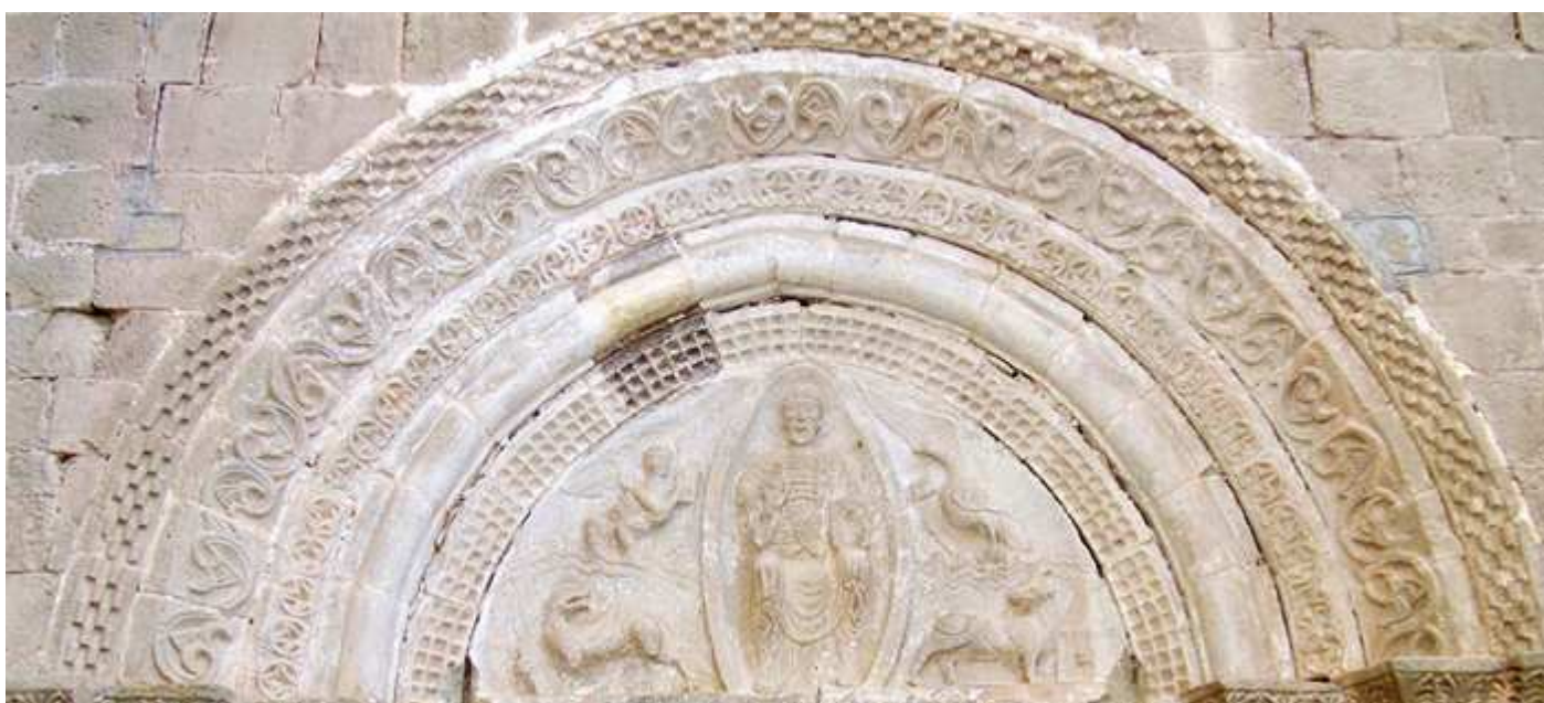
❶ Arco apuntado y enmarcado con triple arquivolta y adornado con un relieve del Pantocrátor, rodeado por tetramorfos.
