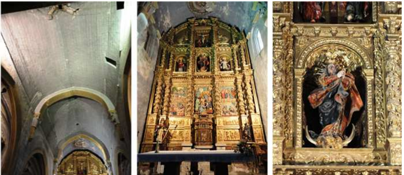
❺ Detalle de la cubierta y los arcos fajones. ❻ Retablo del altar mayor. Ⓣ Y la Purísima en la hornacina del segundo piso central
