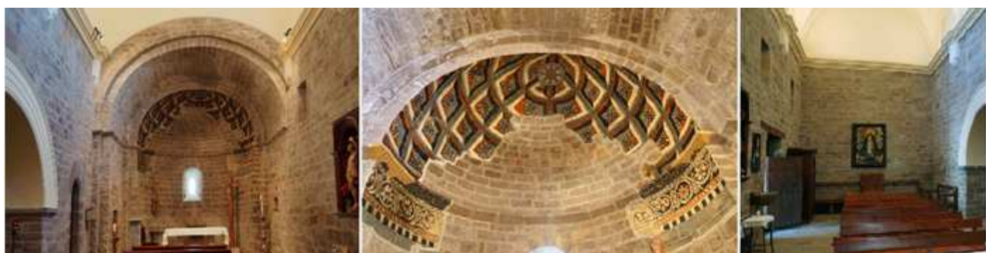
❶ Cabecera y presbiterio ambos recorridos por una imposta corrida, y con una ventana con derrame. ❷ Bóveda de la cabecera con los restos de pinturas imitando casetones. ❸ Parte inferior del templo. Fotos: Marta Puyol Ibor / Archivo Fotográfico Hoya de Huesca (SIPCA – www.sipca.es )
