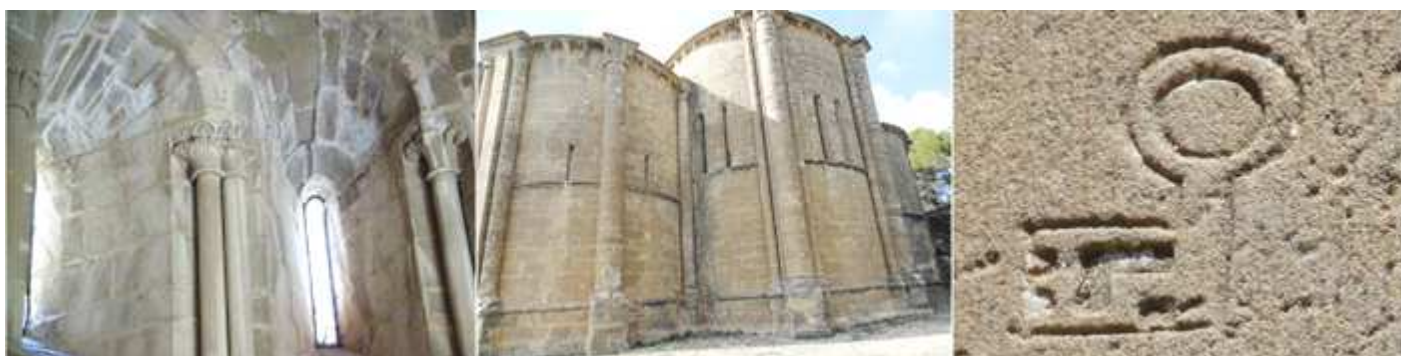
❶ Ventanales de los Absidiolos de derrame interior y con columnillas en su exterior. ❷ Vista exterior de los ábside, ❸ Primer plano de una de las innumerables marcas de los canteros con las que conto para su construcción.
