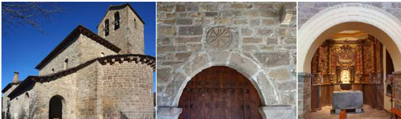
❶ Perspectiva con el porche, el templo y la torre. ❷ Portada de medio punto con sus dovelas biseladas al interior y sobre su clave cuenta con un crismón trinitario de ocho brazos patados del tipo oscense con la P abierta en el palo superior y la S inversa en el inferior, en los brazos superiores A a Alfa y \Omega \omega Omega pinjantes y su aro con decoración perlada en su interior. ❸ Capilla norte que alberga la pila bautismal de taza cuadrada. Fotos: Marta Puyol Ibor / Archivo Fotográfico Hoya de Huesca (SIPCA – www.sipca.es )
