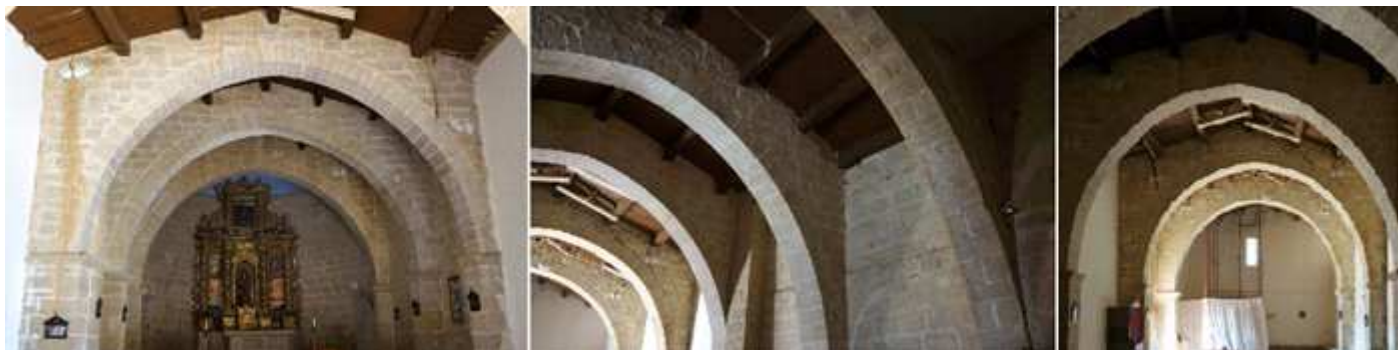
❶ Arcos sobre columnas rectas con unas impostas. ❷ Con un artesonado de madera cubierto de teja a dos aguas. ❸ La parte inferior del templo. Fotos: Marta Puyol Ibort / Archivo Fotográfico Hoya de Huesca (SIPCA – www.sipca.es )
