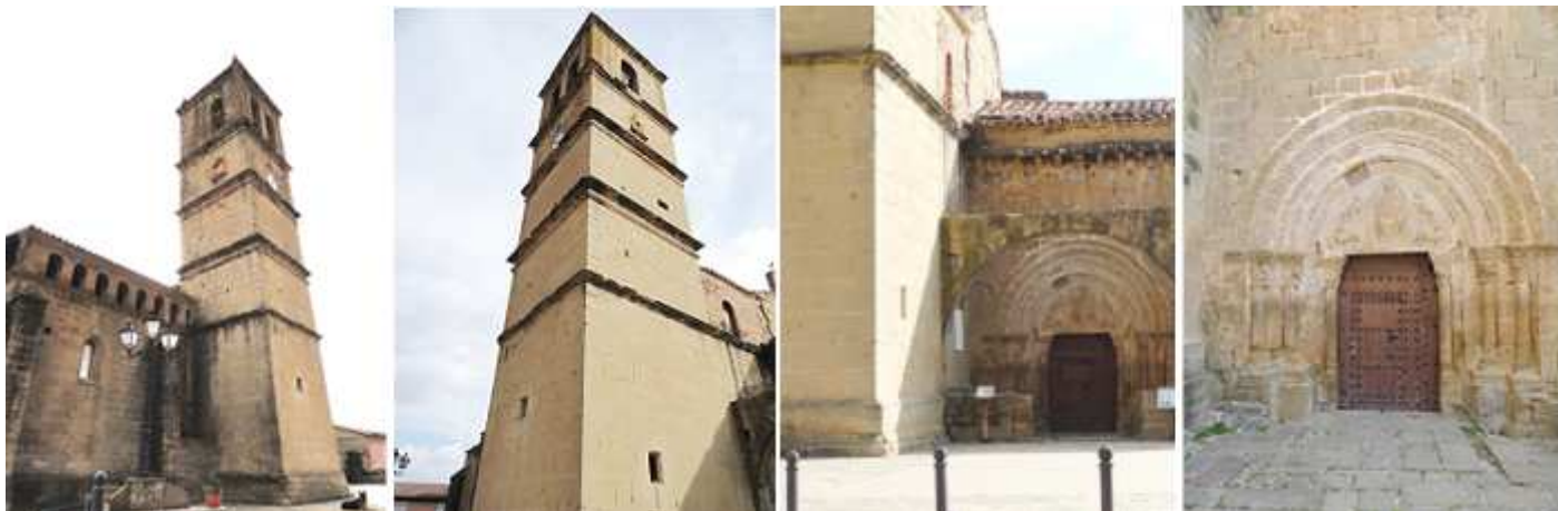
❶ Adosada al muro del Evangelio se halla la gran torre de planta de planta cuadrada. ❷ Y consta de varios cuerpos separados por cornisas, en el cuerpo superior se abren unos vanos de medio punto que albergan las campanas. ❸ Entrada a la iglesia primitiva. ❹ Portada románica de finales del S. XI y principios del XII.
