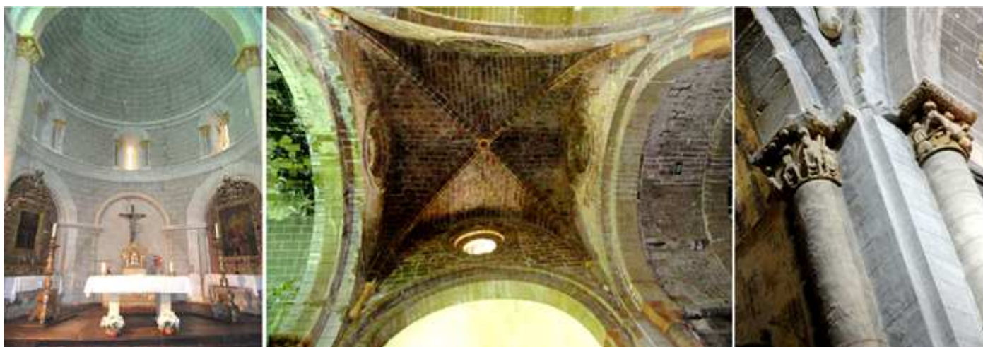
❶ Ábside central con el altar Mayor con ventanas de medio punto doveladas y con columnas y capiteles labrados. ❷ Cúpula del crucero. ❸ Detalle de las columnas y capiteles en la zona del presbiterio.
