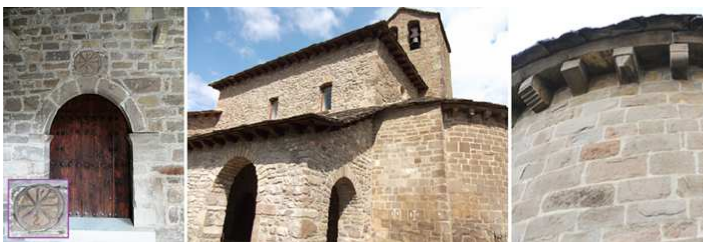
❶ Puerta de medio punto con sus dovelas lisas, y crismón en relieve sobre la clave. ❷ Pórtico y muro de la Epístola. Este atrio es del S. XVII. ❸ Canecillos geométricos del ábside.
