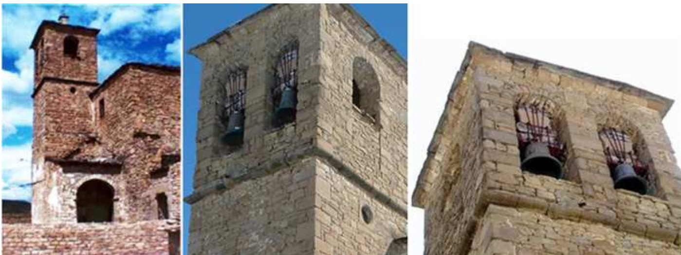
❶ Acceso bajo el porche, junto a la torre campanario adosado ❷ Su torre de planta cuadra con dos cuerpos separados por una imposta, se encuentra construida con sillarejo irregular igual que la iglesia. ❸ Detalle de la parte central de los vanos con el crismón
