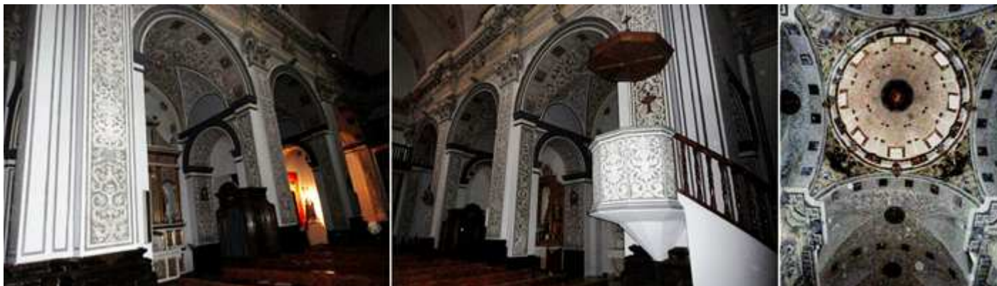
❶ Lateral con la nave del Evangelio. ❷ Esta nave vista desde la cabecera con su púlpito con tornavoz. ❸ Cúpula sobre pechinas abierta con ocho ventanas.
