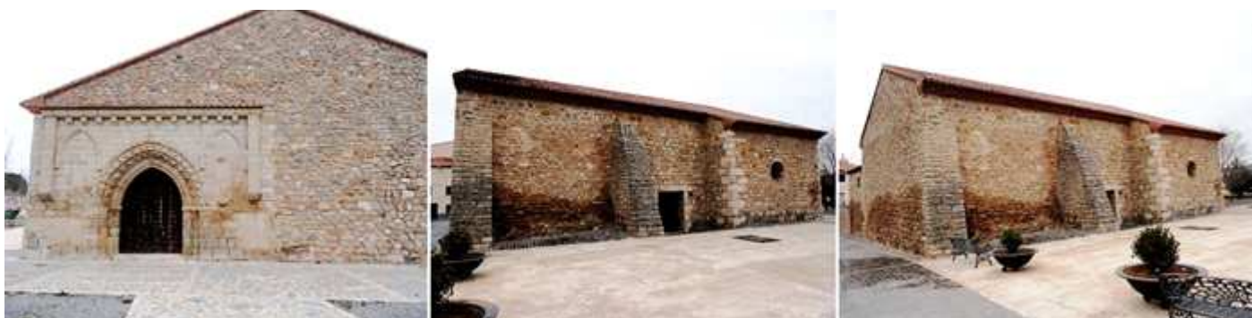
❶ Imagen frontal de la fachada tras la restauración. ❷ A sus lados grueso contrafuertes y abierto el lateral del Evangelio con una puerta adintelada. ❸ El testero de la iglesia es recto y con una cubierta a dos aguas.
