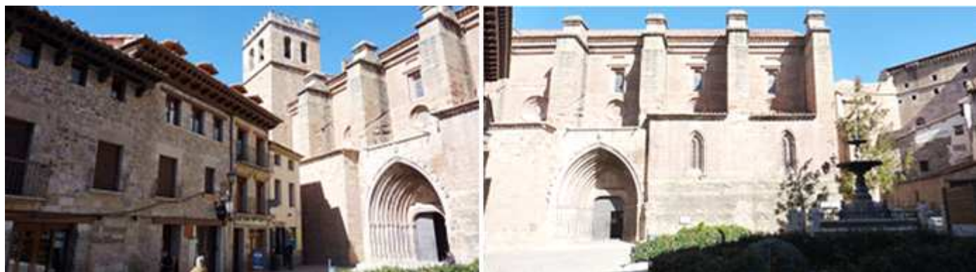
1 - 2 Dos imágenes de la plaza de la ex colegiata, y podemos apreciar los grandes contrafuertes del templo.
