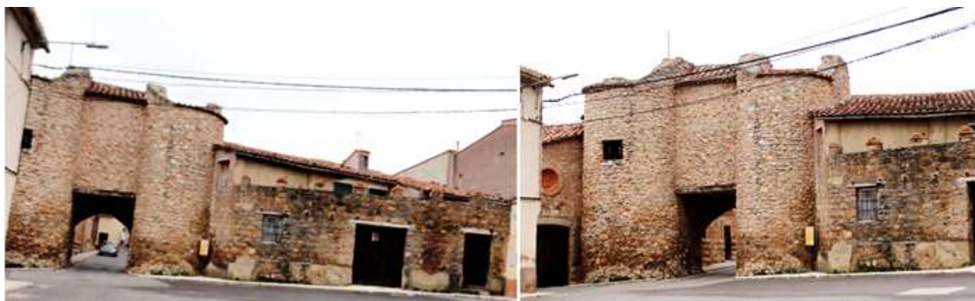
1 La Puerta de Teruel situada en la confluencia de las calles Música Jericó y Monterde. 2 A ambos lados de la puerta las construcciones han surgido quedando algunos muros de la cerca.
