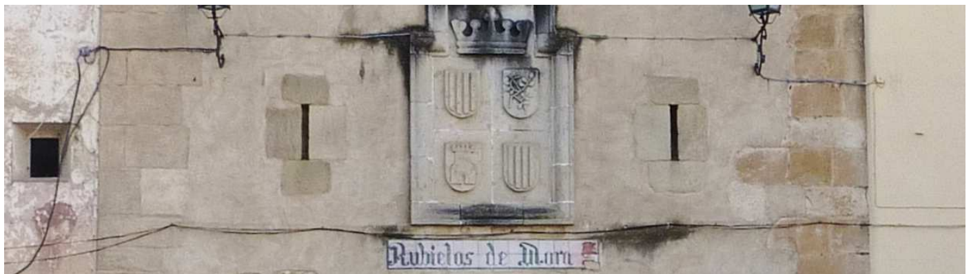
1 Detalle de la parte central del torreón del portal del Carmen con los cuatro escudos y dos aspilleras a sus lados.
