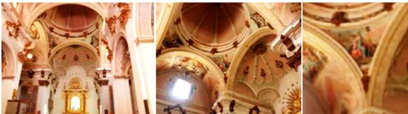
❶ -Parte del crucero con su cúpula y la cabecera de testero recto. ❷ Su cúpula sobre pechinas y sus nervios formando gajos. ❸ Detalle de la decoración del crucero, cúpula y pechinas.
