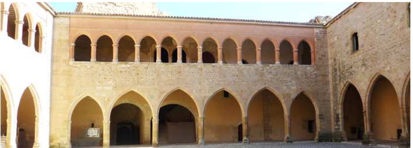
1 Patio interior del castillo, con una galería de arcos apuntados entre los que se encuentran algunos escudos de los Fernández de Heredia.
