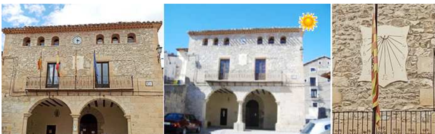
1 Su Ayuntamiento construido con cantería y piedra sillar. 2 De dos plantas con una lonja inferior con dos arcos de medio punto, construido con piedra sillar y cantería, en su fachada posee un reloj de sol. 3 Con números árabigos y horas pintados desde las 6 a la 5 p.m. con gnomon de varilla. Fotos: Ayuntamiento.
