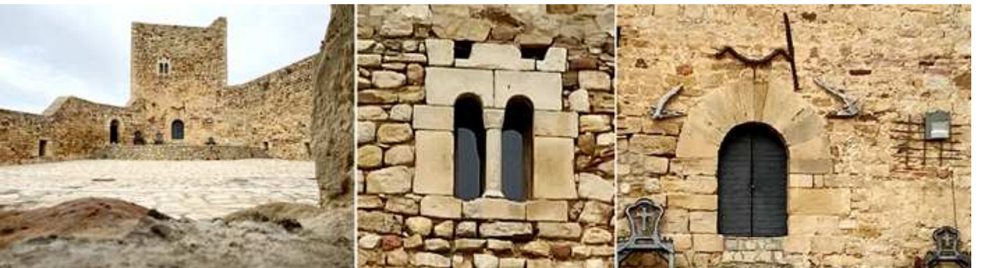
❹ Patio interior con una de las torres al fondo, a la que le falta las almenas. ❺ Un ventana ajimezada de esta torre con su mainel y capitel liso. ❻ Detalle de la puerta de acceso a esta torre.
