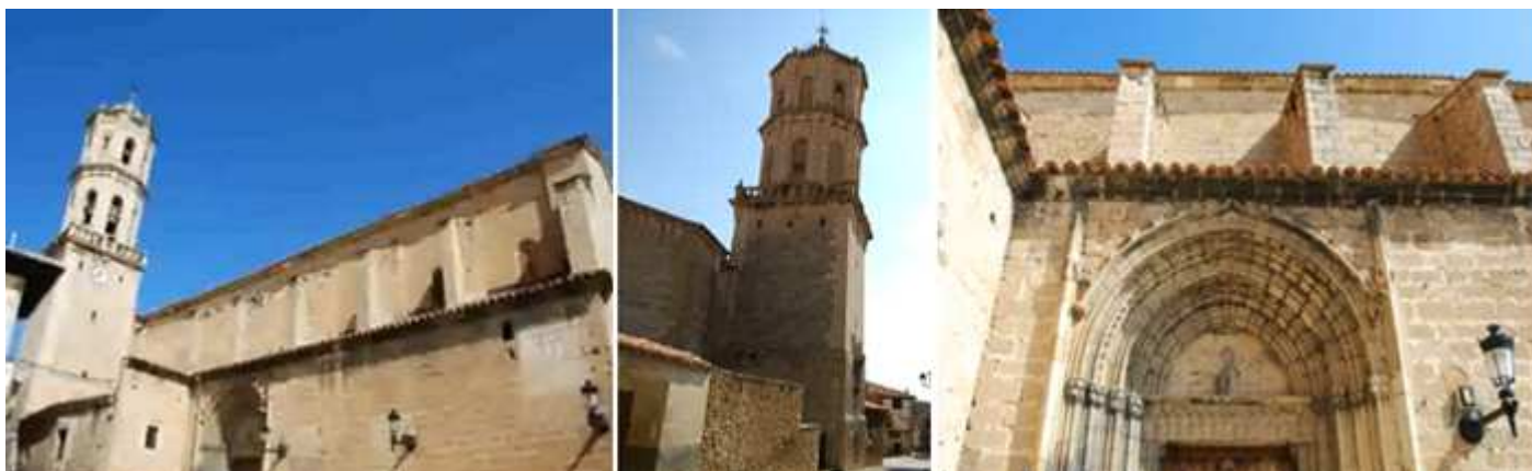
1 Iglesia de Mosqueruela con su esbelta torre y una magnífica portada aún faltándole el tímpano. 2 -Su torre de planta cuadrada en su primer cuerpo y dotada de una balaustrada para completarse con dos cuerpos más de planta octogonal abierto con ventanas para su campanario. 3 Su portada abocinada con la degradación de sus cinco arquivoltas.
