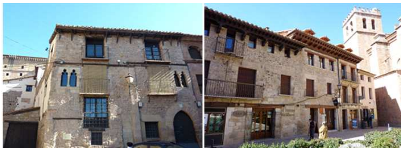
1 Casona con dos ventanas geminadas.
