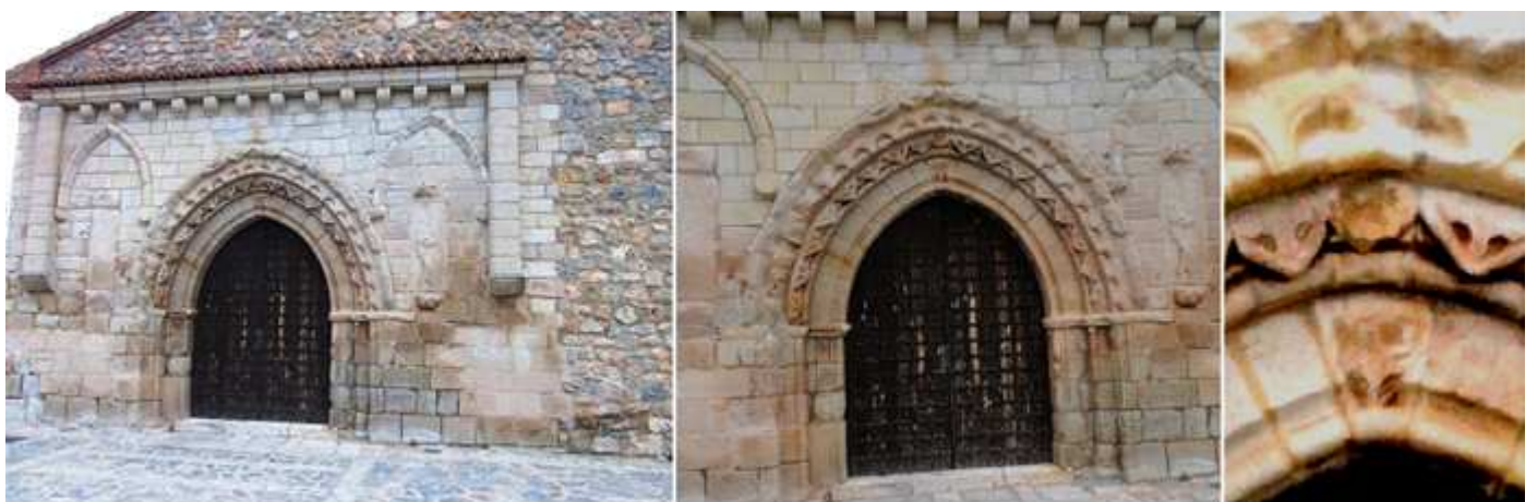
❶ Su portada con tres arquivoltas apuntadas que descansan sobre una imposta corrida, siendo lisa la interior con un baquetón en su borde, siendo las dos exteriores de dientes de sierra y lóbulos, mas el guardapolvo. Toda ella cubierta con alero con doce canecillos lisos curvos, y a los lados sendos guardapolvos apuntados donde estaban sendas imágenes hoy desaparecidas por la erosión. ❷ Portada de arco apuntado enmarcada con dos columnas adosadas a partir de ménsulas. ❸ Clave con una figura casi desaparecida en su puerta
