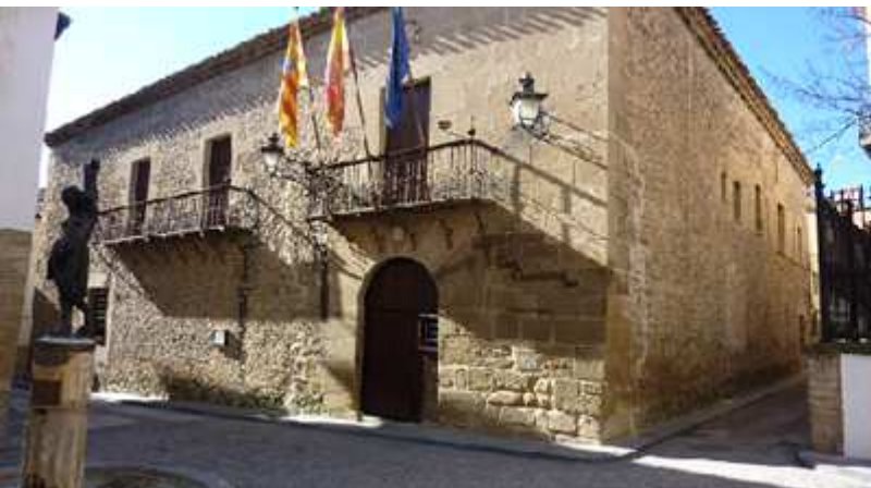
❶ Construido en piedra y cantería.
